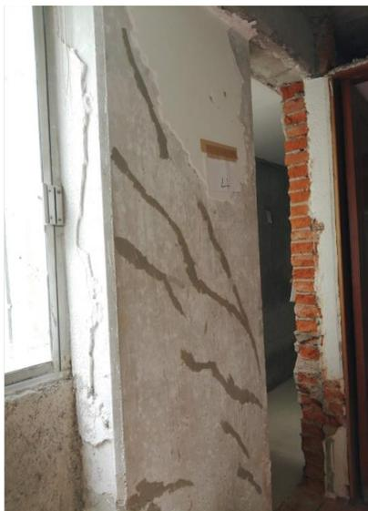
Figura 3.2.1. Columna reparada con inyección (archivo personal de Jorge Abarca, 2019)
