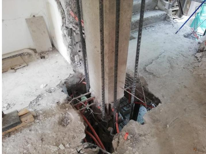
**Figura 3.2.4.1 Refuerzo longitudinal continuo a través de la losa de entrepiso**
