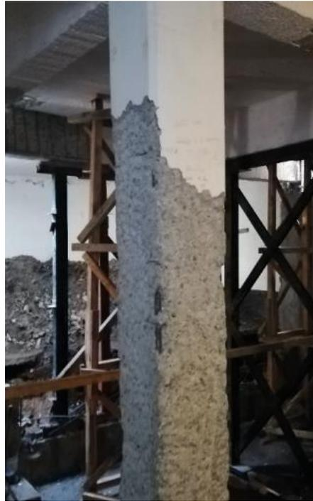
**Figura 3.2.3.1 Ejemplo de incremento de rugosidad de la superficie de una columna existente**
