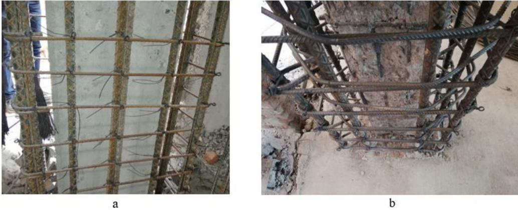
**Figura 3.2.4.5 Refuerzo de encamisados de columnas: a) práctica incorrecta: estribos con dobleces a 90 grados; b) práctica correcta: estribos con dobleces a 135 grados**
