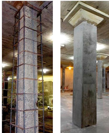
**Figura 3.1.1 Columna con encamisado no continuo**
