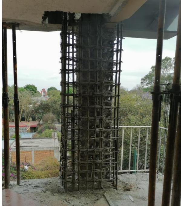
**Figura 3.1.2 Columna con encamisado continua a través de losas planas**
