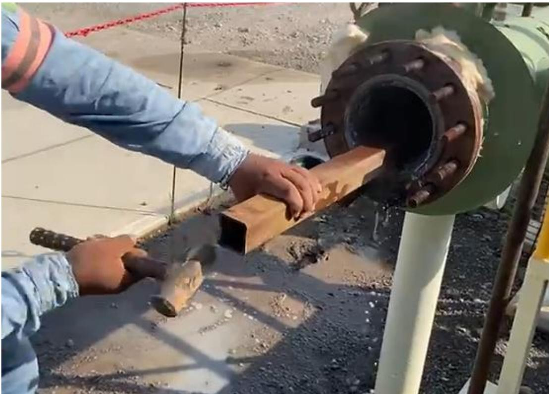
Figura 88. Retiro de incrustación en tubería.
