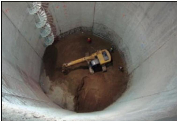
Imagen 2.5. Excavación en seco del núcleo.
