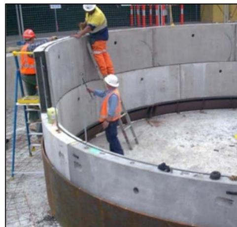
Imagen 2.3. Armado de anillos prefabricados.
