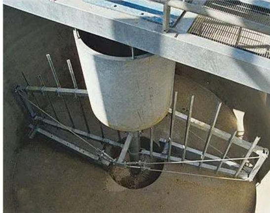
*Figura 141. Rastrillos de un espesador por gravedad*
