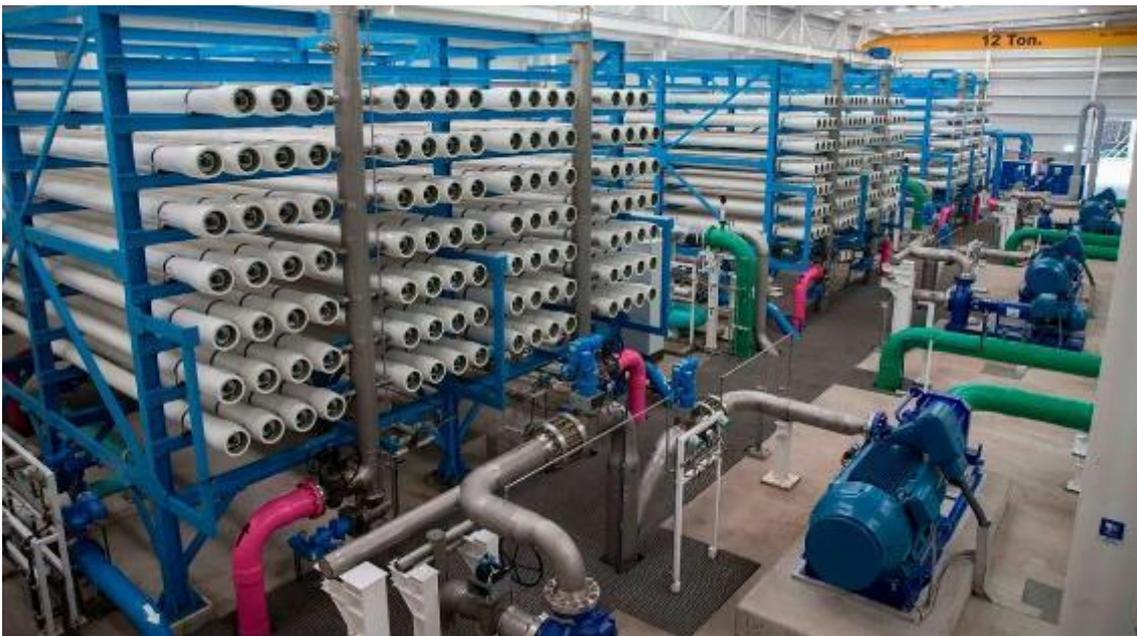
*Figura 137. Equipo para ósmosis inversa en planta desaladora de Ensenada, Baja California (El Economista, 2018).*
