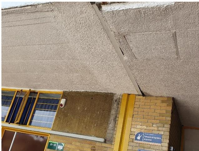
**Figura 4-7 Junta constructiva que separa el Edificio B con el Edificio C**
