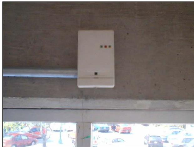
**Fotografía 5. 3:** Sensor de Ruptura de cristal ya instalado.
