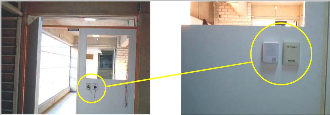
Fotografía 5. 11: Lectores TAG, antes de ser instalados y ya instalados, en la puerta de acceso.
