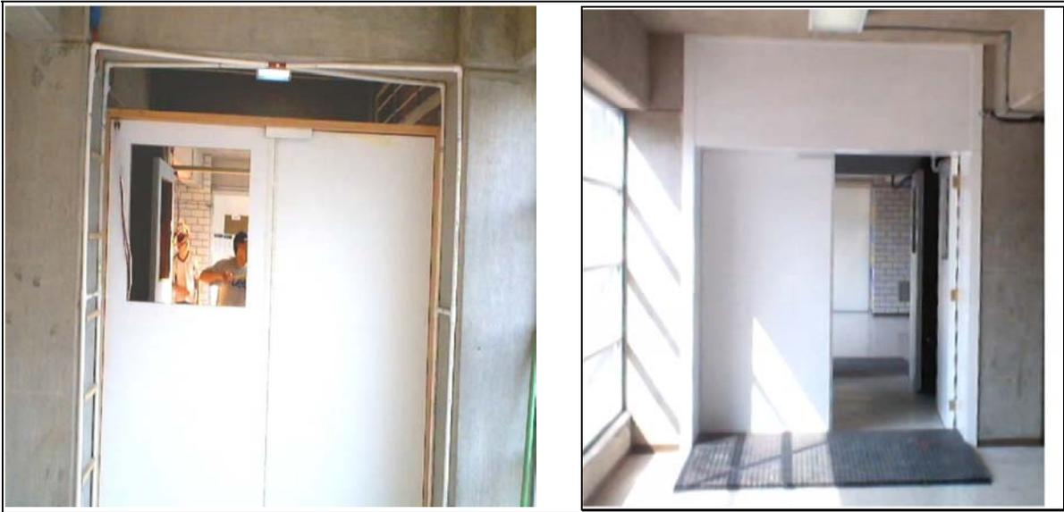
**Fotografía 4. 1:** Colocación de la antena de baja frecuencia inicial y presentación final de la puerta.
