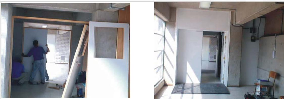
**Fotografía 5. 1:** Instalación y terminado de las puertas de acceso en la planta alta derecha (PAD).
