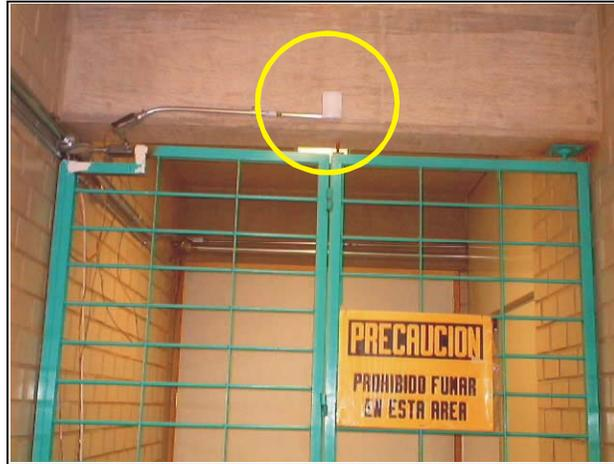
**Fotografía 5. 2:** Sensor de movimiento ya instalado.
