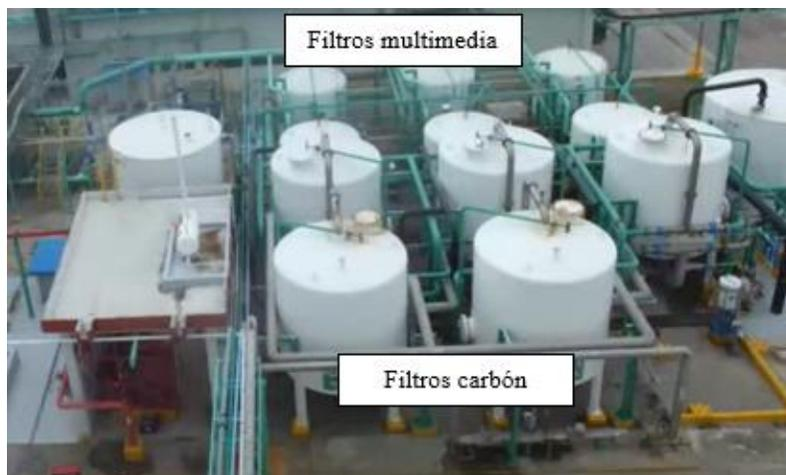
*Fig. (63). etapa de filtración, planta de tratamiento de aguas residuales de la refinería Madero (Cisneros, 2022)*
