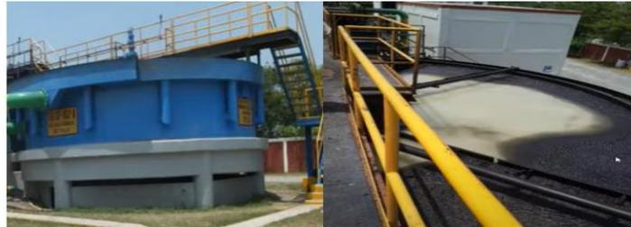
*Fig. (60).* Sistema DAF, planta de tratamiento de aguas residuales de la refinería Madero (Cisneros, 2022).
