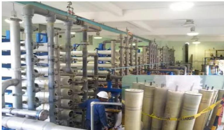
*Fig. (64). Etapa de ósmosis inversa, planta de tratamiento de aguas residuales de la refinería Madero (Cisneros, 2022).*
