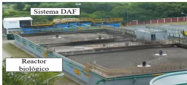
*Fig. (61).* Reactor biológico, planta de tratamiento de aguas residuales de la refinería Madero (Cisneros, 2022).
