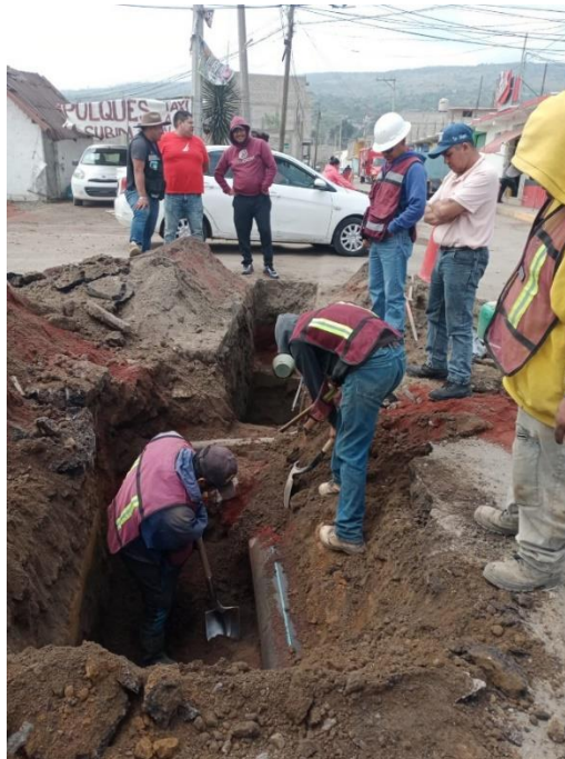
Figura 48 Elaboración de cala en av. Hernán Cortez
