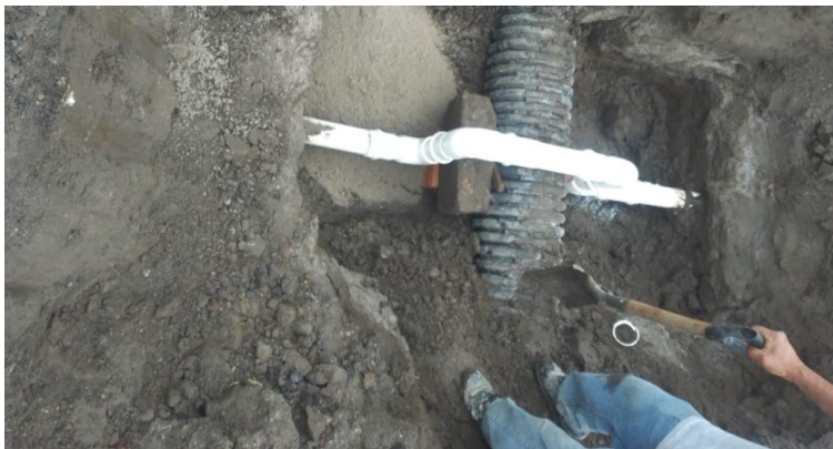
Figura 22 By-pass en línea de 3"
