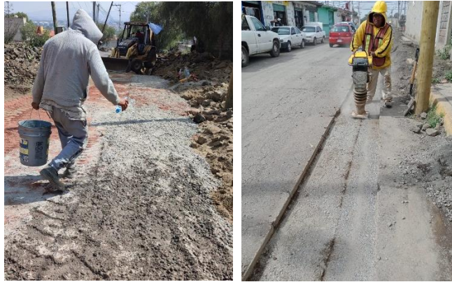
Figura 56 Relleno con grava-arena controlada
