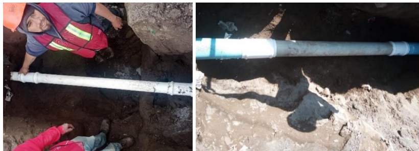
Figura 21 Reparaciones de tubo de agua de 3" y 6" respectivamente
