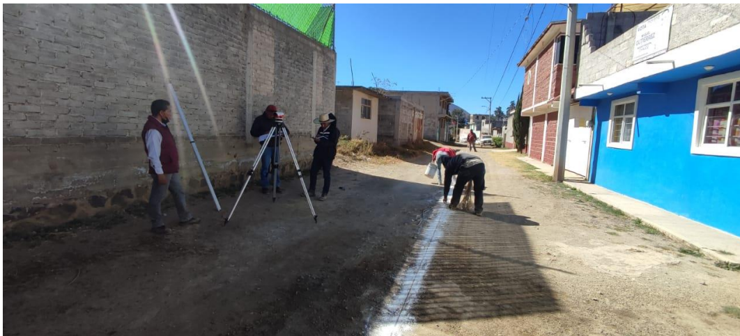
Figura 34 Revisión de niveles topográficos junto con la residencia de obra
