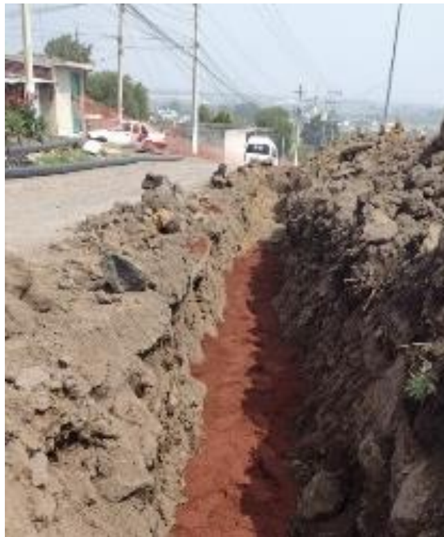
Figura 51 Encamado de arenilla
