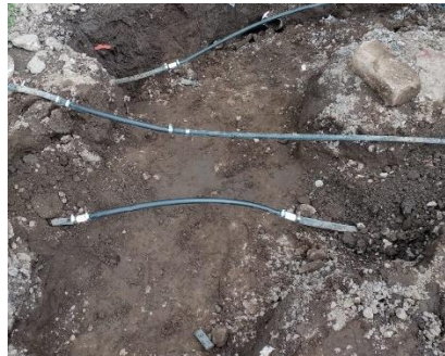
Figura 20 Reparaciones de tomas de agua
