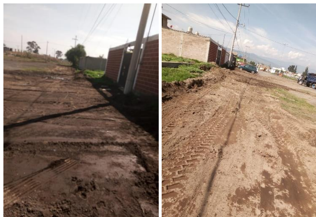
Figura 24 Fotografías avenida San Juan de Dios y San Francisco después de terminados los trabajos
