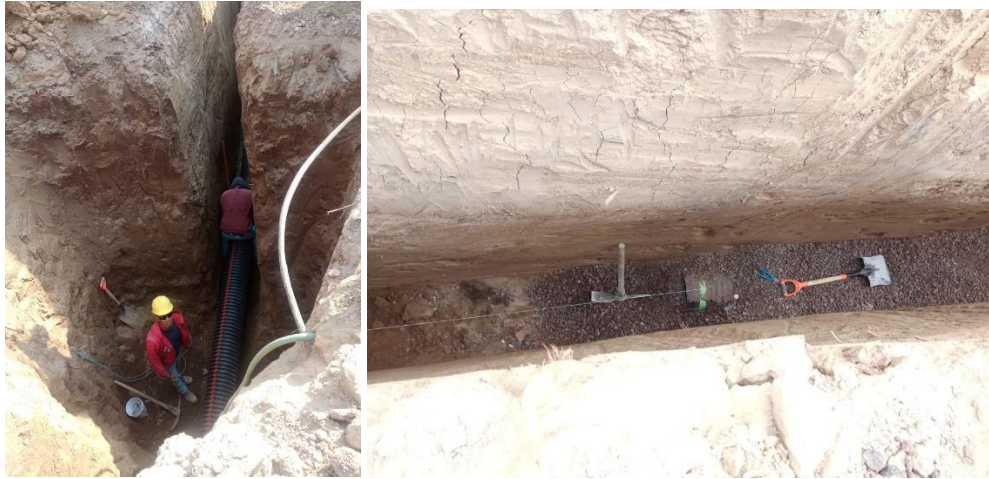
Figura 40 Instalación de tubería PEADC de 30 cm
