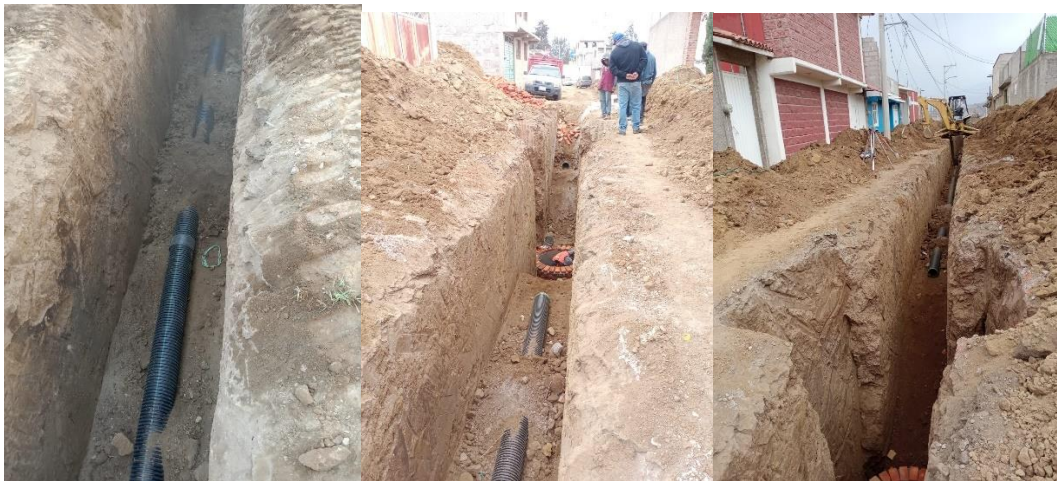
Figura 43 Colocación tubería madrina de 20 cm
