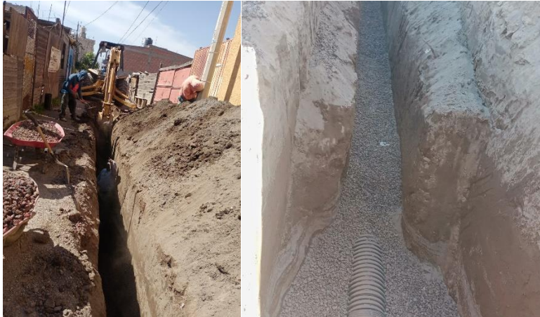
Figura 26 Instalación de tubería PEADC de 20 cm
