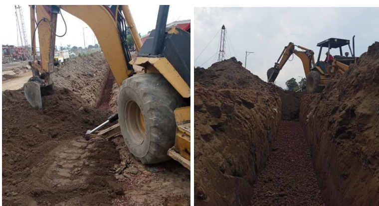
Figura 16 Relleno con material producto de la excavación
