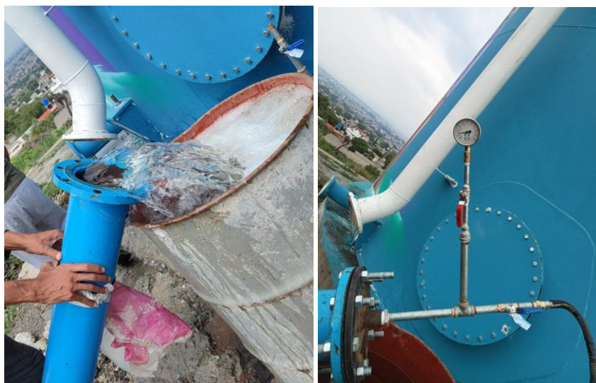
Figura 61 Llenado de línea y realización de prueba hidrostática
