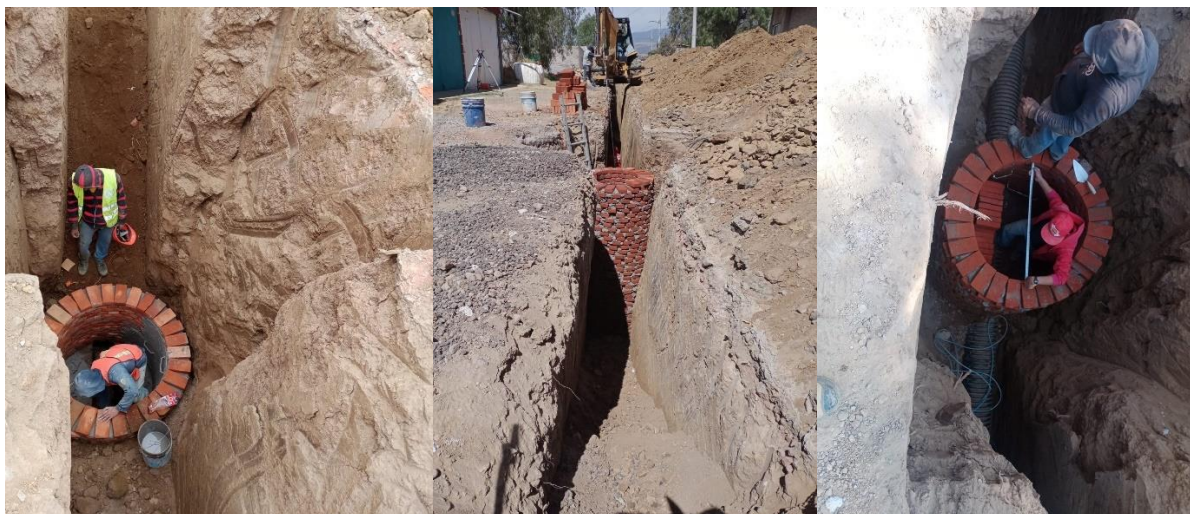
Figura 44 Elaboración de pozos de visita
