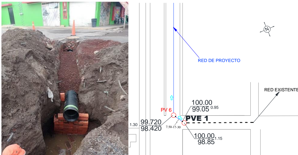
Figura 9 Interconexión a red existente
