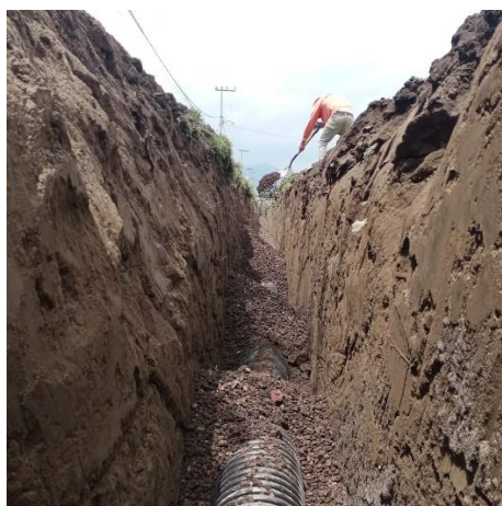
Figura 15 Acostillado de tubería
