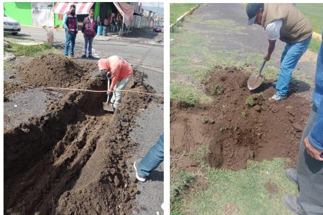
Figura 7 Elaboración de calas por medios manuales
