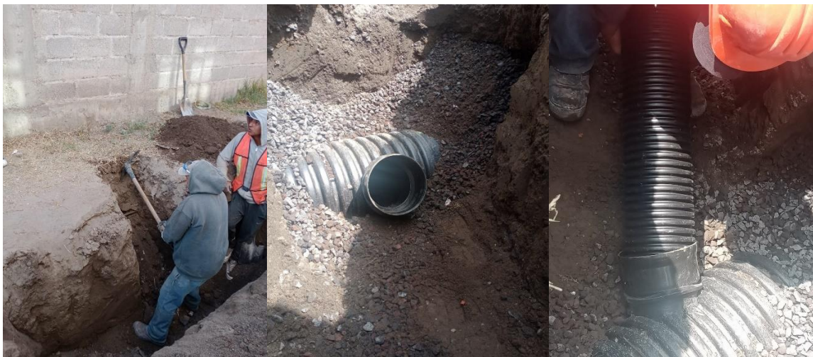
Figura 27 Excavación manual y elaboración de descargas
