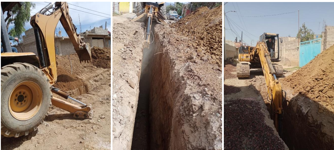
Figura 37 Excavación de 0.00 a 2.00 m, de 2.01 a 4.00 m y de 4.01 a 6.00 m
