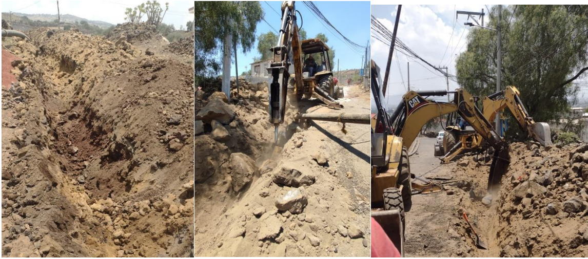
Figura 50 Trabajos de excavación en Ayotzingo colonia La Mesa
