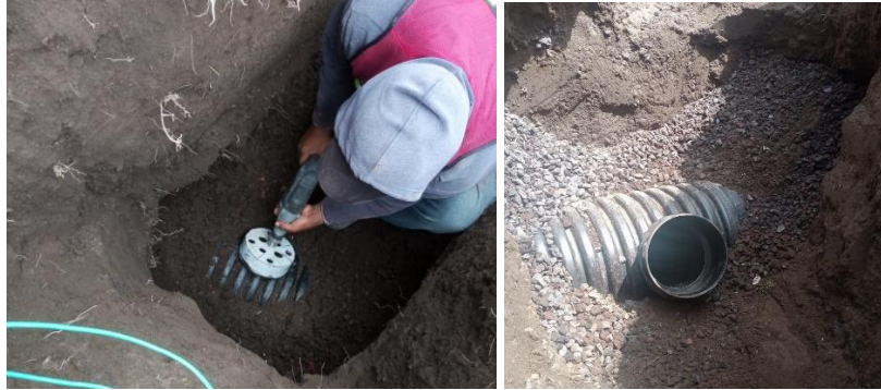
Figura 19 Perforación de tubo PEADC 30 cm para conectar descarga
