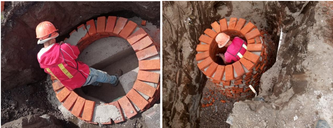
Figura 18 Elaboración pozo de visita común
