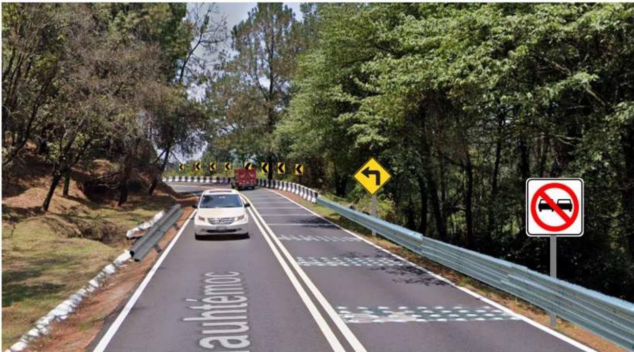
Propuesta de solución, el cual incluye la colocación de señalamiento vertical y barrera de protección.
