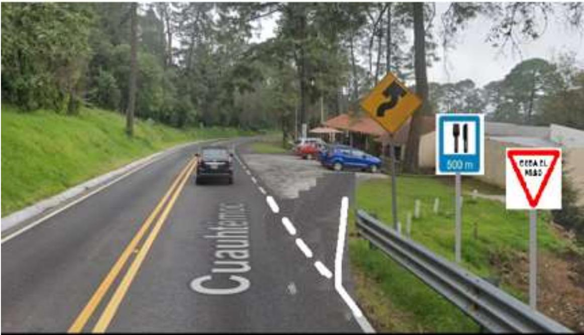
Propuesta de solución, el cual incluye: la eliminación del paso peatonal, así como la colocación de señalamiento vertical, colocación de barrera de protección y se debería realizar el análisis para que el acceso al establecimiento se encuentre a nivel y que no se encuentre forzado.
