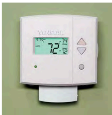
Figura 1 . 4 Termostato VENSTAR que permite el control de la temperatura ambiente
