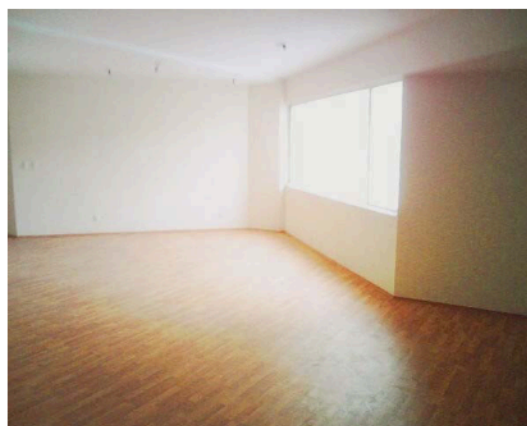
Figura 3 . 3 Estado del inmbueble 3
