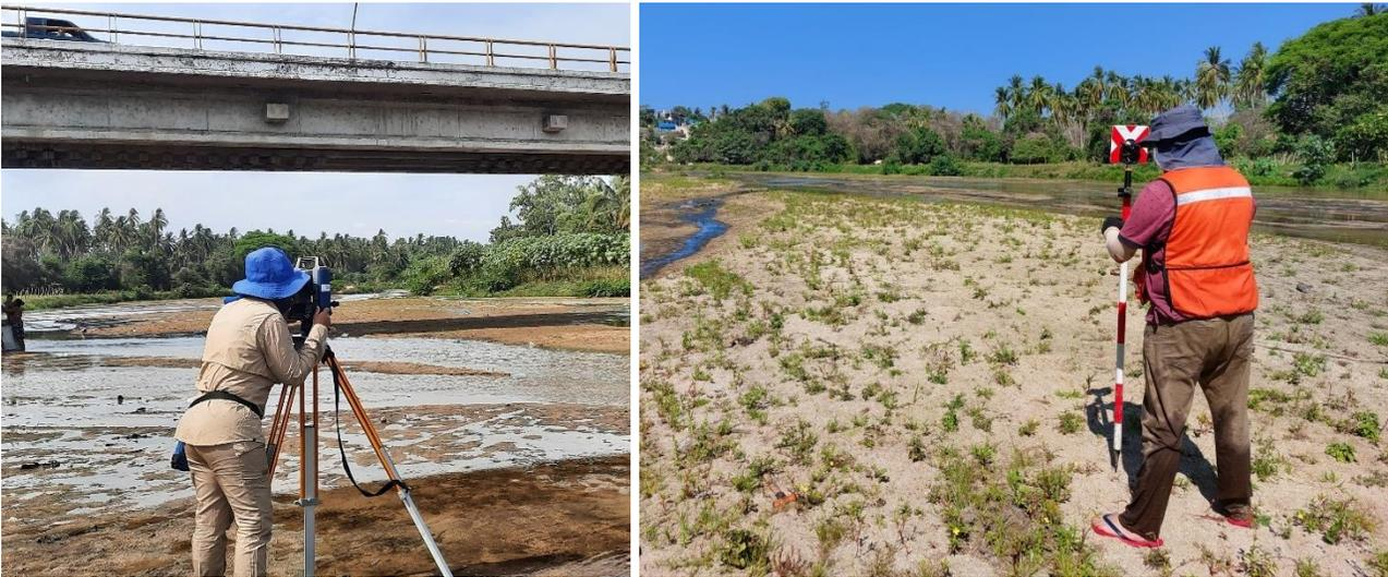
*Figura 7. Levantamiento con estación total. Elaboración propia.*
