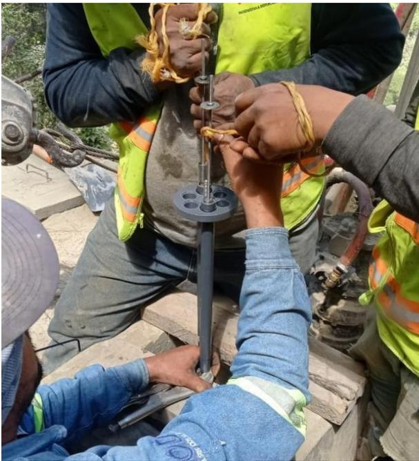
**Figura 27.** *Instalación del extensómetro - 1a a una profundidad de 9m.*
