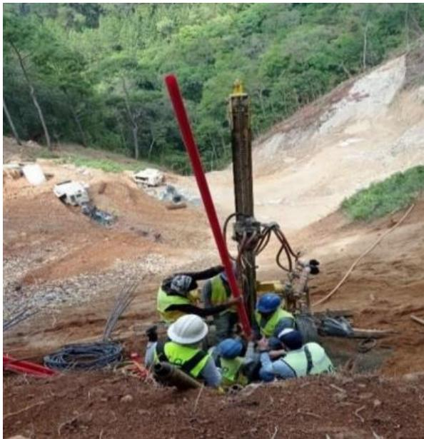
**Figura 24.** Instalación del inclinómetro
