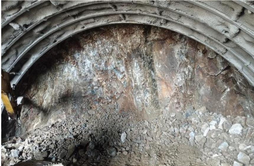
**Figura 11.** Falla normal con dirección prácticamente paralela al eje de túnel.
