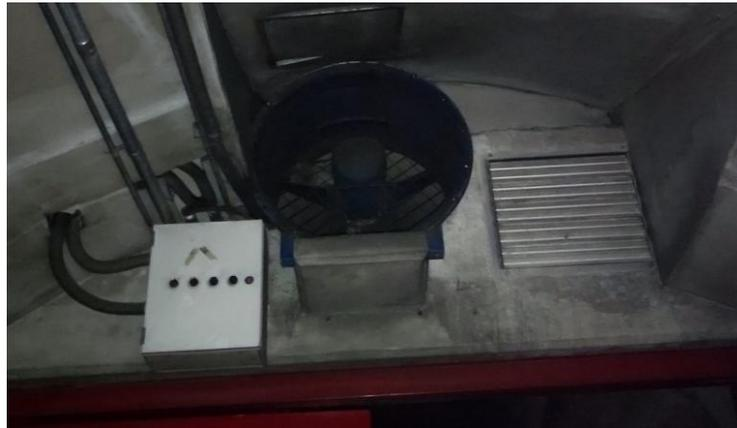
Imagen. Ventilador del sistema de presurización. Fuente: propia.
