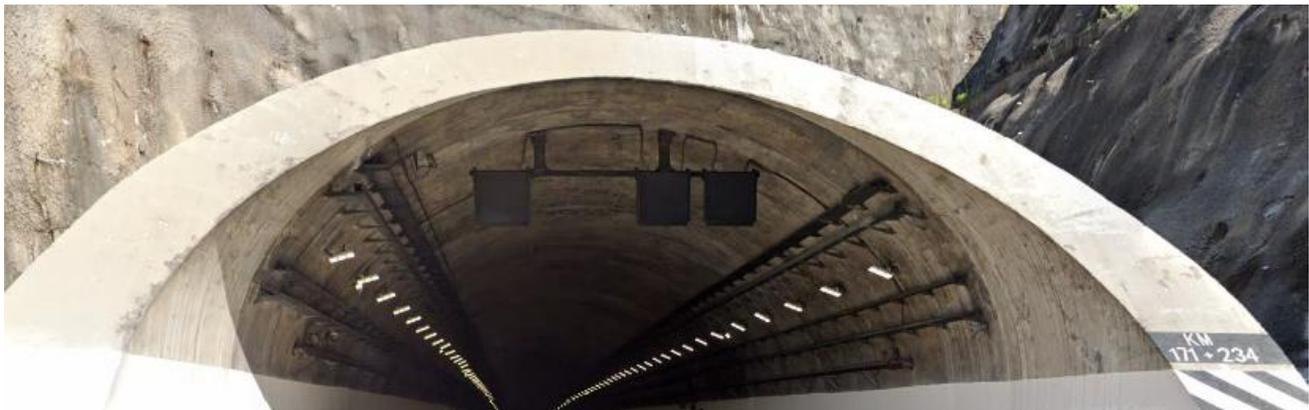
Imagen. Señales aspa-flecha colocadas en la bóveda del túnel. Fuente: Edgar Guevara.
