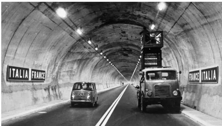
Imagen. Instalación de luminarias en el túnel Mont Blanc. Fuente: BBC.
