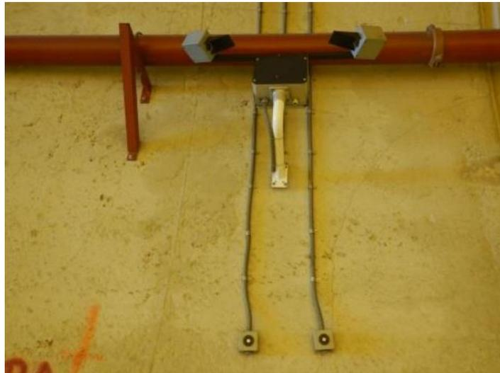
Imagen. Opacímetro instalado en el túnel principal. Fuente: Héctor Muñoz.
