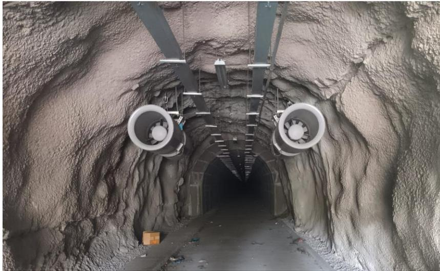
Imagen. Ventiladores del túnel auxiliar. Fuente: Javier Cabrera.
