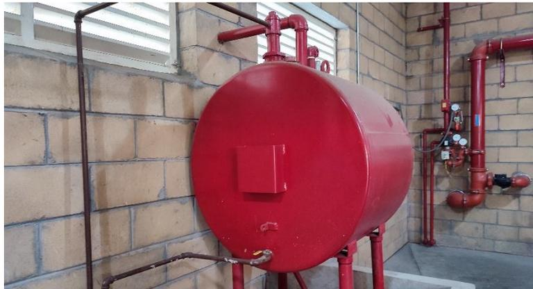
Imagen. Tanque de almacenamiento del diésel. Fuente: Héctor Muñoz.
