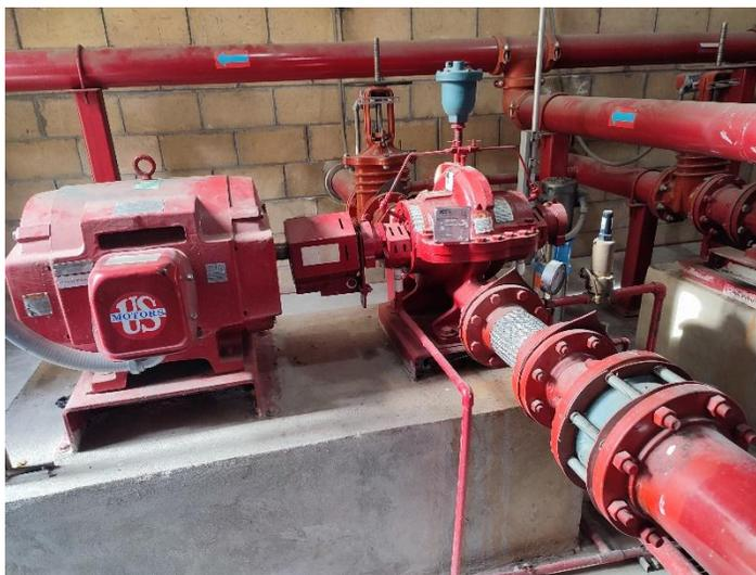
Imagen. Bomba eléctrica del cuarto de máquinas. Fuente: Miguel Echevarría.
