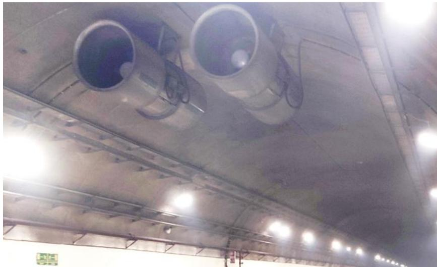
Imagen. Ventiladores gemelos instalados en la bóveda del túnel. Fuente: Propia.
