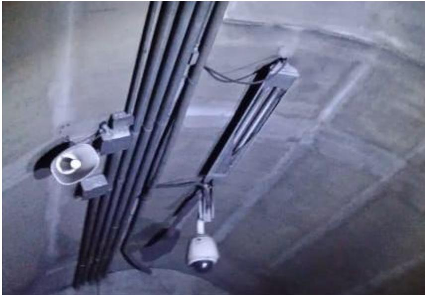
Imagen. Altavoz en la bóveda del túnel auxiliar. Fuente: Javier Cabrera.
