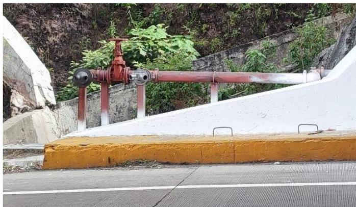
Imagen. Toma siamesa en el exterior del túnel. Fuente: Propia.
