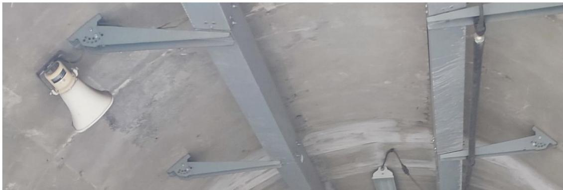
Imagen. Altavoz en el túnel auxiliar. Fuente: Javier Cabrera.
