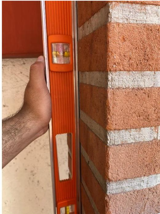
*Figura 10. Verticalidad sobre elementos estructurales.*
