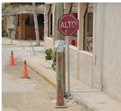
**Figura 3.13. Incumplimiento de altura y distancia lateral en señal SR-6 y mal mantenimiento**
