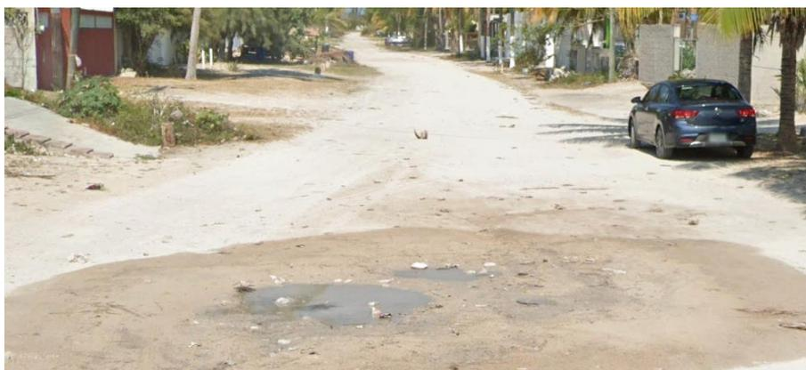
**Figura 3.20. Calle 15 carente de pavimentación y con presencia de baches**
