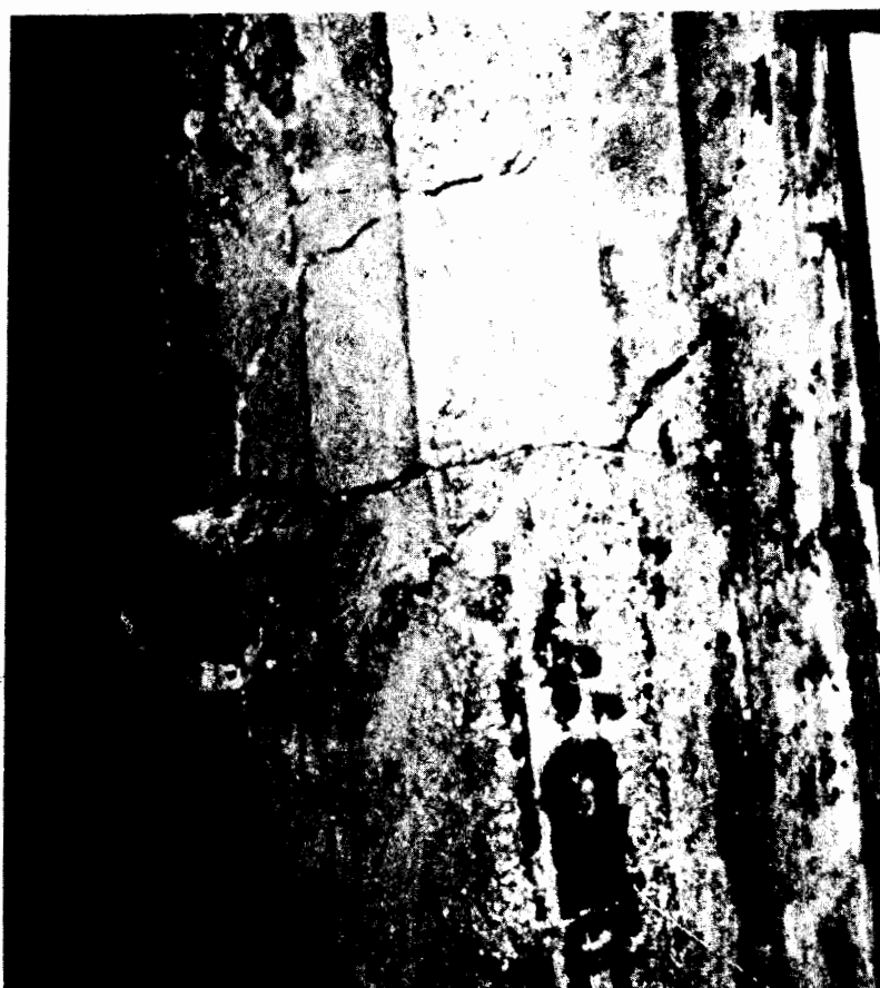
ROTURA POR FLEXION Y CORTANTE FAILURE DUE TO HIGH BENDING AND SHEAR
