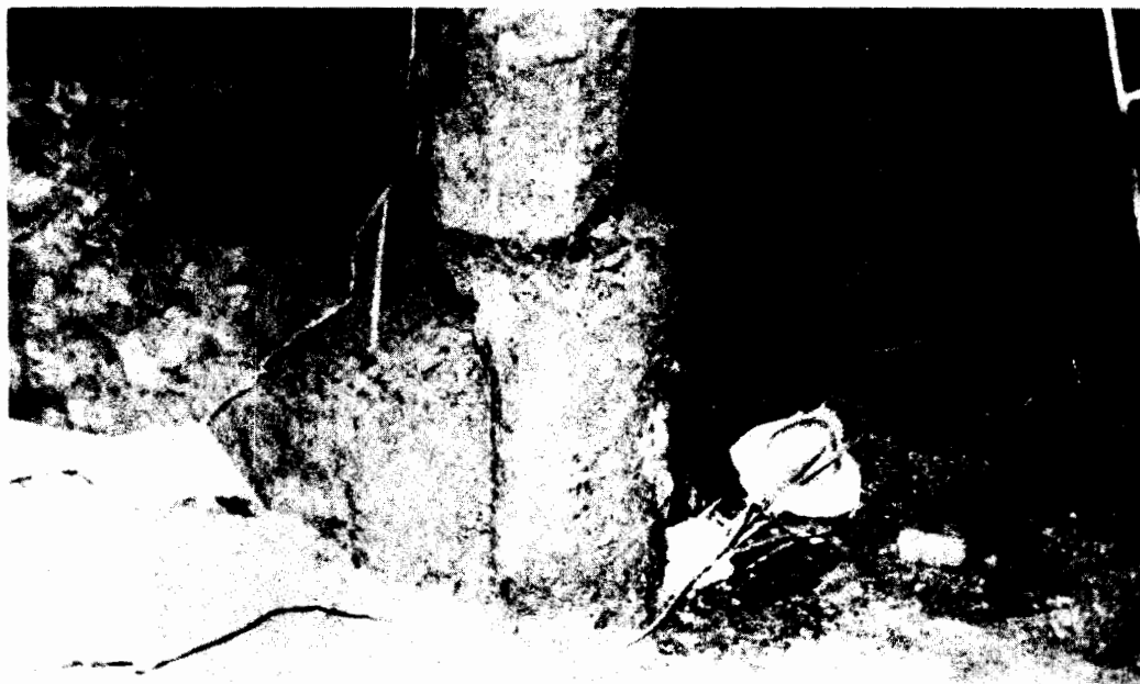
DESPLAZAMIENTO DE JUNTA POR FALTA DE REFUERZO JOINT DISPLACEMENT DUE TO LACK OF REINFORCEMENT
