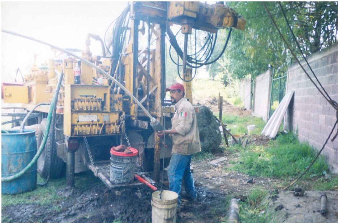
INSTALACIÓN DEL PIEZÓMETRO ABIERTO "TIPO CASAGRANDE"
