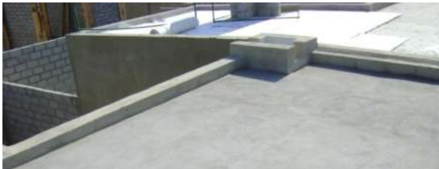
Ilustración 55 Aislamiento térmico en losas de concreto con placa de poliestireno expandido de 1.5" de espesor, densidad 15 kg/m 3
