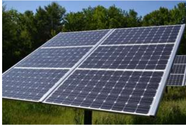
Ilustración 36 Conjunto de paneles fotovoltaicos
