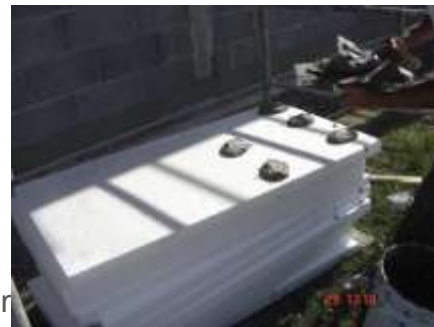
Ilustración 48 Aplicación de basecoat en montículos
