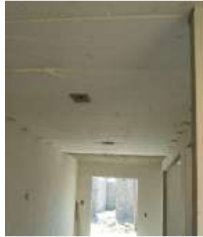
Ilustración 57 Vista interior de Losa integral con EPS en vivienda.
