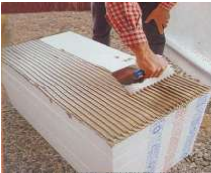
Ilustración 49 aplicación de basecoat con llana dentada
