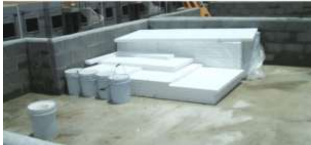
Ilustración 45 material y herramienta para instalación de aislamiento térmico
