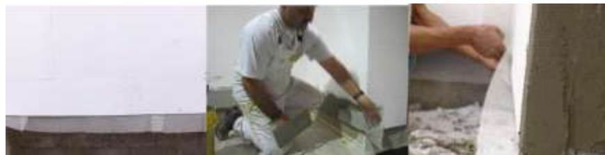
Ilustración 58 Tira de malla de fibra de vidrio de 20 cm para envolver las placas inferiores.
