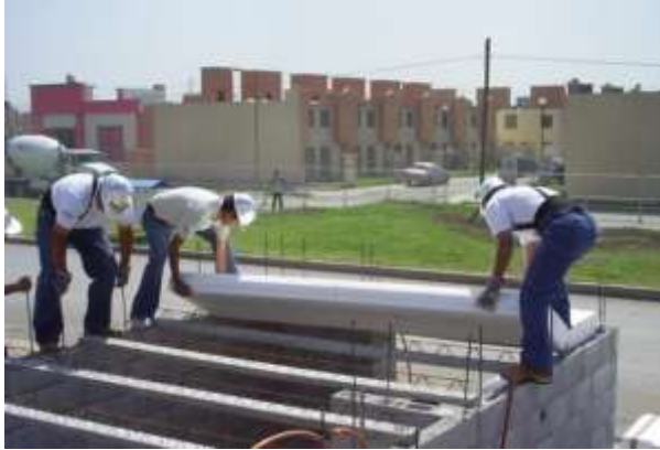
Ilustración 53 Instalación de bovedilla estándar en losa de vivienda.
