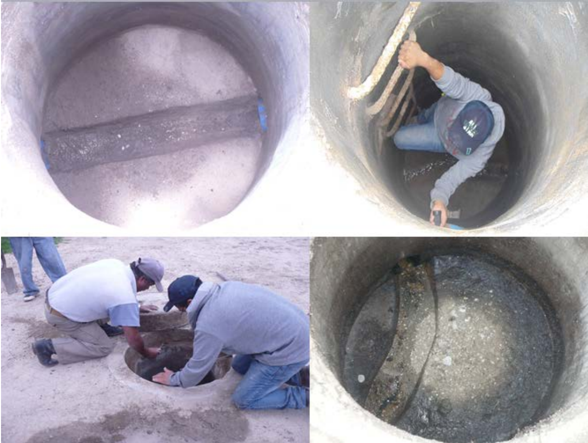
FIGURA 6 APERTURA Y REVISIÓN DEL DRENAJE.
