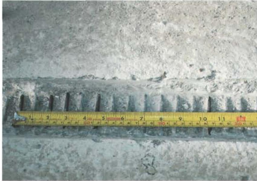
Figura 2.30: Medición y localización de cables con discontinuidades (Callejas, 2011).
