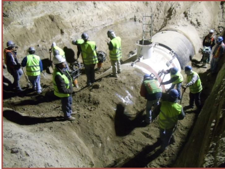
Figura 3.24: Colocación de relleno (GIT, 2013).
