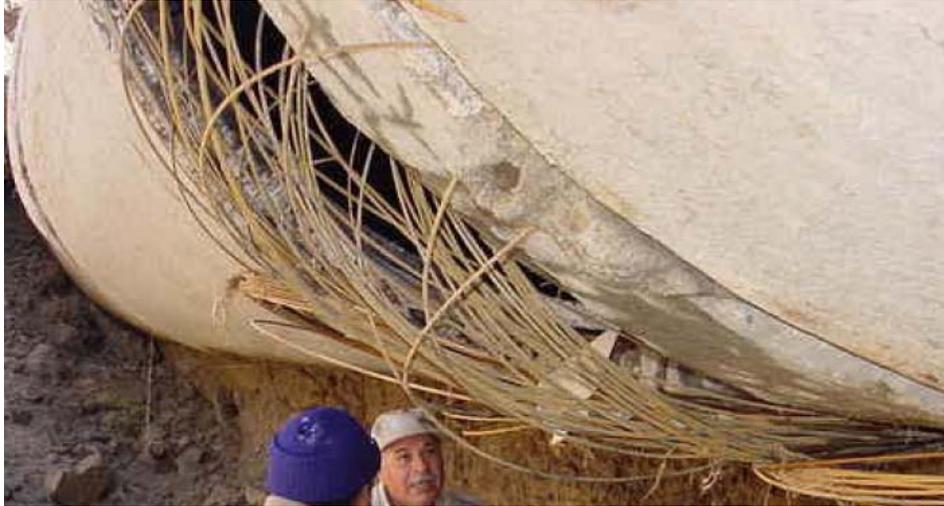
Figura 2.22: Espiras de presfuerzo rotas por la acción de la corrosión (León, 2004).
