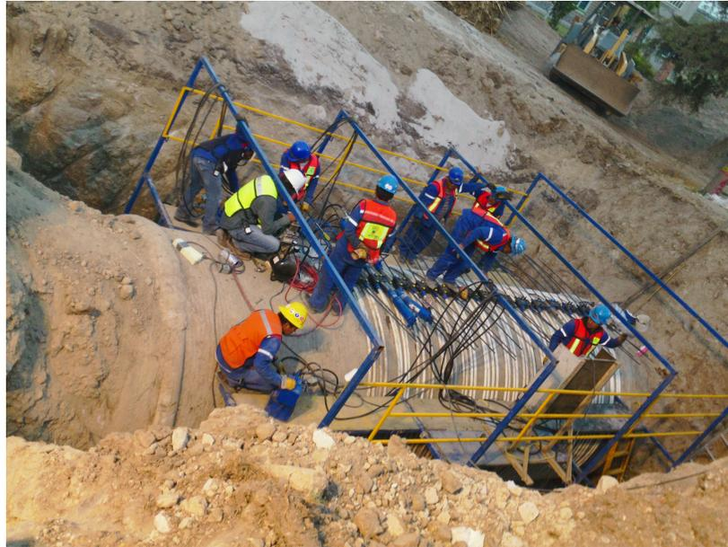
Figura 3.33: Tensado final de torones. Fuente: autoría propia.
