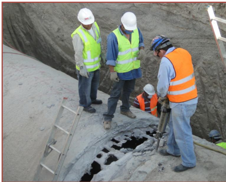
Figura 3.12: Demolición de tubo con equipo neumático (GIT, 2013).
