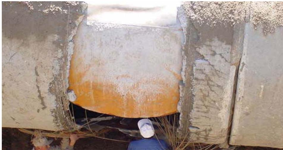
Figura 2.23: Falla local en la tubería enterrada (León, 2004).
