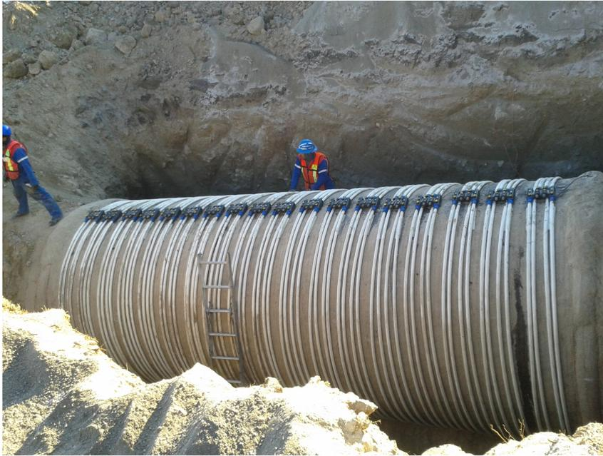
Figura 3.26: PCCP con reforzamiento externo Freyssinet. Fuente: autoría propia.
