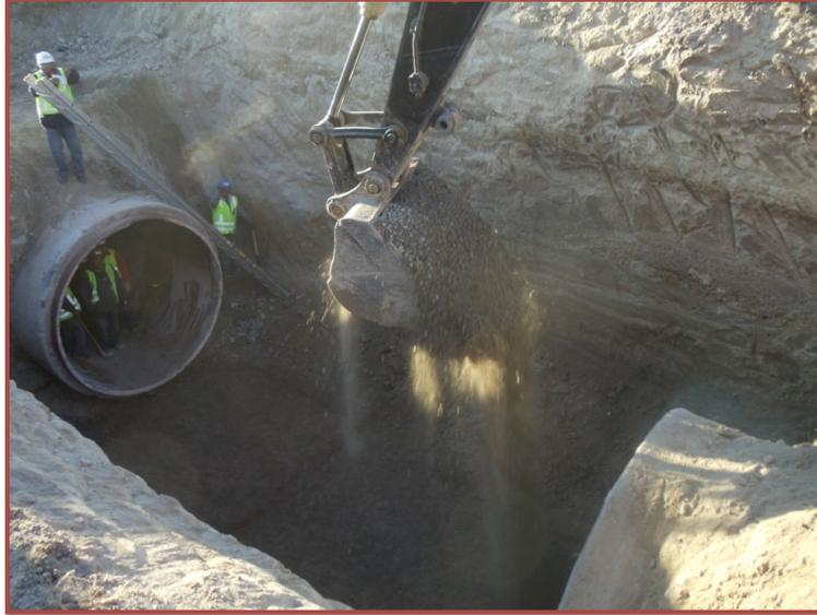
Figura 3.21: Colocación de grava (GIT, 2013).
