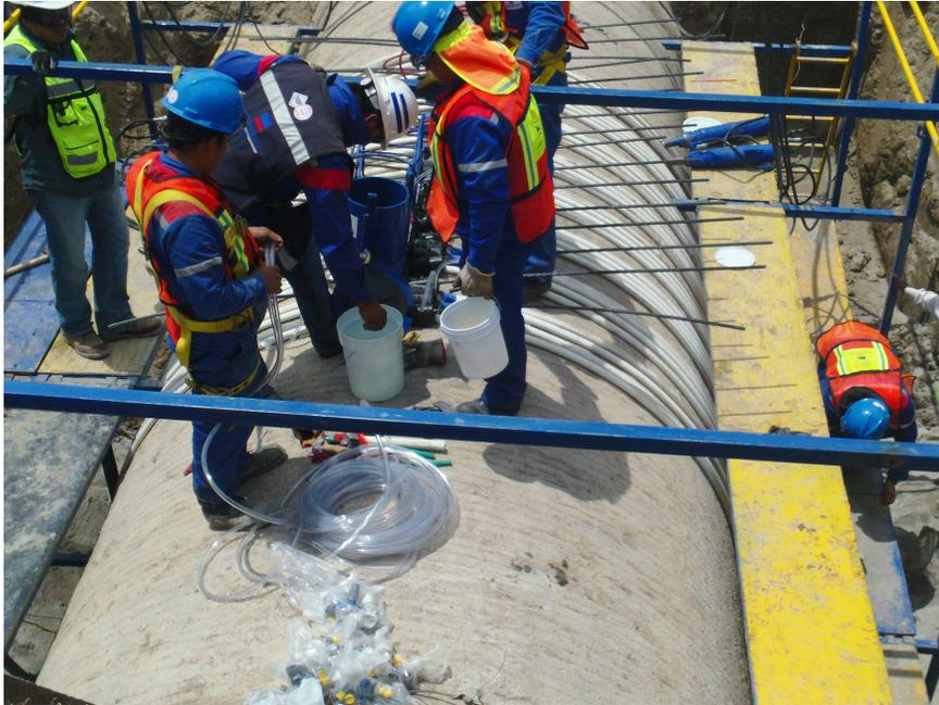
Figura 3.32: Inyección de resina epóxica. Fuente: autoría propia.
