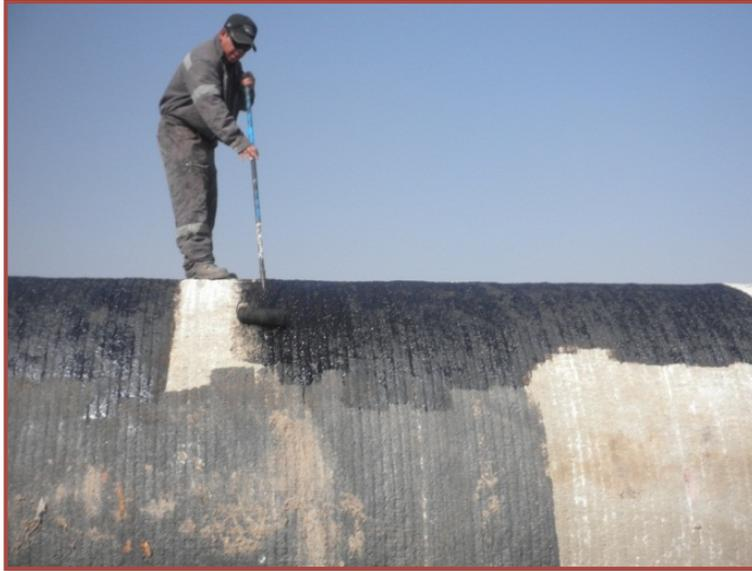
Figura 3.16: Aplicación de pintura en las piezas especiales (GIT, 2013).
