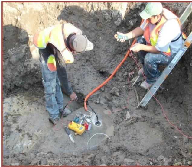
Figura 3.20: Instalación de la protección catódica (GIT, 2013).
