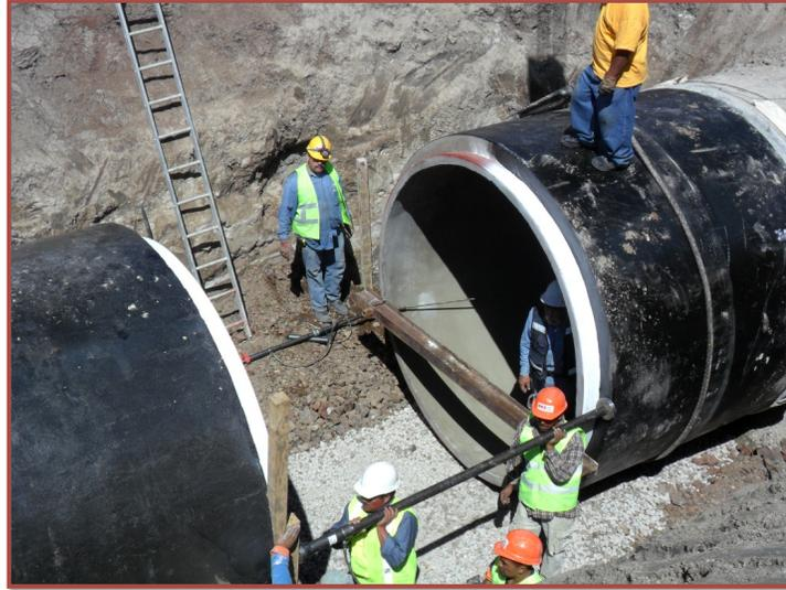
Figura 3.18: Colocación de tensores de acero (GIT, 2013).
