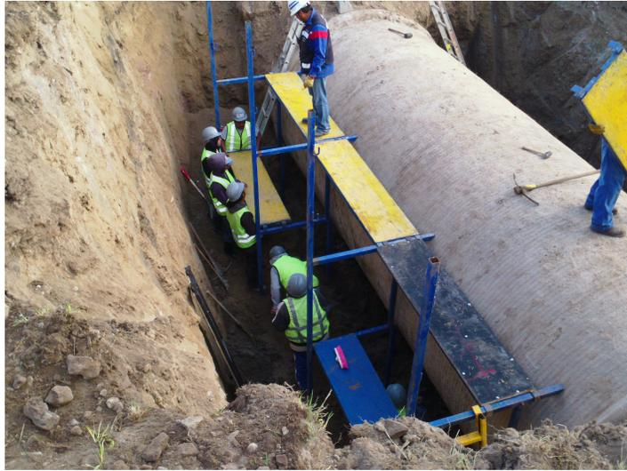
Figura 3.27: Armado de plataforma. Fuente: autoría propia.
