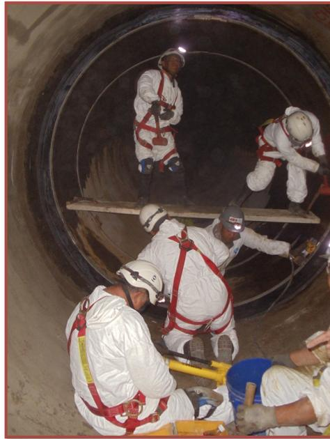
Figura 3.19: Colocación de sellos metal plástico (GIT, 2013).
