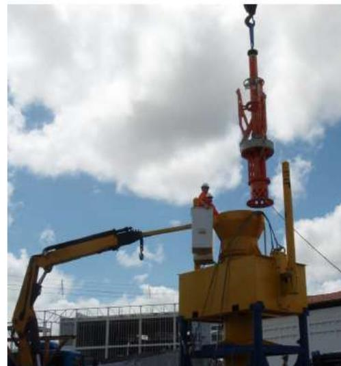
Figura 4. 10 Colocación del sistema de succión.<sup>25</sup>
