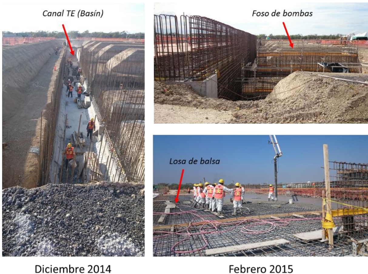
Figura 36 Fundaciones Torre de Enfriamiento 47
