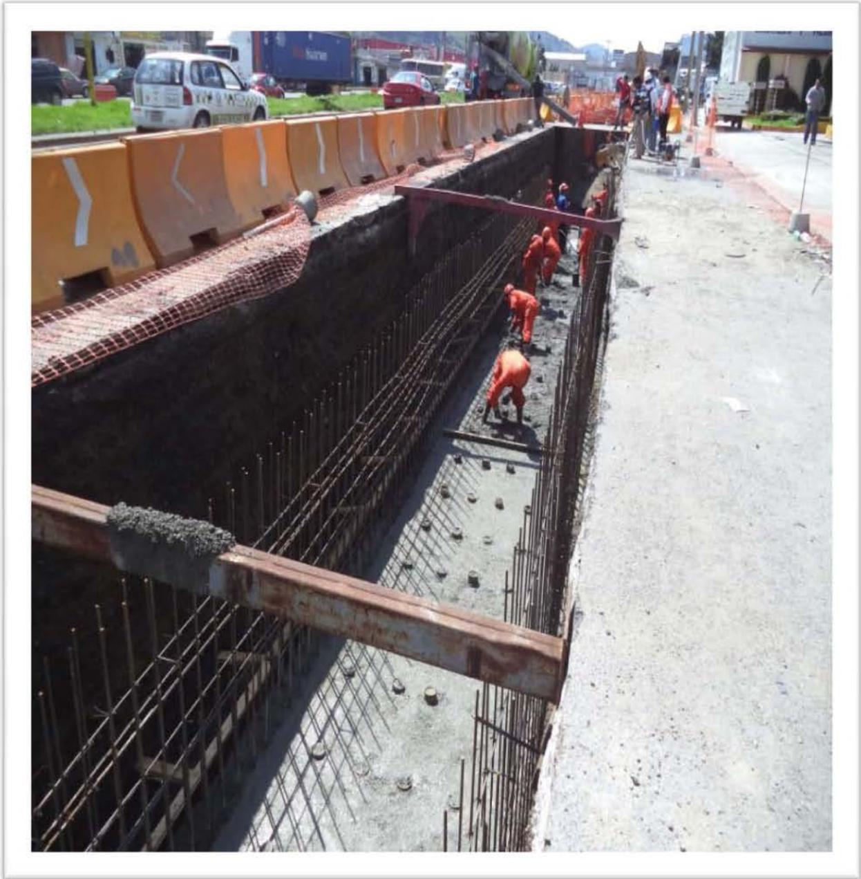
Fig. 4.7. "Habilitado de acero de refuerzo"
