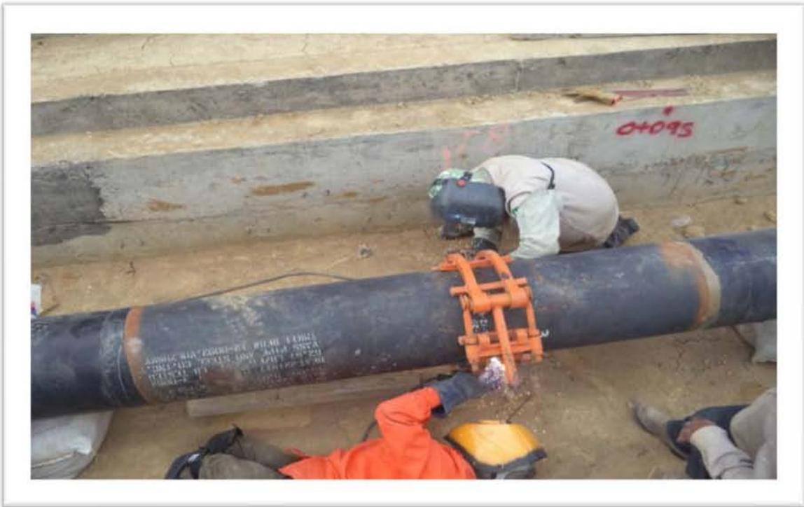
Figuras 4.11. "Soldadura en Acero al Carbón"
