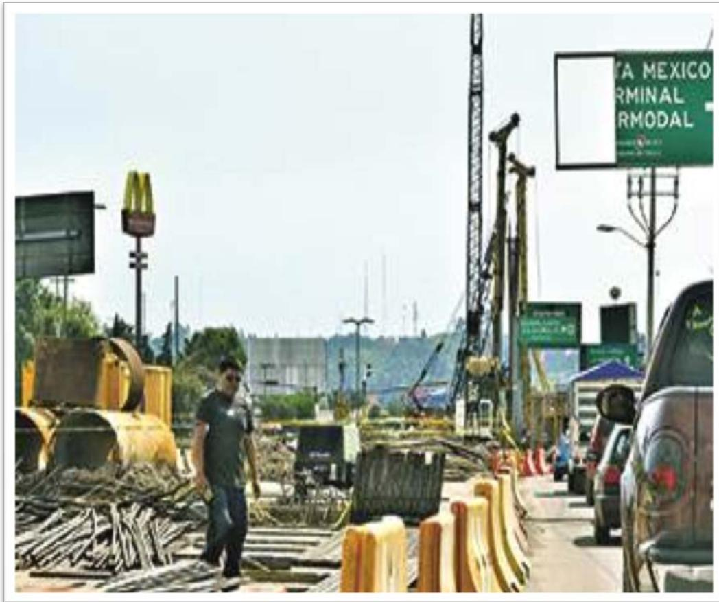
Fig. 2.7 "Fotografía de Perforación de Pilotes"
