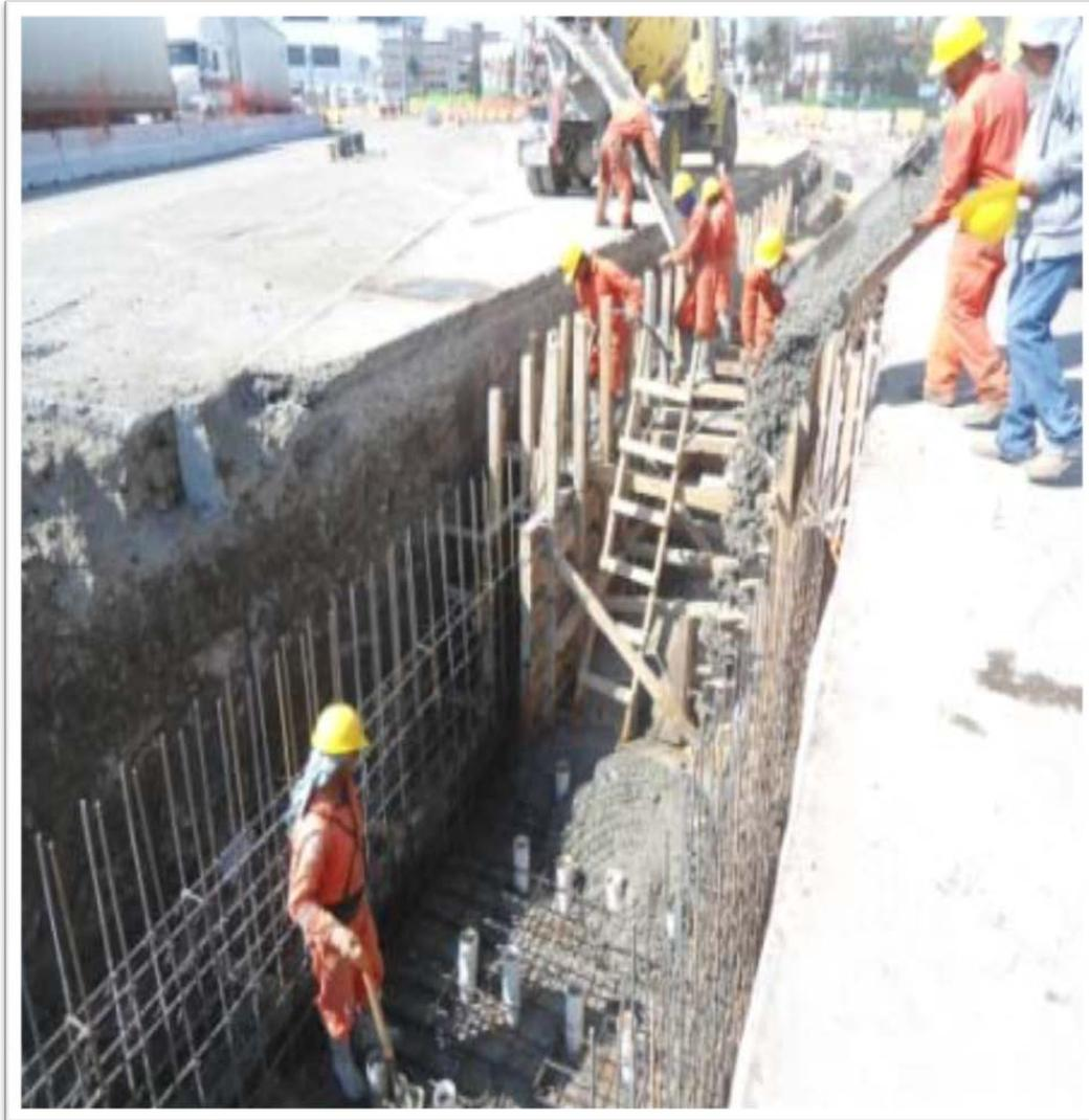
Fig. 2.21 “Armado, cimbrado y colado de trinchera”
