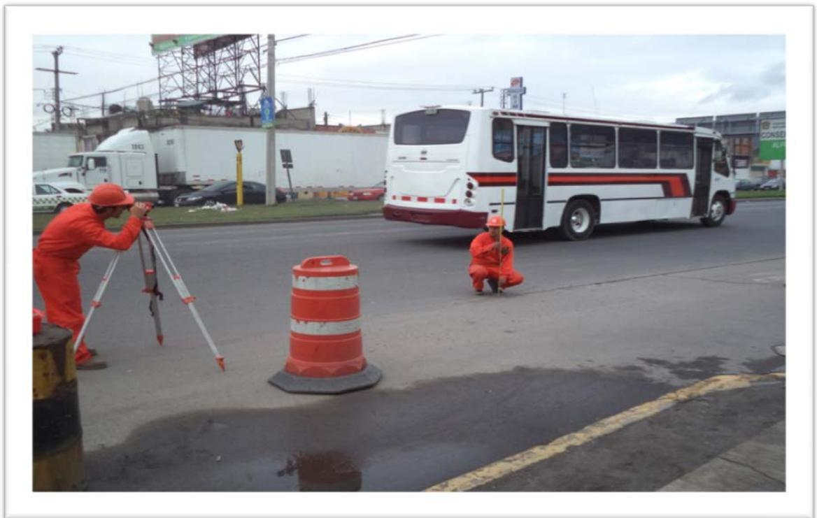
Figuras 4.1. “Trabajos de Trazo y Nivelación”
