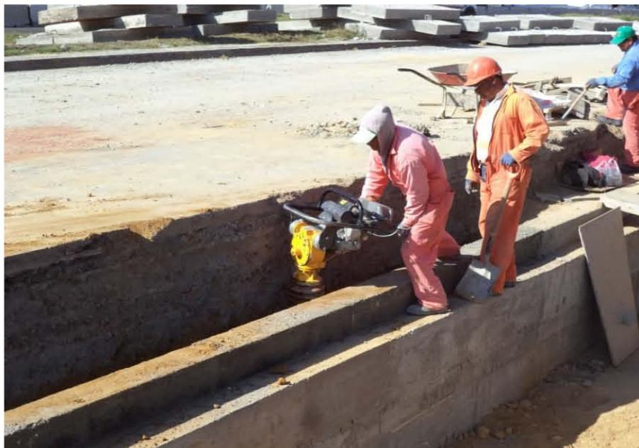
Fig. 4.21. "Relleno Exterior de sobre excavación"
