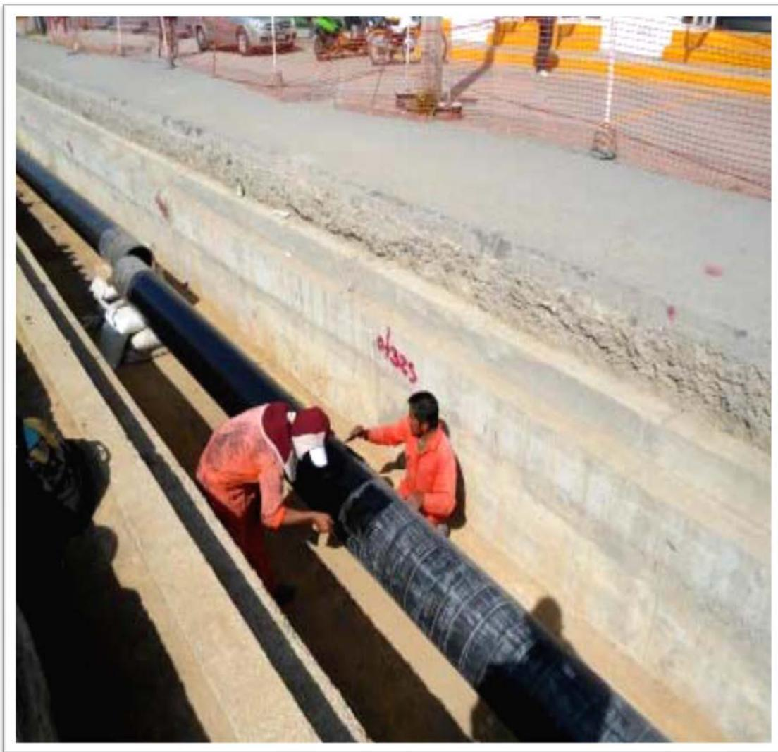
**Fig. 2.25. “Colocación de recubrimiento mecánico Ram100, fabricación, tendido, colocación e instalación de tubería”**
