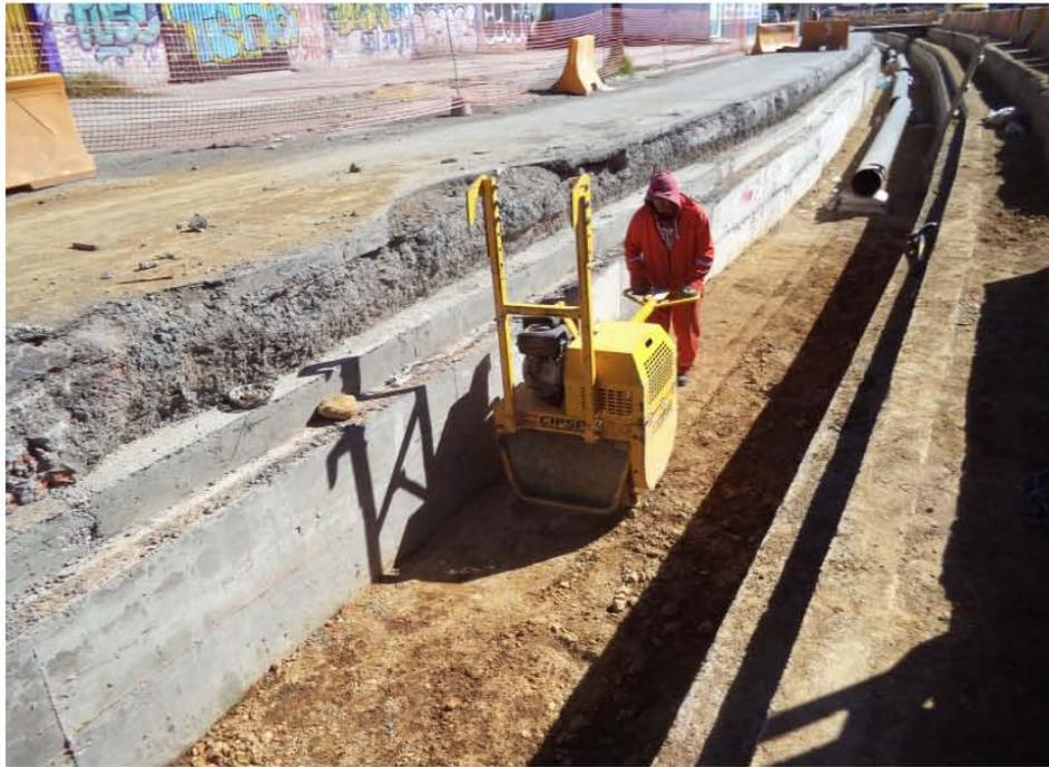
**Fig. 4.22. "Relleno de interior de trinchera"**
