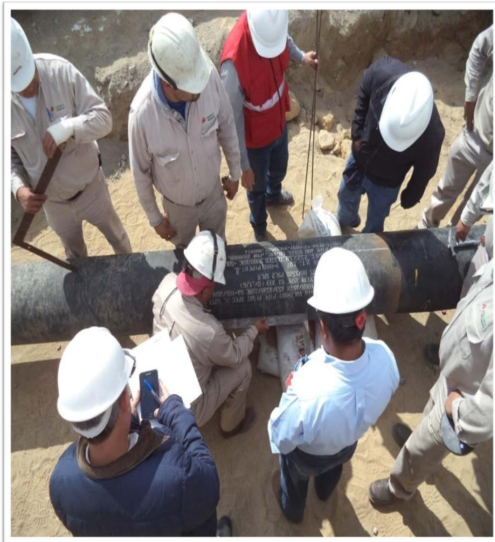
Fig. 2.28. “Revisión de Supervisión de Pemex de Grados de Curvatura”
