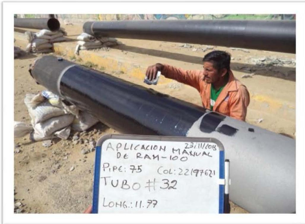
Fig. 4.16. "Aplicación de Recubrimiento Ram 100"
