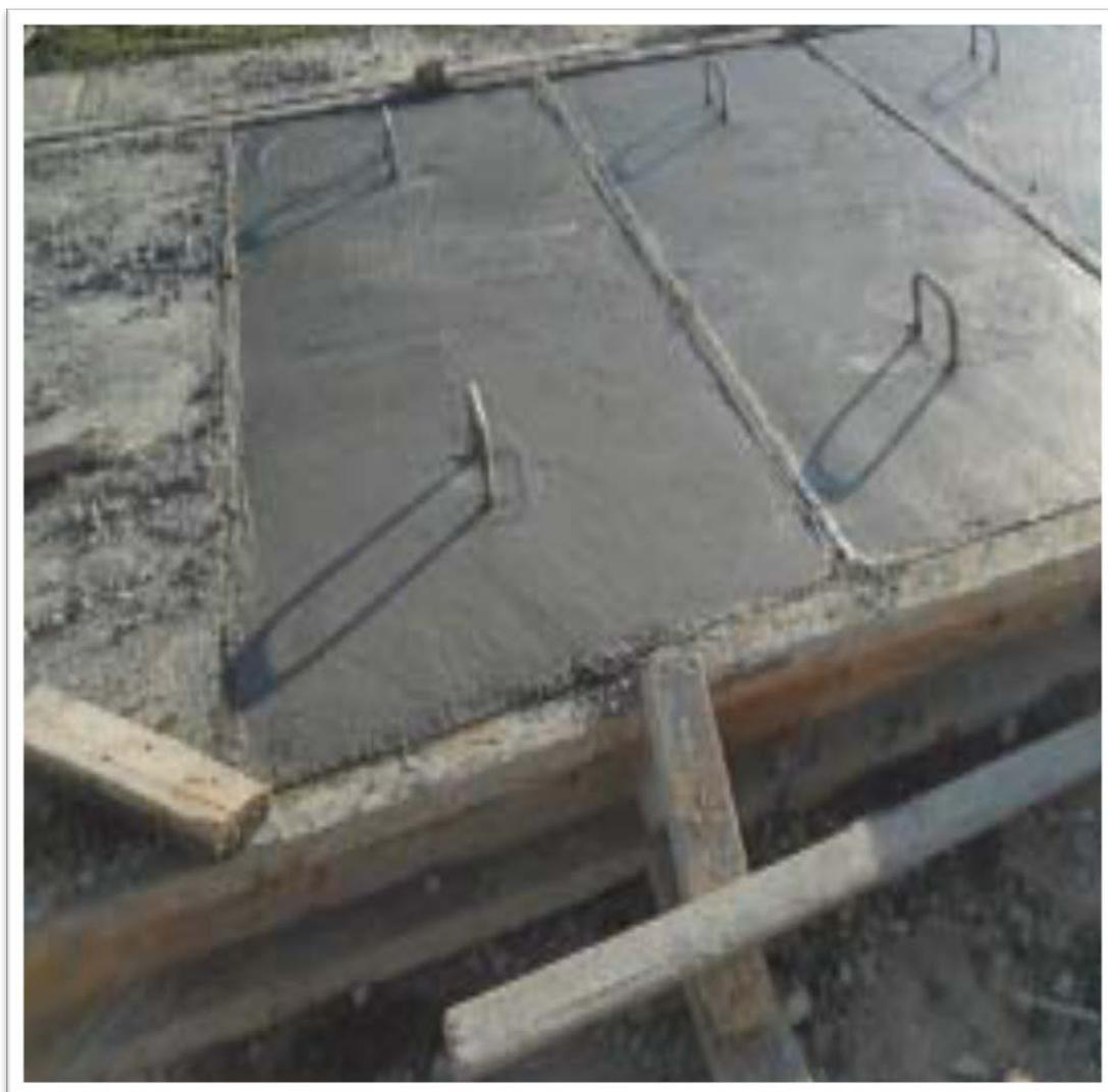
**Fig. 2.23 “Armado, cimbrado y colado de tapas de trinchera”**
