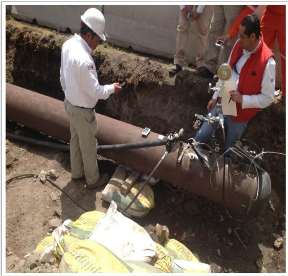
Fig. 2.27. “Personal de Supervisión por parte de Pemex, revisando pruebas de hermeticidad”
