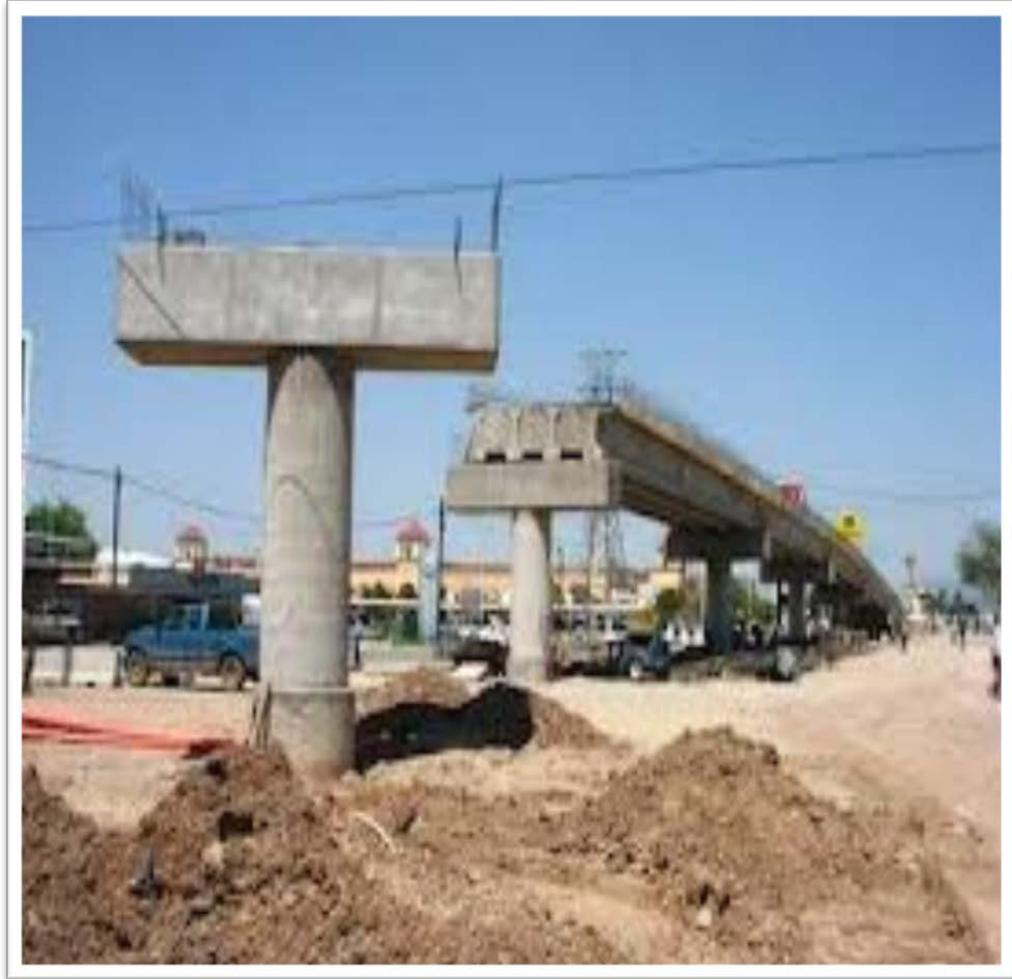
**Fig. 2.17 “Colocación de Traveses”**
