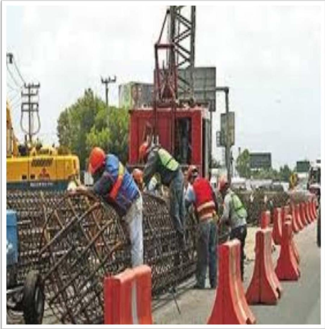
Fig. 2.8 "Fotografía de armado de Pilotes"
