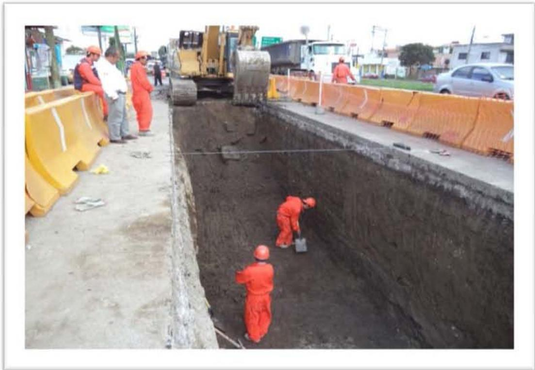
Figuras 4.4 . “Excavación con Maquinaria”
