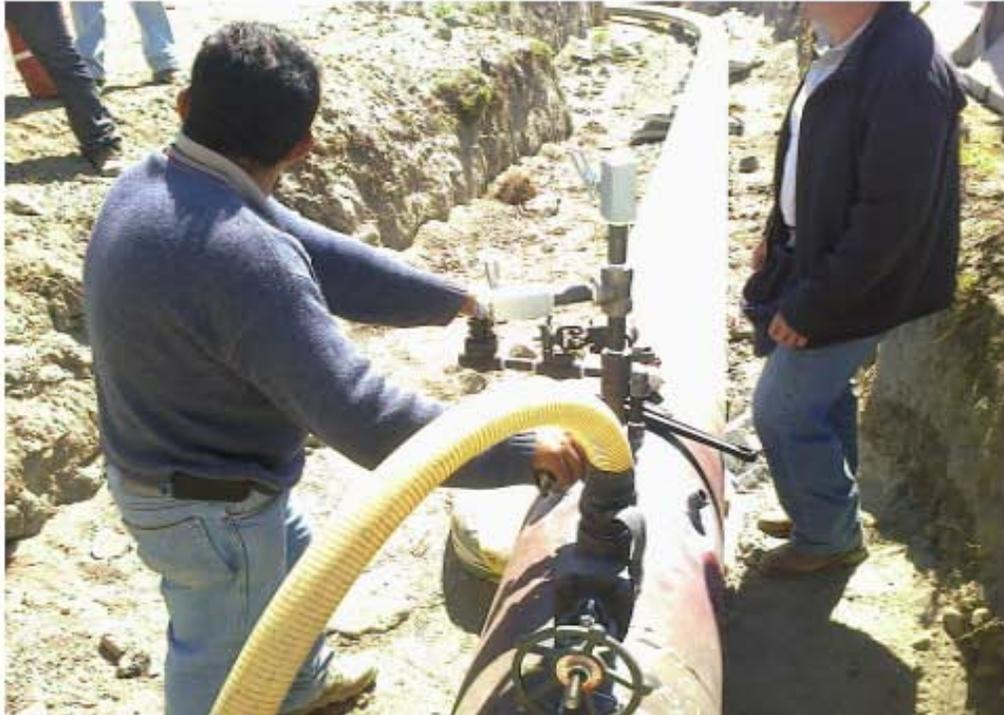
Fig. 4.18. "Prueba Hidrostática"
