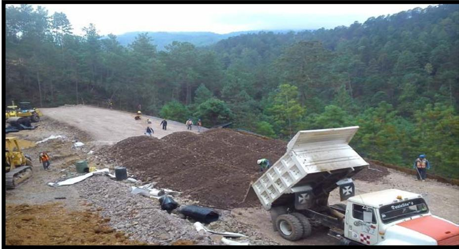
Imagen IV.18. Colocación de capas subsecuentes
