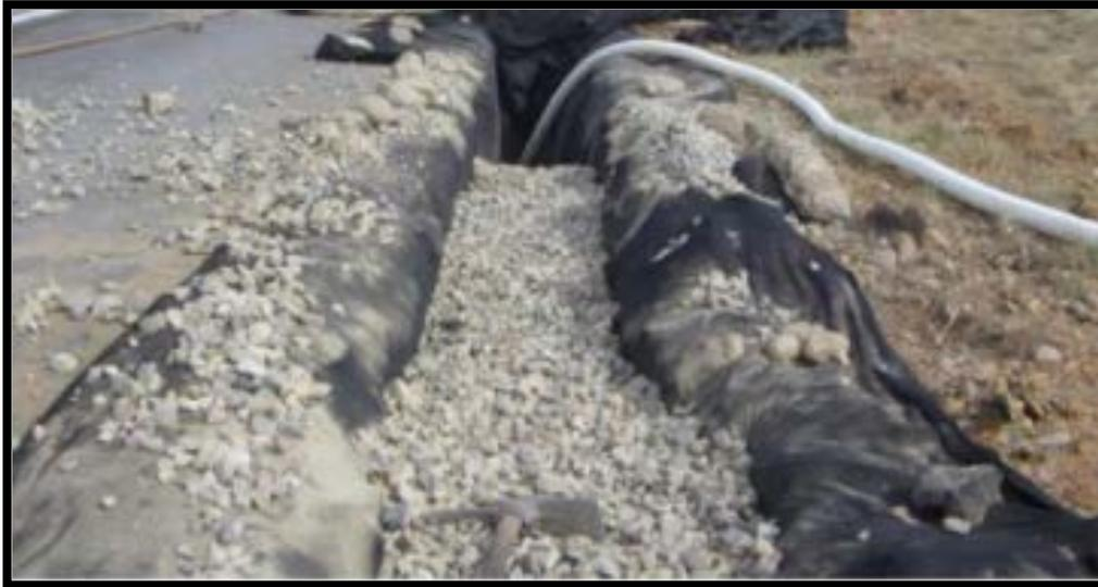
Imagen II.3. Aplicación de geosintéticos en subdrenaje longitudinal
