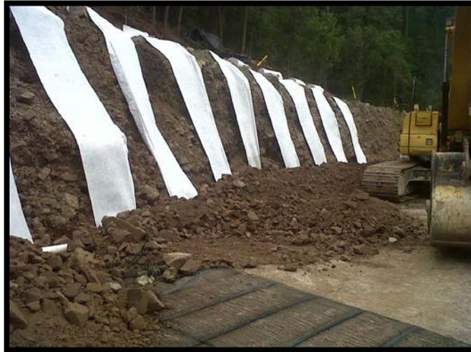
Imagen IV.9. Instalación del sistema de drenaje
