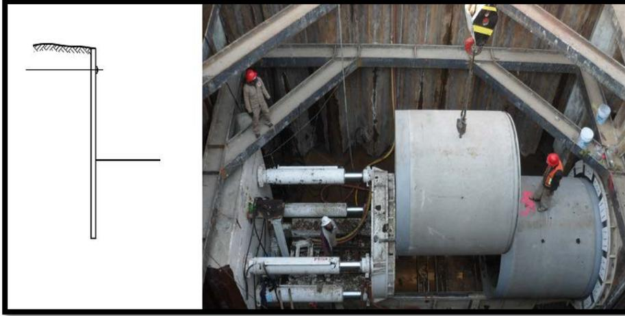
Imagen II.17. A la izquierda, una tablestaca. A la derecha, un ademe que permite una excavación
