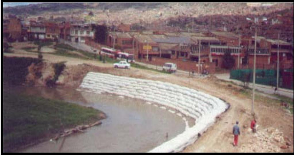
Imagen II.5. Aplicación de geosintéticos para prevenir la erosión en ríos
