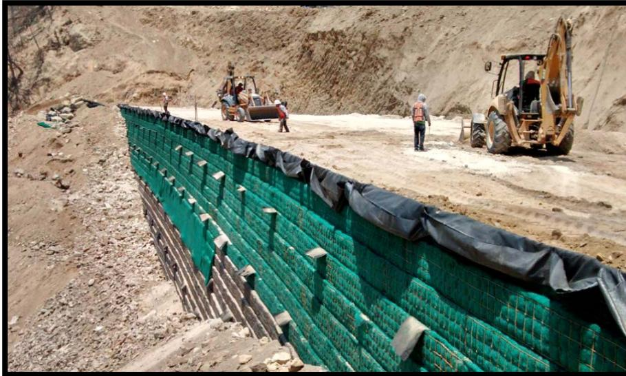
Imagen II.18. Construcción de muro geosintético
