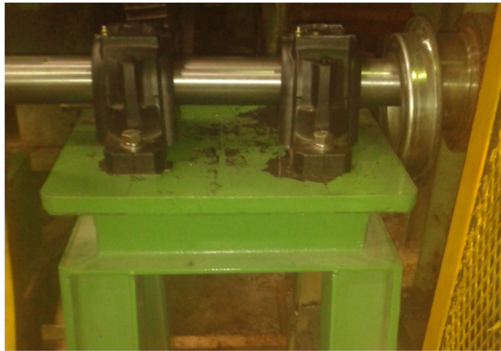
Figura 36. Pre-alineación de la flecha de transmisión.
