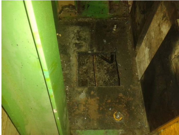
Figura 31. Colocación de la quinta placa sobre las placas que se encontraban ancladas a las cimentaciones.
