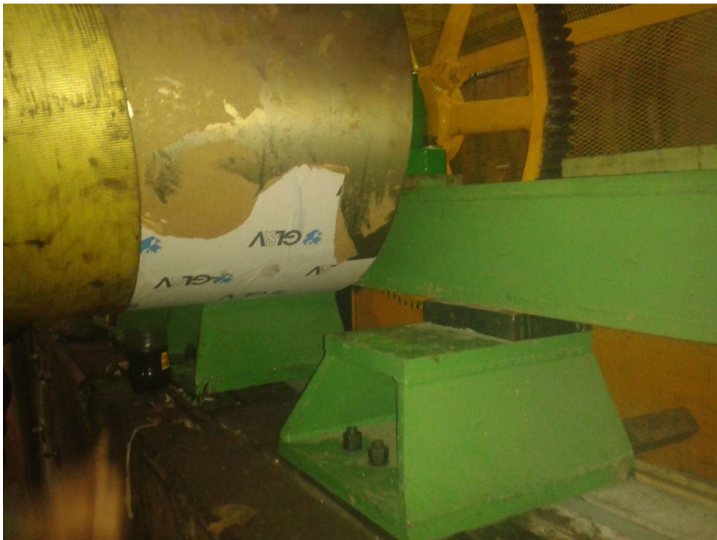
Figura 38. Posicionamiento del secador #6 sobre placas de nivelación
