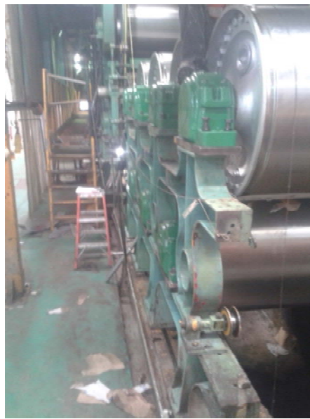
Figura 43. Secadores superiores instalados satisfactoriamente.
