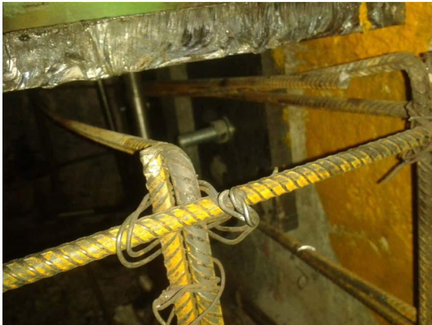
Figura 32. Arreglo de varillas por debajo de placas para la estructura de flecha de transmisión.
