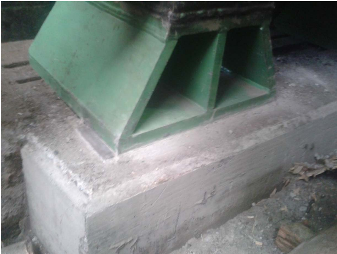
Figura 46. concreto fraguado exitosamente, teniendo como alma la viga de 258 [mm]
