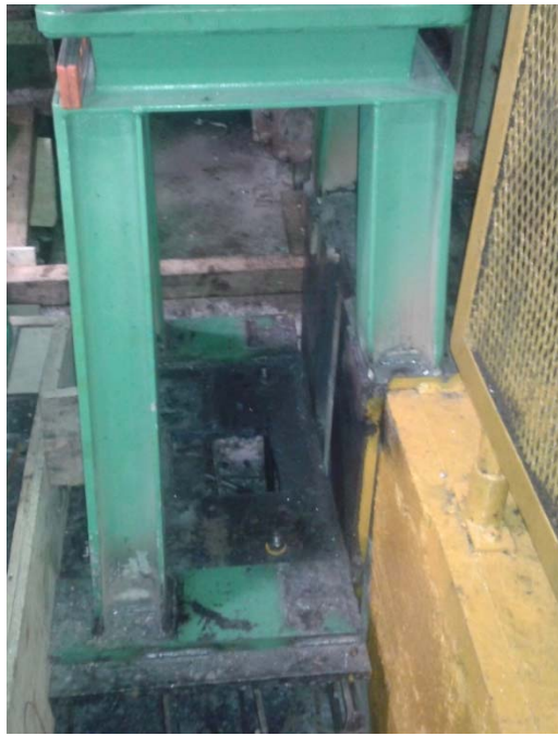
Figura 33. Montaje de base de flecha de transmisión sobre placas.
