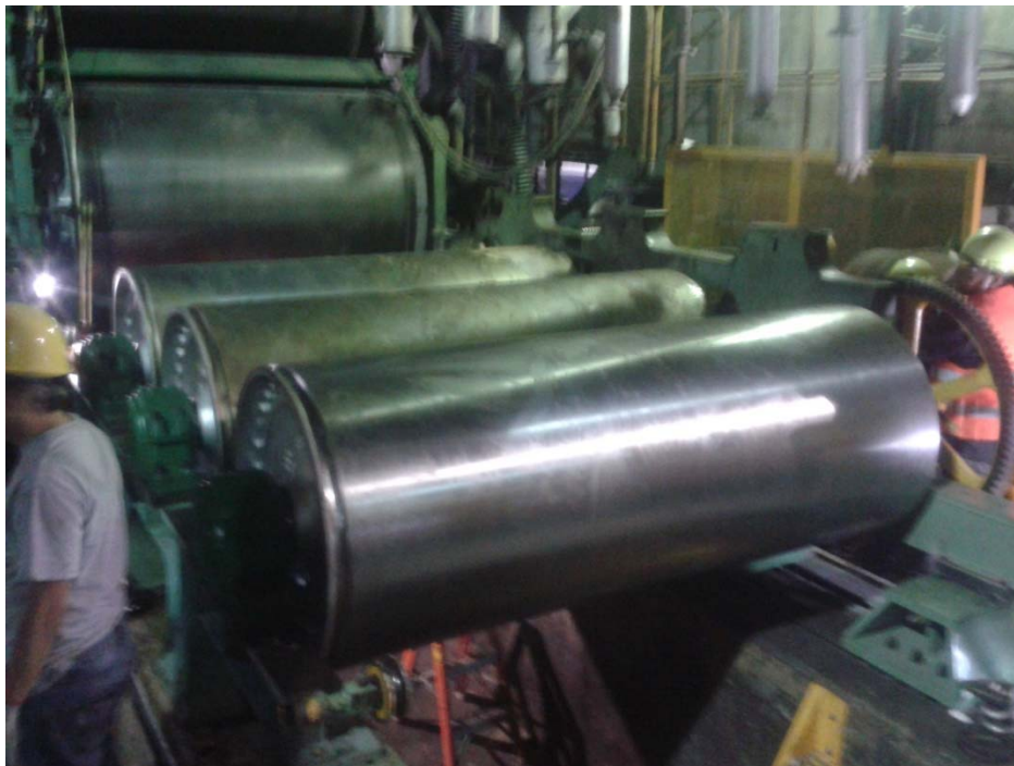
Figura 40. Instalación de los secadores inferiores de la primera sección de secadores.
