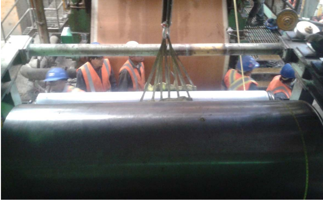
Figura 45. Instalación del rodillo pescante.
