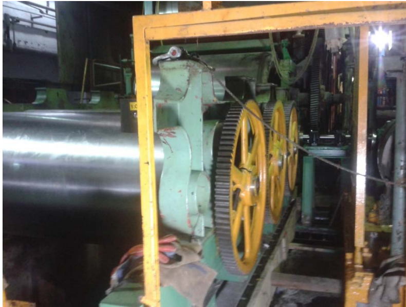
Figura 41. Montaje de los pedestales en el lado transmisión
