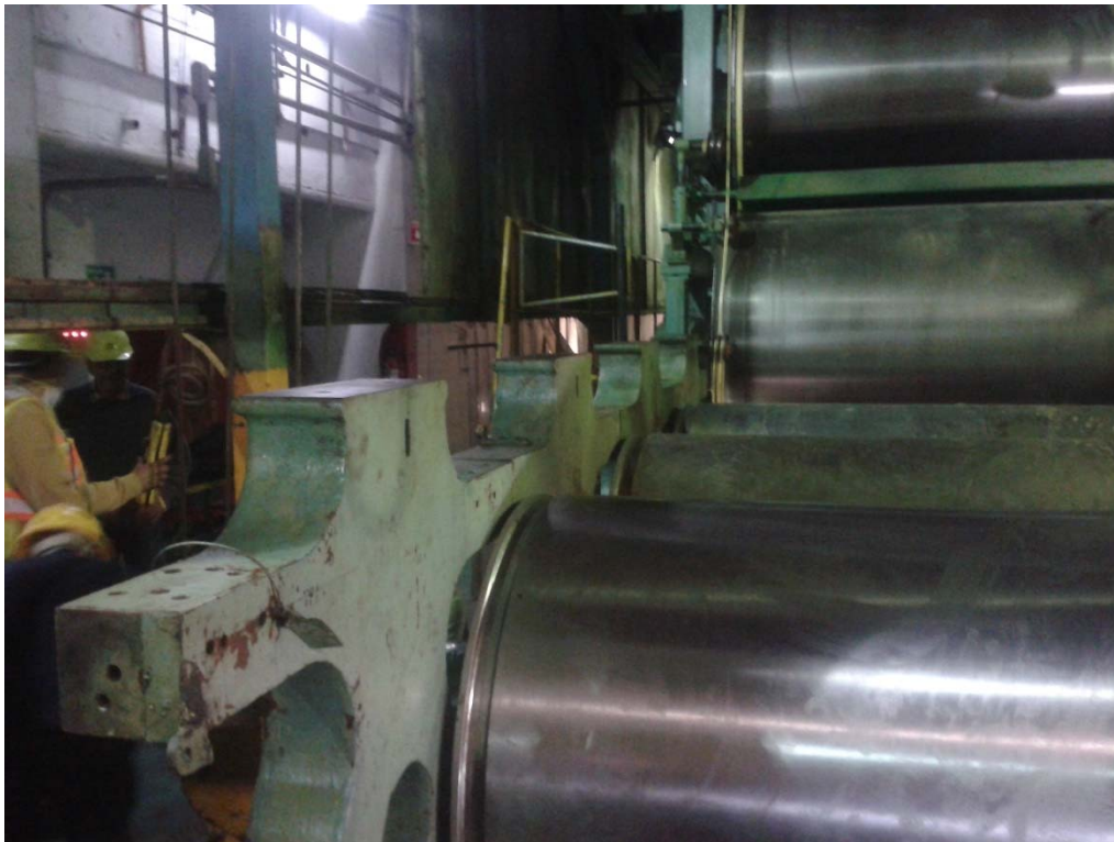
Figura 42. Montaje de los pedestales del lado frente.
