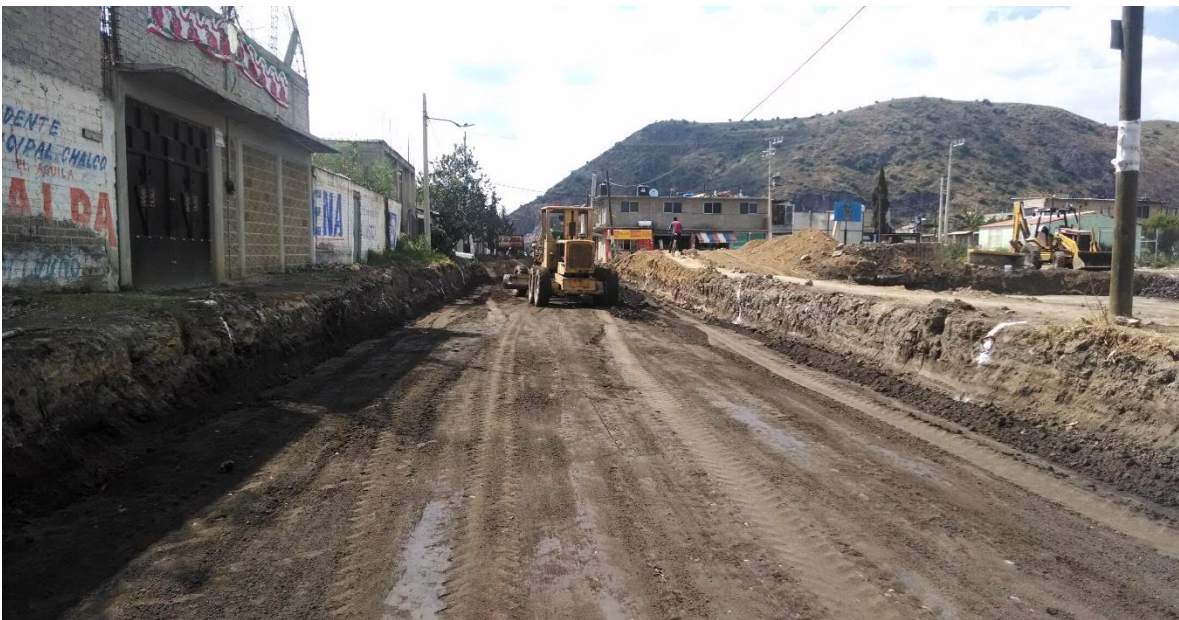
Figura 7.4 Afine y Compactación del fondo de la excavación.
