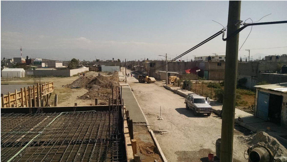
Figura 7.7 Construcción de banquetas
