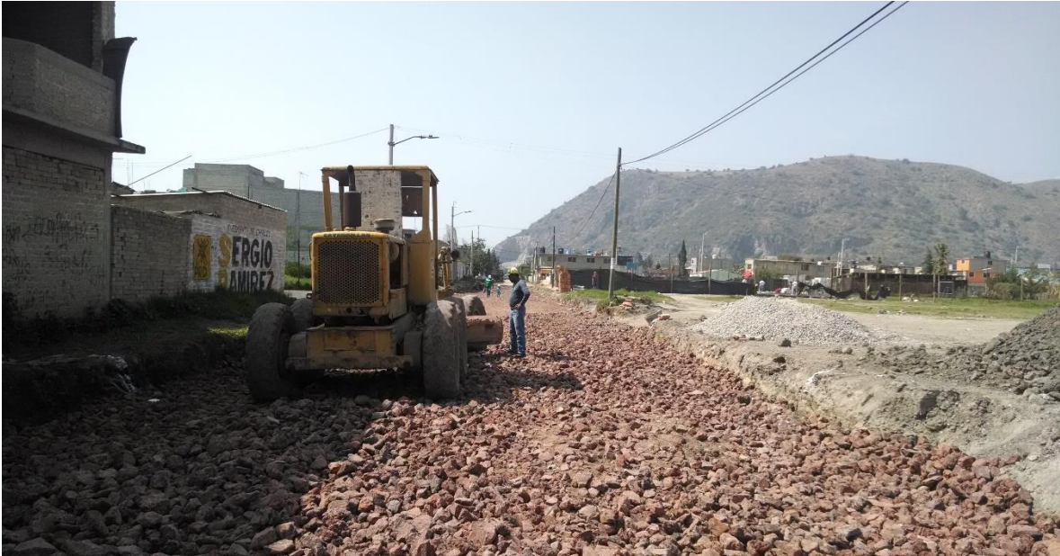
Figura 7.5 Tendido de tezontle de 1" a 3".
