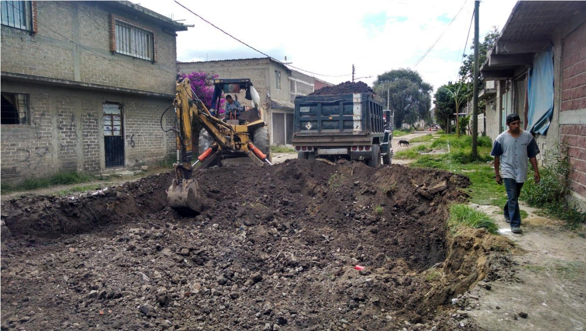
Figura 7.2 Excavación por Medio Mecánico
