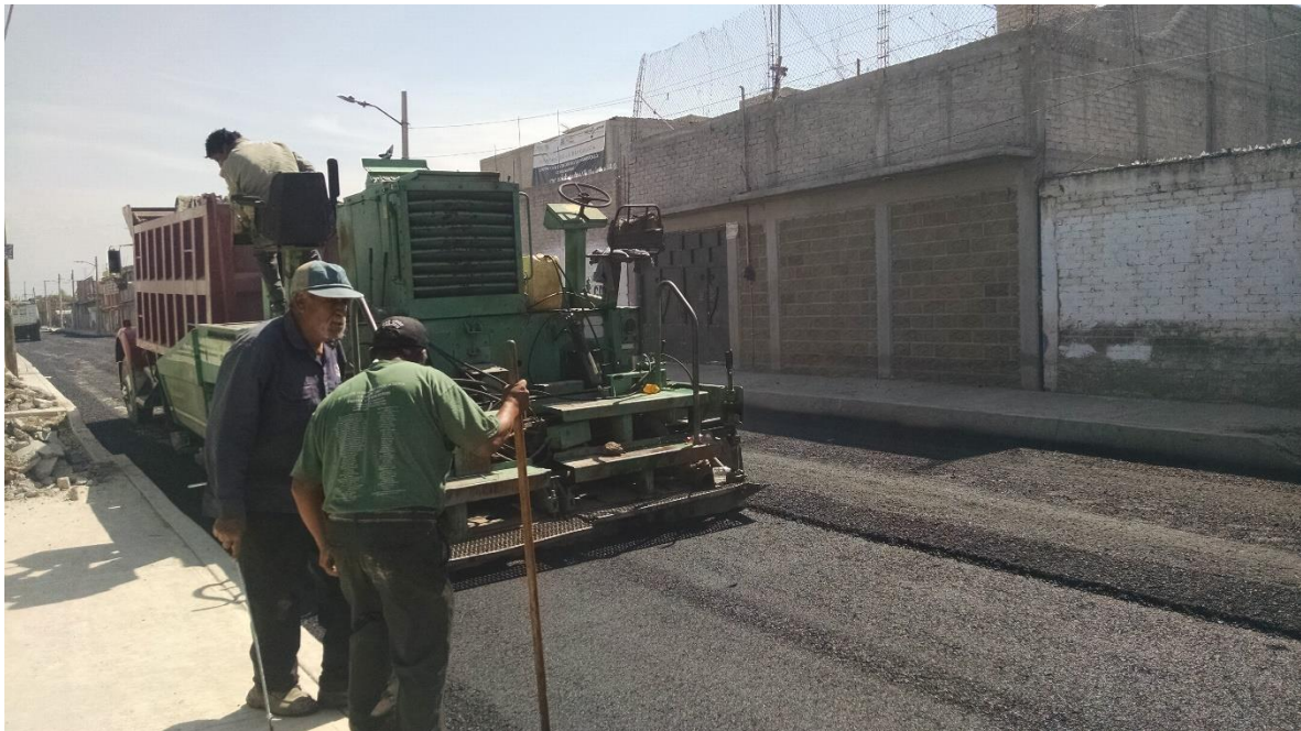
Figura 7.10 Colocación de asfalto.
