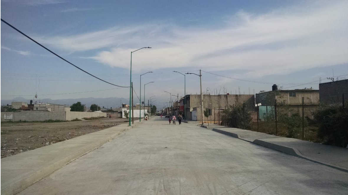
Figura 7.11 Pavimentación de Calle Ejido de Huitzilzingo
