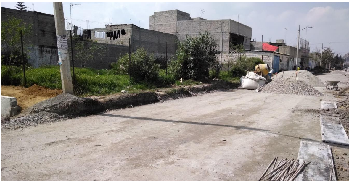
Figura 7.6 Tendido de sub-base hidráulica de grava-arena (70%-30%).
