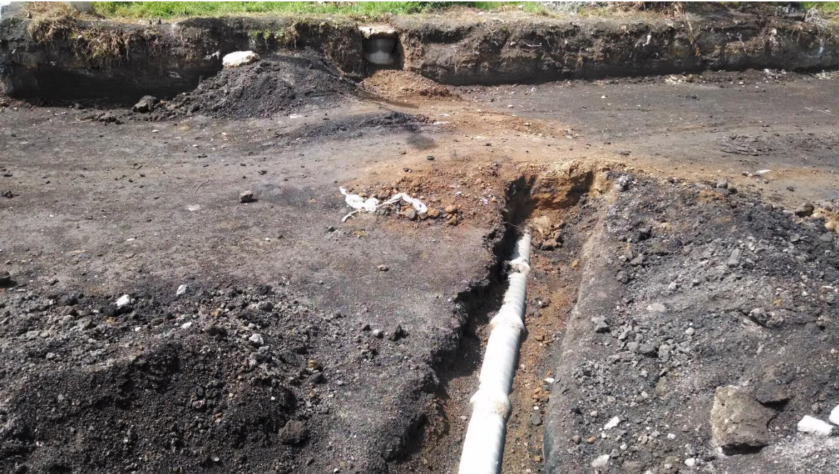
Figura 7.3 Reparación de descarga sanitaria domiciliaria.
