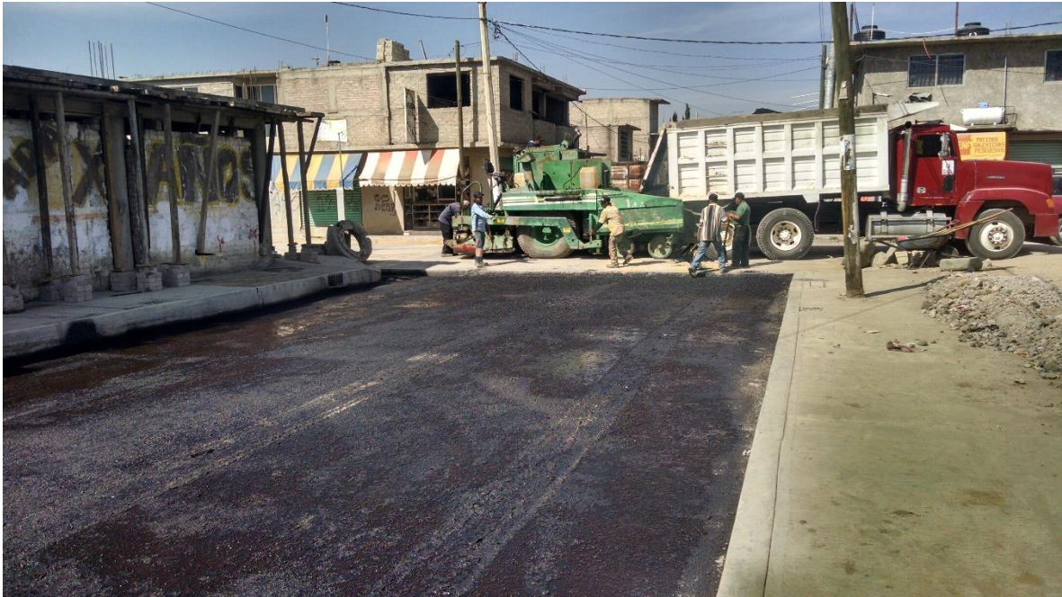
Figura 7.9 Riego de impregnación y de liga
