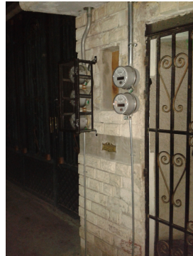
Figura 4.13: Los medidores son un peligro para las personas invidentes y para los que no lo son. La profesora comenta que algunos invidentes han sufrido algún incidente con los medidores instalados sobre las fachadas de las viviendas.
