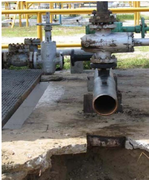
Figura IV.3 Línea de escurrimiento de 8" del pozo A.
