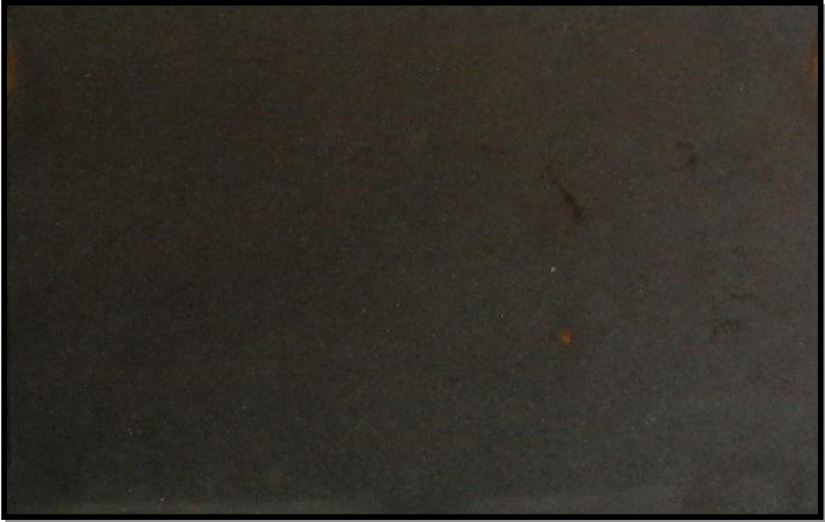
Fig. 3.1.3.4 Probeta de cobre después de 9 meses de exposición; la probeta presenta un tono oscuro debido a las patinas en la superficie. Se observa una corrosión homogénea en la superficie.
