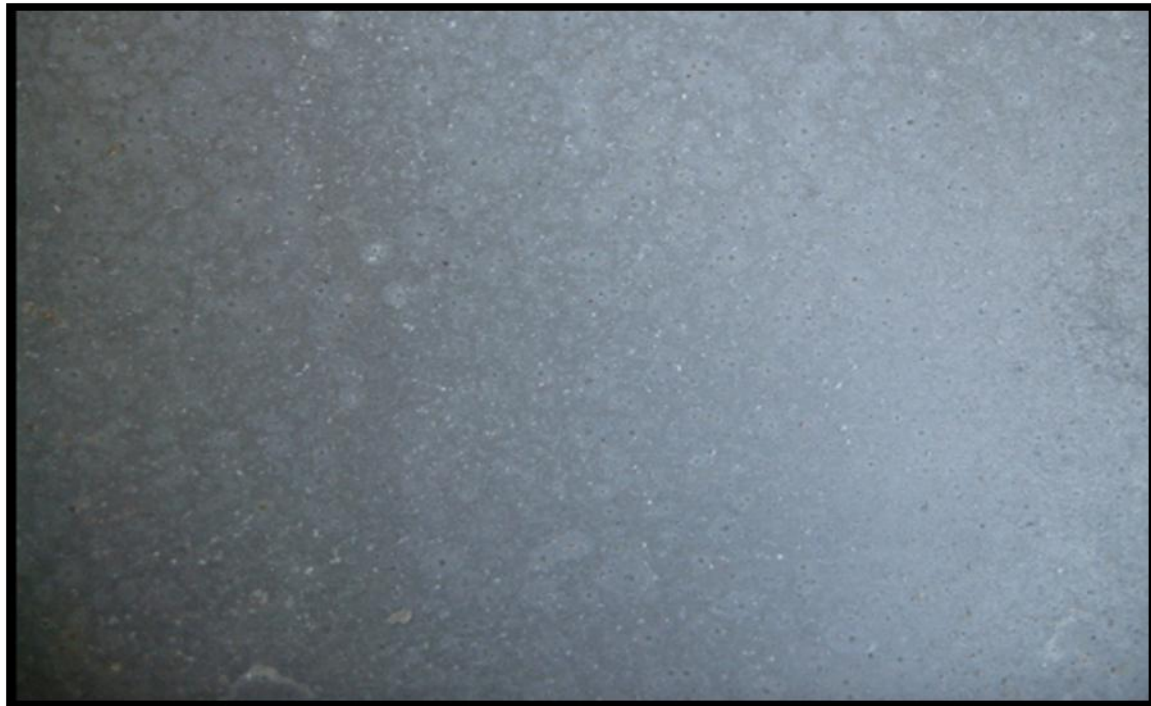
Fig. 3.1.4.3. Probeta de zinc después de 6 meses de exposición; se aprecia que se ha generado oxidación localizada en algunos puntos de la probeta aunque aún no presenta una corrosión muy marcada.
