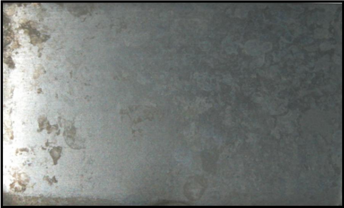
Fig. 3.1.4.4 Probeta de zinc después de 9 meses de exposición; se aprecia que la corrosión no ha variado mucho respecto a la probeta con exposición de 6 meses. Se sigue presentado corrosión localizada y manchas debido a la lluvia.
