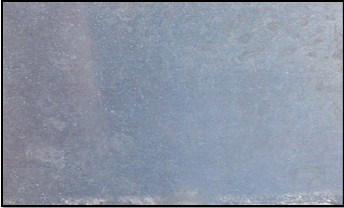
Fig. 3.1.4.2. Probeta de zinc después de 3 meses de exposición; se aprecia levemente rastros de productos de corrosión en algunos puntos de la superficie.
