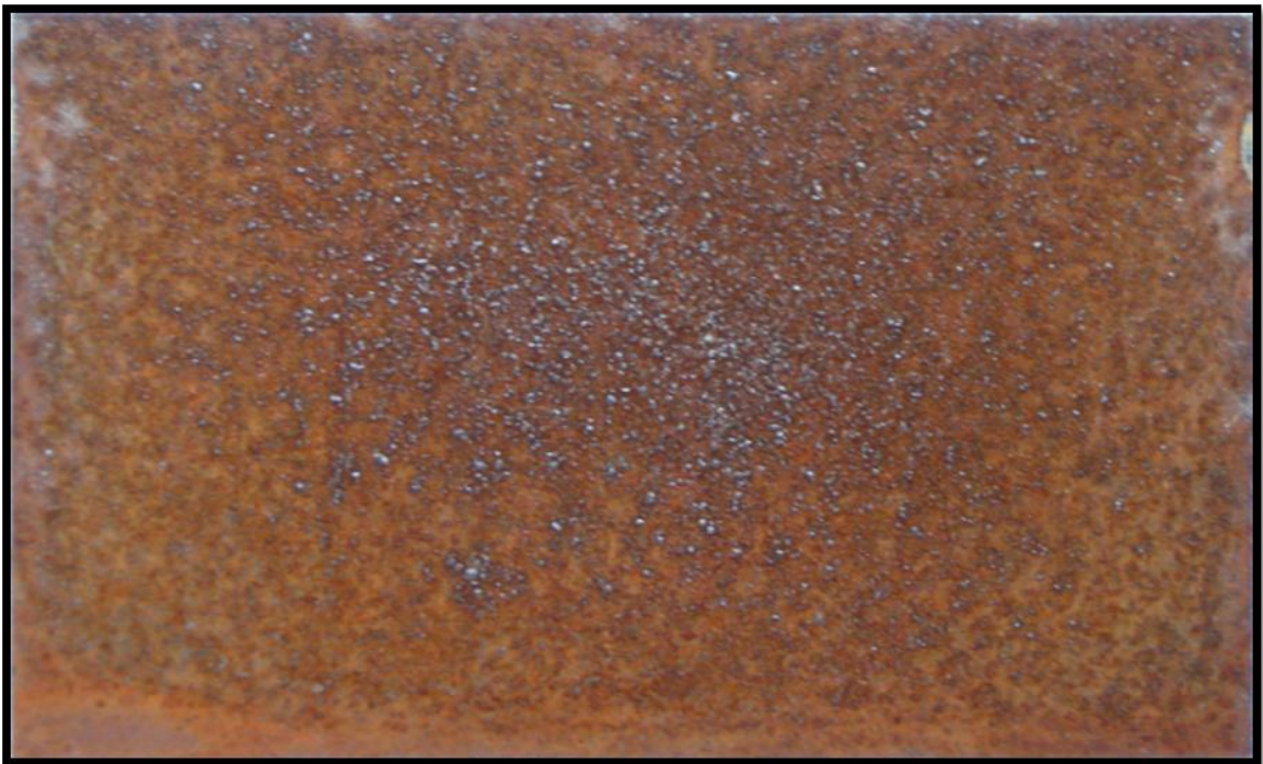
Fig. 3.1.1.1.5. Probeta de acero. Después de 12 meses de exposición se observa prácticamente toda la superficie corroída. La parte central presenta mayor concentración de óxido.
