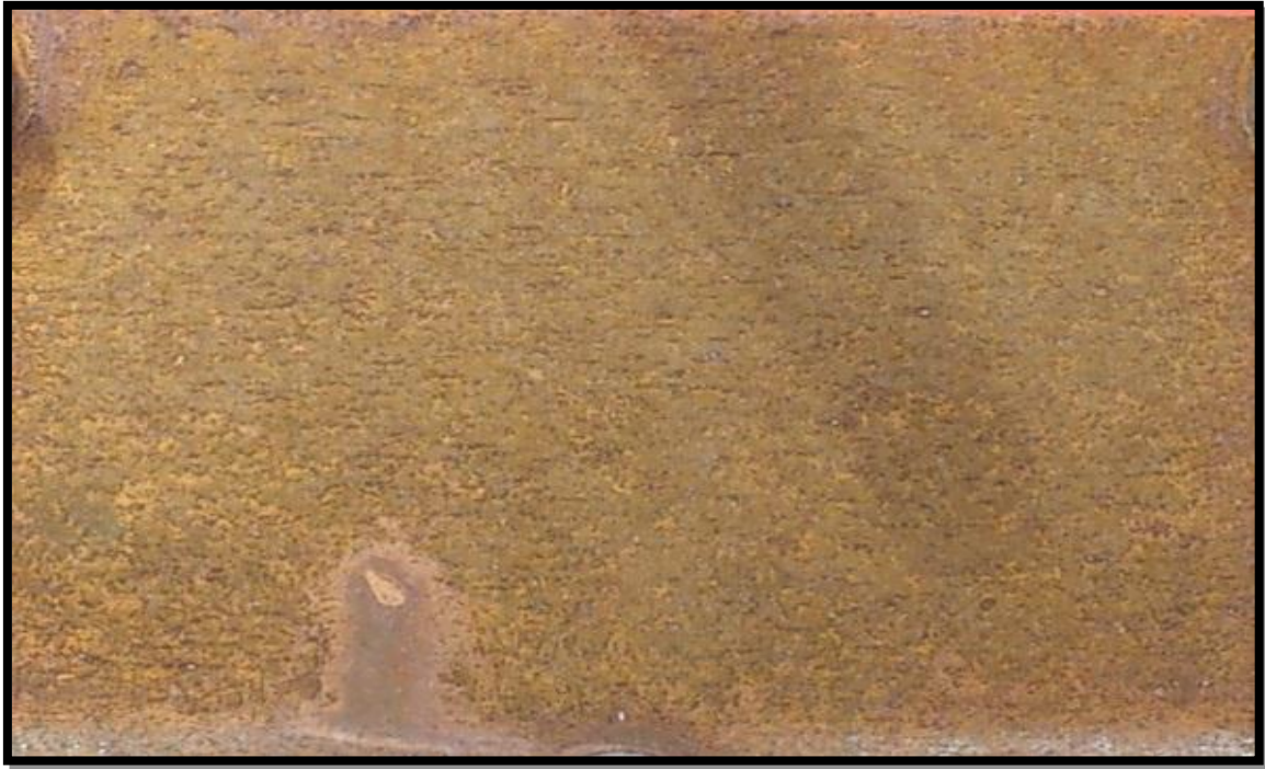
Fig. 3.1.3.2 Probeta de cobre, después de 3 meses de exposición; la probeta muestra ataques de corrosión por picaduras además de impurezas en el material base (coloración beige).
