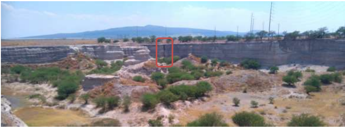
Figura 4 Socavón ubicado en la parte sureste de la ciudad de Celaya en donde se muestra la estratificación de los depósitos sedimentarios y vulcano-sedimentarios recientes. En el recuadro se aprecia una de las fallas, así como la fábrica de la Honda en segundo plano.
