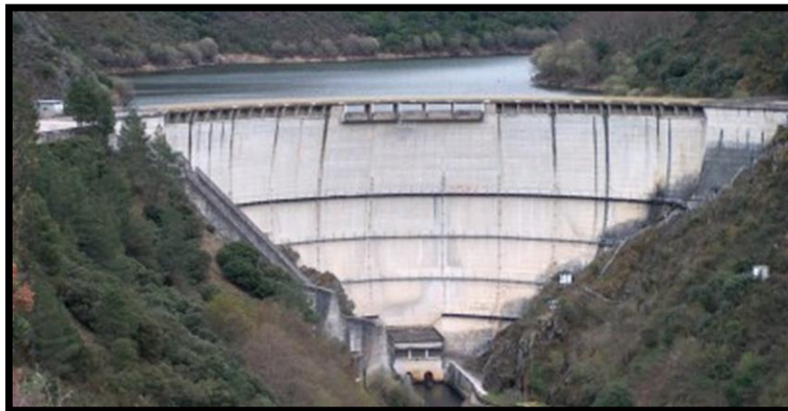
Figura 1.7 Presa Santa Eulalia, España, cortina arco-gravedad.
