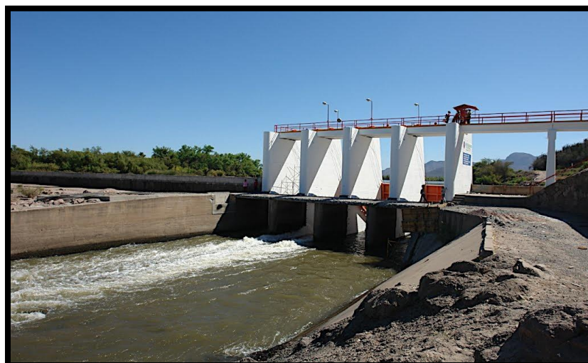
Figura 1.13 Presa tipo indio El Sufragio (Sinaloa, México).
