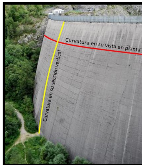
Figura 1.5 Cortina de arco-bóveda de la presa Vajont, Longarone, Italia.
