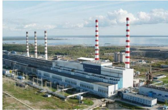
**Fig.2.1. Planta de energía basada en aceite de lutitas ubicada en Narva, Estonia.** Fuente: Eesti Energia, 2009.
