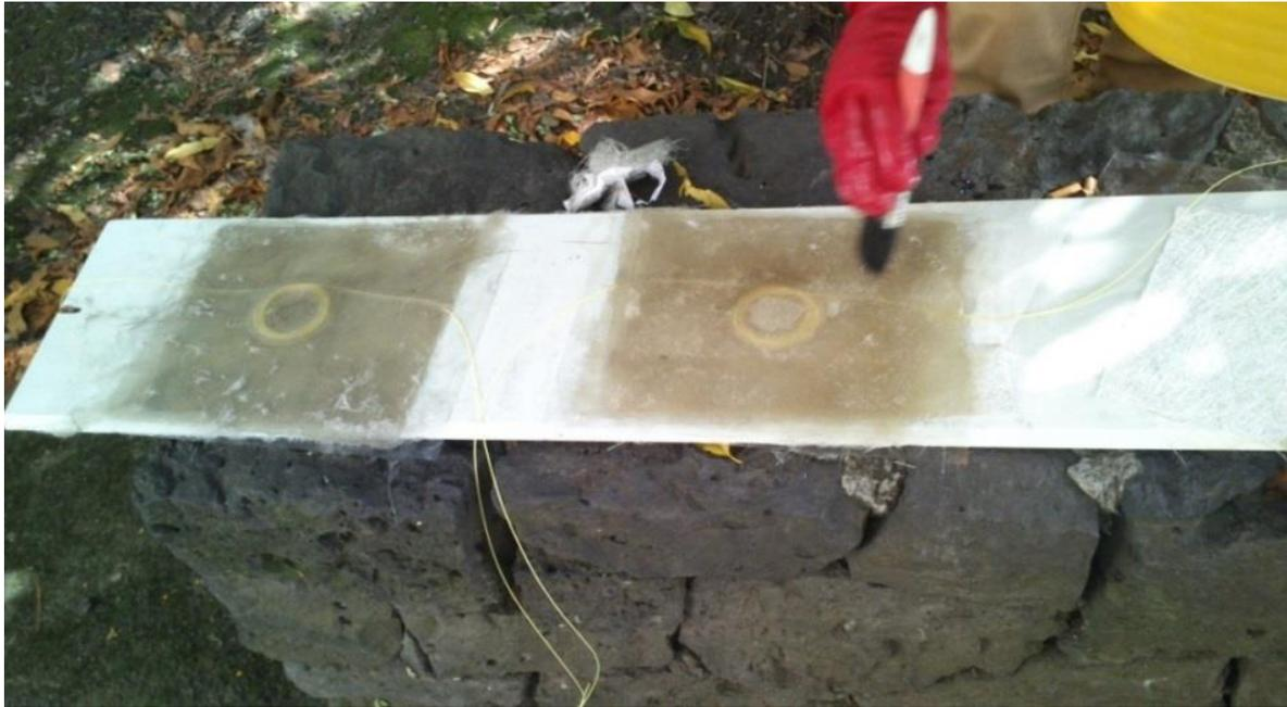
Figura 3.4. Colocando el siguiente fragmento de fibra de vidrio.
