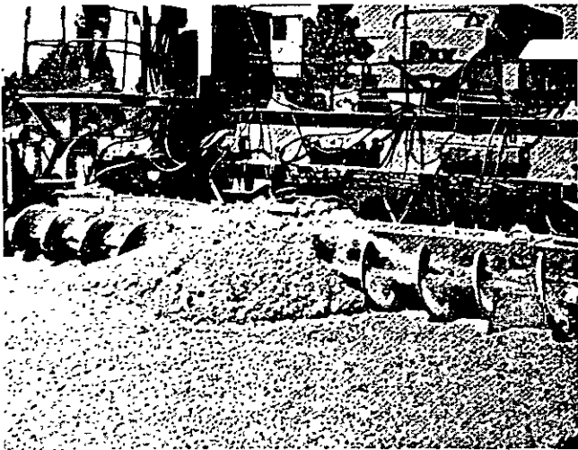
Figura 8-14. El extendedor de tornillos tiende rápidamente al concreto en un área amplia con un espesor uniforme. Los extendedores de tornillos se emplean principalmente en la construcción de pavimentos.
