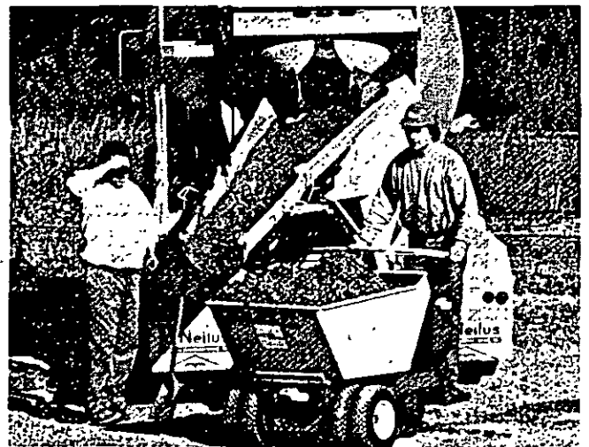
Figura 8-6. La versátil carretilla motorizada puede mover todo tipo de concreto a lo largo de distancias cortas.
