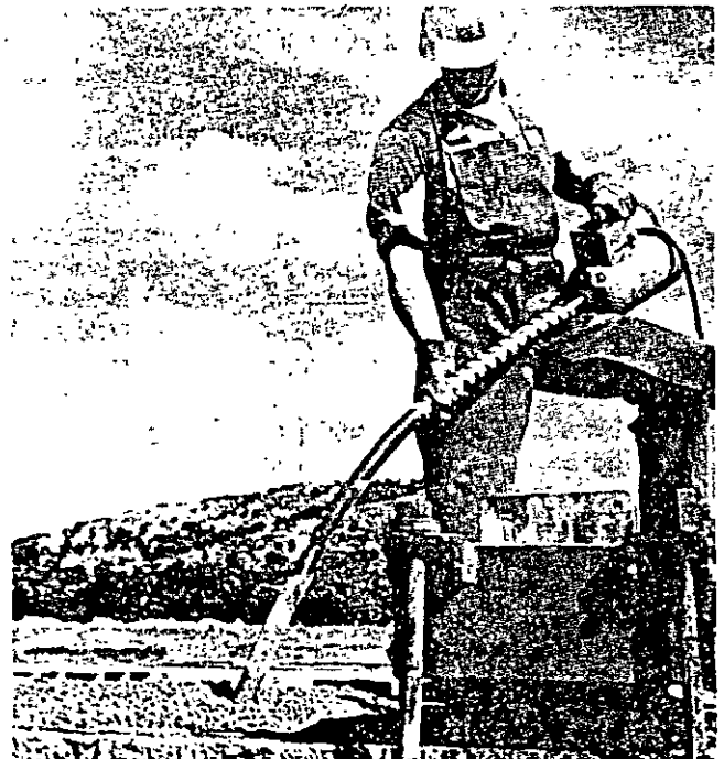
Figura 9-4. Los vibradores internos se utilizan comúnmente para consolidar al concreto en muros, columnas, vigas y losas.
