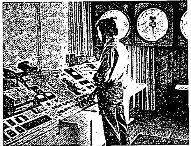
Figura 8-1. Tablero de control para el equipo de dosificación por peso en una planta típica de concreto premezclado.
