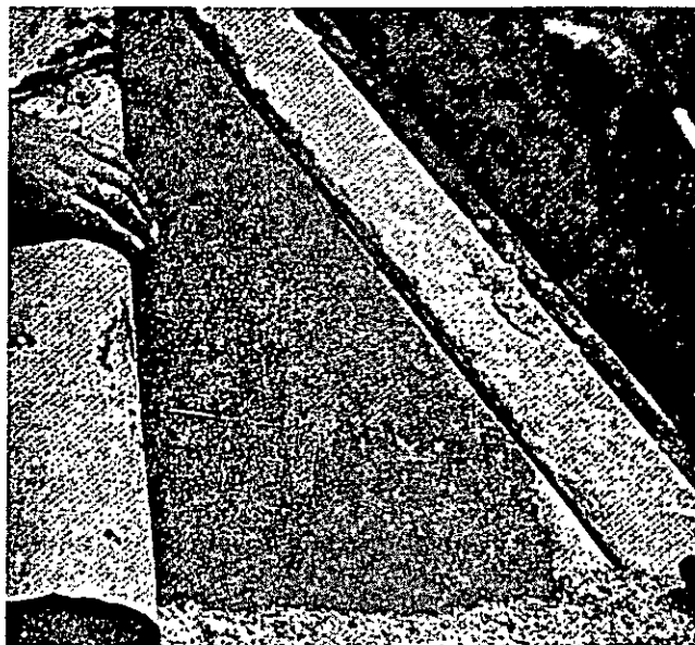
Figura 10-3. El papel impermeable para curado es un medio eficiente para curar superficies horizontales.
