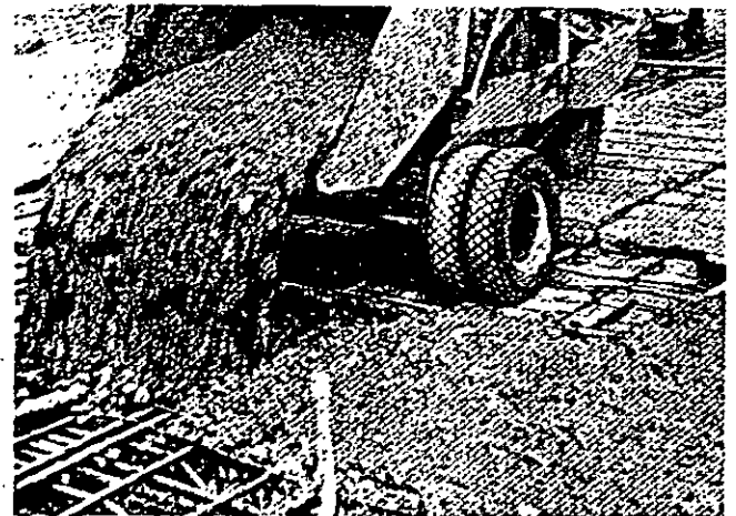
Figura 9-1. El concreto se deberá ir colocando lo más cerca posible de su posición final.
