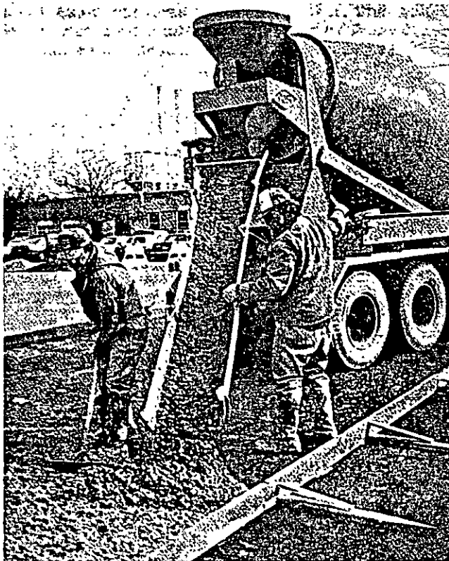
Figura 8-8. Por medio de la descarga directa desde el canalón del camión mezclador, frecuentemente se puede colocar en su sitio final al concreto premezclado.
