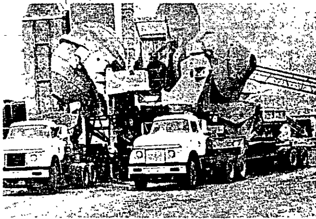
Figura 8-3. Mezclado central en mezcladores estacionarios del tipo de tambor basculante.
