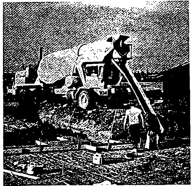
Figura 8-9. En comparación con los camiones convencionales de descarga trasera, los camiones mezcladores de descarga frontal le proporcionan al conductor una mayor movilidad y control en la descarga directa del concreto en las cimbras.
