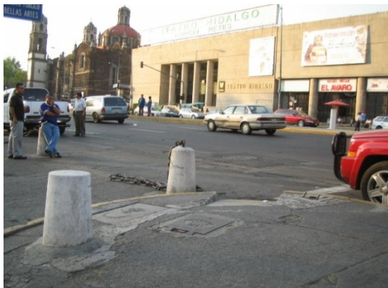
Fig. 1.14 Rampa peligrosa para silla de ruedas a un costado del Palacio de Bellas Artes
