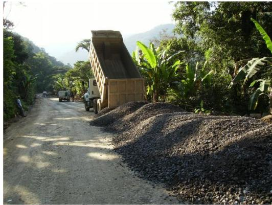
Fig. 4.2 Tendido de material
