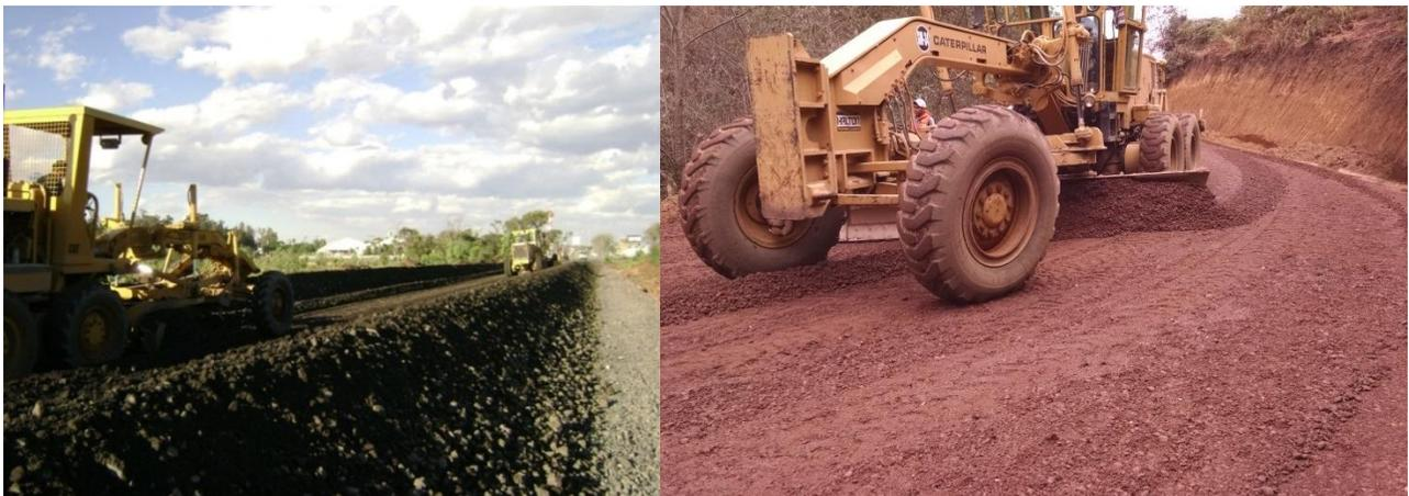
Fig. 4.4 Extendido de material con motoconformadora
