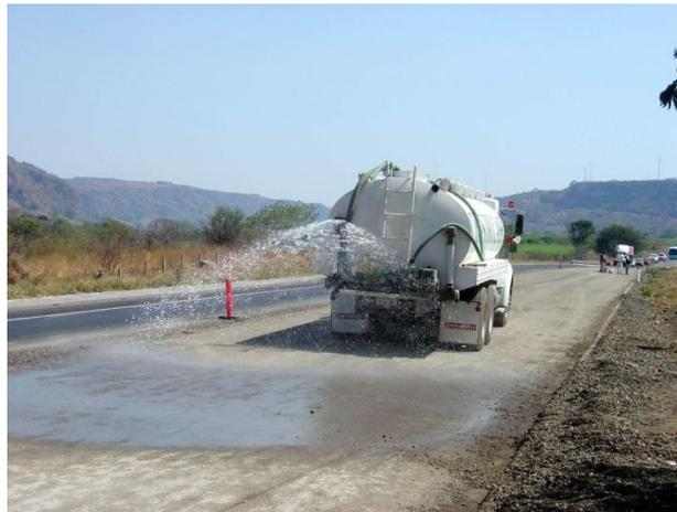
Fig. 4.3 Riego con pipa
