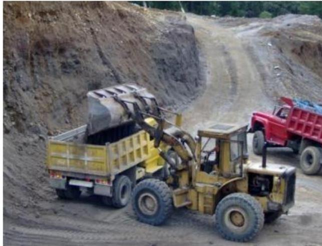
Fig. 4.1 Carga de material con retroexcavadora.
