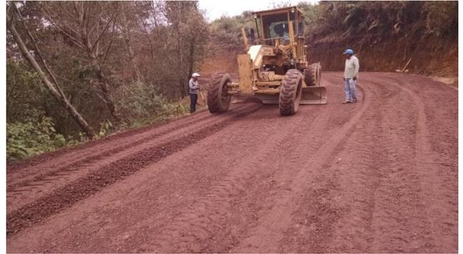
Afine de bombeo con Motoconformadora
