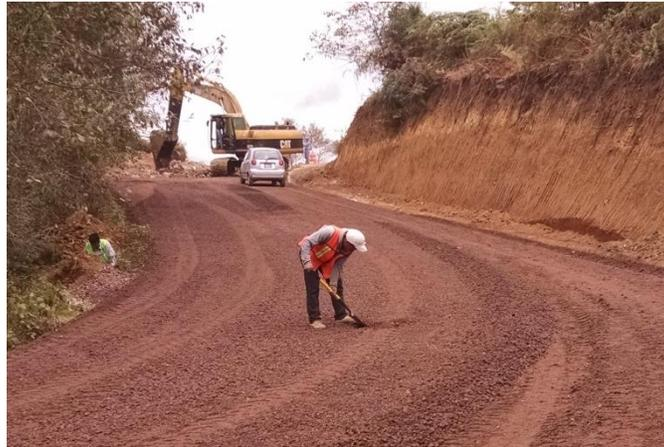
Fig. 4.5 Descubierta de trompos
