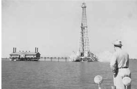
**Figura 2.4.** Barcaza sumergible de perforación de la compañía Texaco<sup>5</sup>
