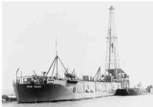
**Figura 2.5.** Buque de la marina norteamericana adaptado como barco de perforación<sup>5</sup>
