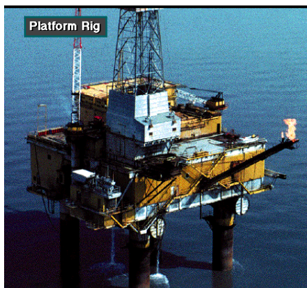
Figura 1.9 Plataforma de perforación fija de 4 piernas (Tetrápodo).
