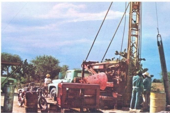
Figura 1.19 Equipo utilizado en la perforación por percusión.
