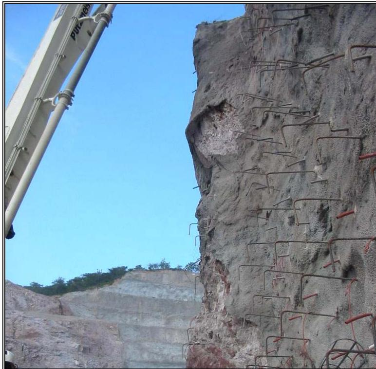
**Fotografía IV.9.** Zona del muro alabeado con relajamiento reciente, donde existieron desprendimientos del concreto lanzado (cad. 0-015).
