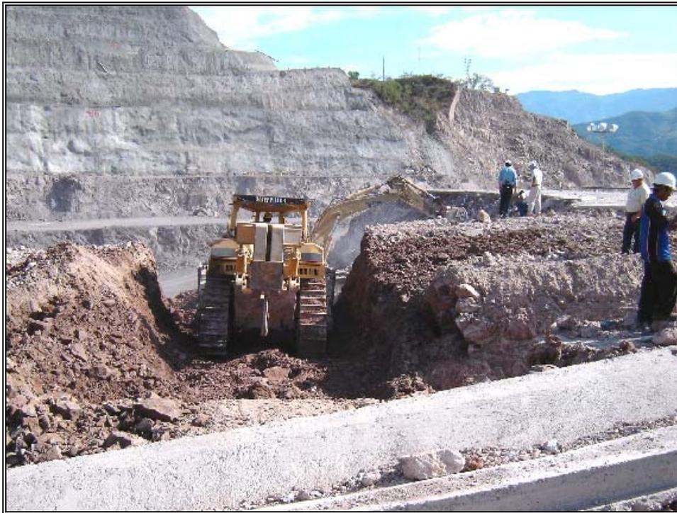
**Fotografía V.14.** Vista de la remoción del material de falla, obsérvese el contacto con la roca de buena calida
