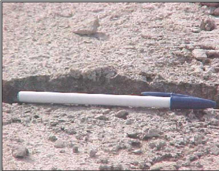
**Fotografía IV.12.** En la fotografía se muestra el desnivel que existe en la losa de concreto colocada en la plataforma 396, en la zona de la grieta.
