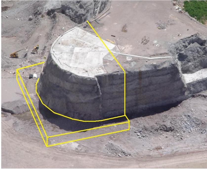
**Figura IV.17** Zona del muro alabeado modelada con elementos finitos tridimensionales.
