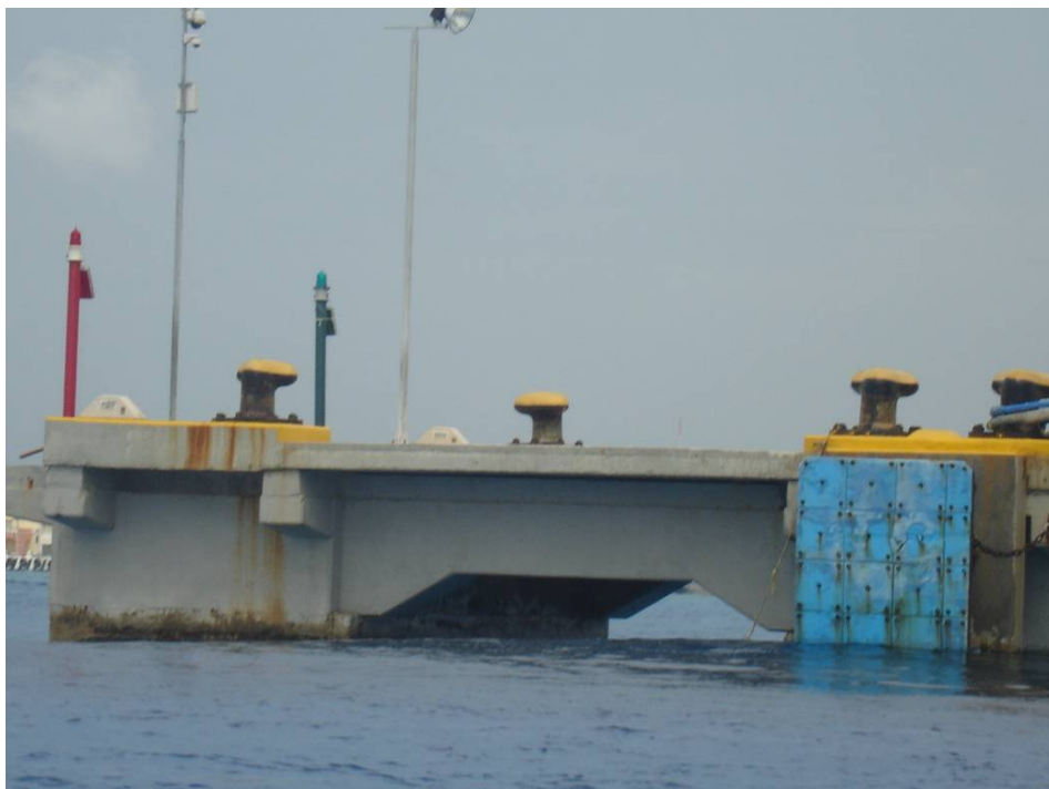
Figura 3.7 Características estructurales del muelle, bitas y estructuras para atraque de buques
