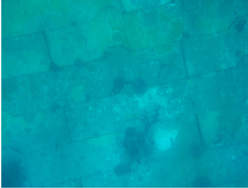
Figura 3.11 El muelle para cruceros Consorcio H, colapso totalmente por el Huracán Wilma
