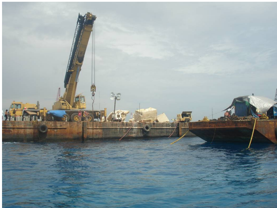
Figura 3.16 Construcción del nuevo muelle por parte de la empresa CARNIVAL
