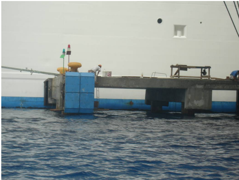
Figura 3.9 Estructura del muelle a la izquierda del Duque de Alba
