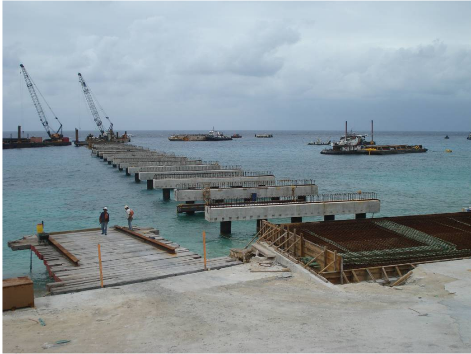
Figura 3.17 La forma en que será construido este muelle, es totalmente distinta a su antecesor
