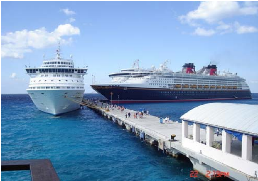
Figura G.4 Muelle Punta Langosta en operación después de ser reparado debido a los daños causados por el huracán Wilma (Ref. 8)
