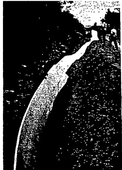
Colocación de subdrén geocompuesto prefabricado en la zanja.
