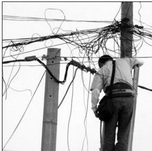
Figura (4.10) Convivencia de líneas de comunicación y conductores de sistemas de potencia.
