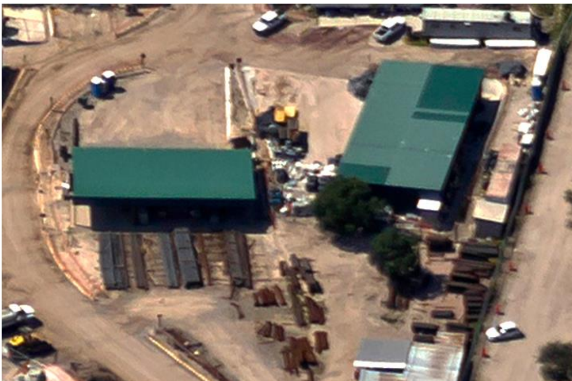
ILUSTRACIÓN 25 IZQUIERDA: TALLER DE DOBLES DE ACERO Y A LA DERECHA:
