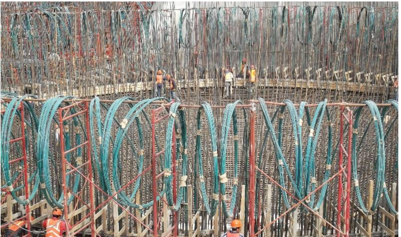
ILUSTRACIÓN 51 COLOCACIÓN DE CABLES TORONES VERTICALES
