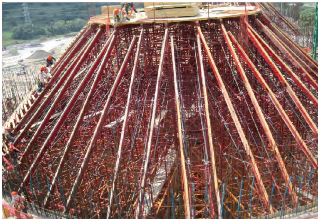
ILUSTRACIÓN 47 OBRA FALSA PARA EL COLADO DE LA LOSA TAPA (CONAGUA, COMISIÓN NACIONAL DEL AGUA, 2010)
