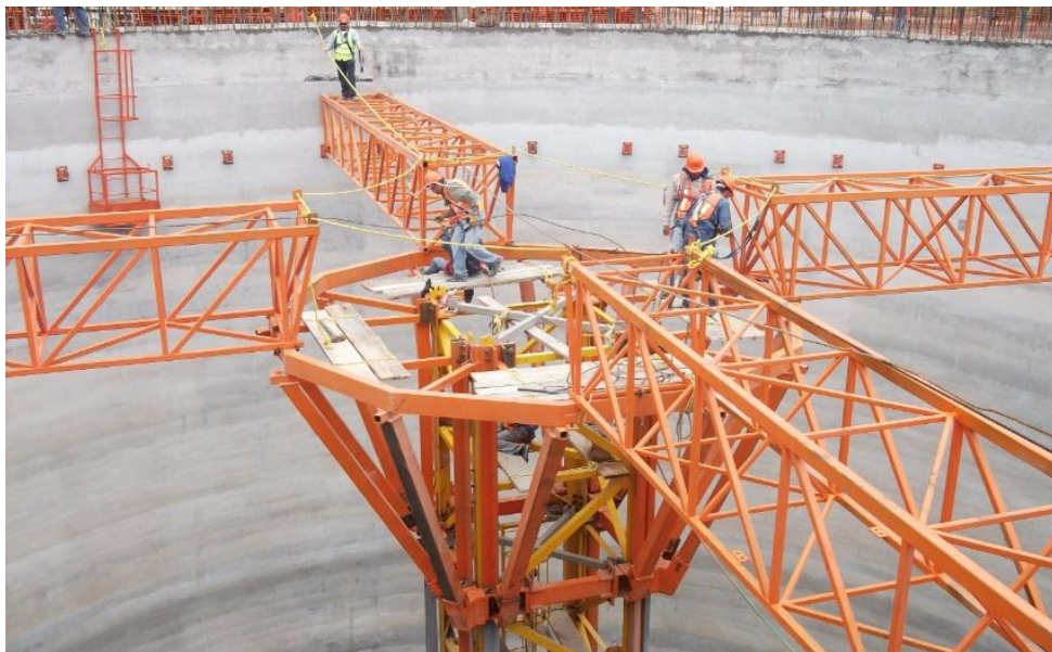
ILUSTRACIÓN 46 ESTRUCTURA PROVISIONAL DE SOPORTE PARA LOSA TAPA
