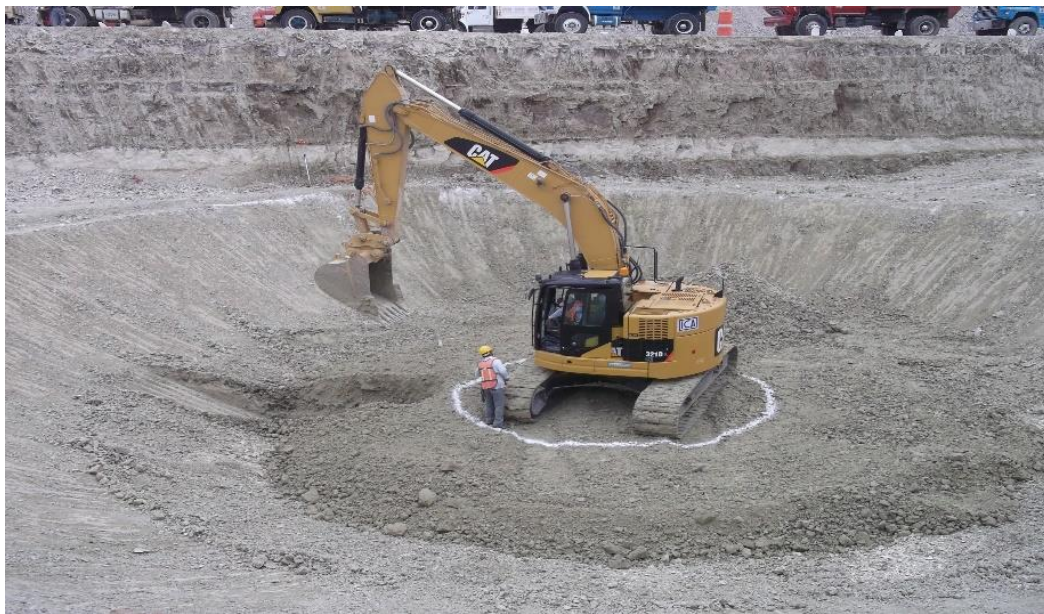
ILUSTRACIÓN 18 EXCAVACIÓN DE TANQUE BIODIGESTOR
