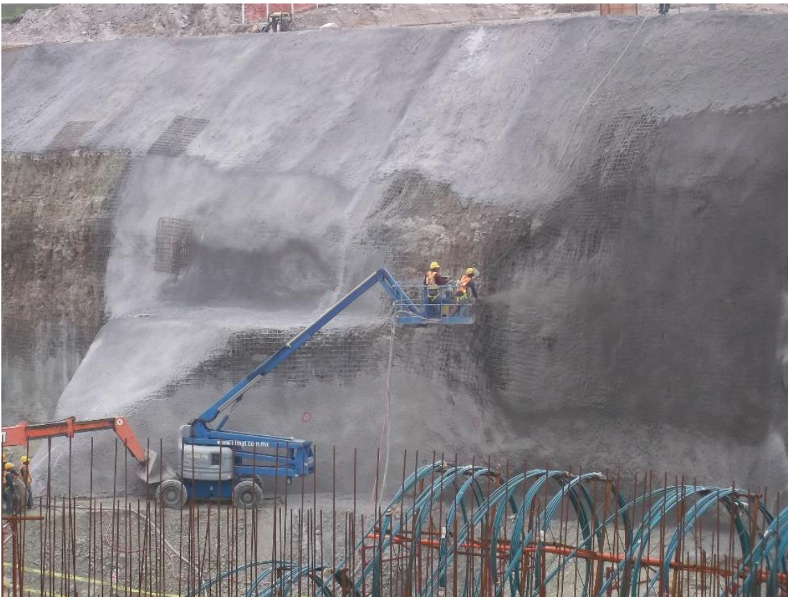
ILUSTRACIÓN 19 PROTECCIÓN DE TALUD
