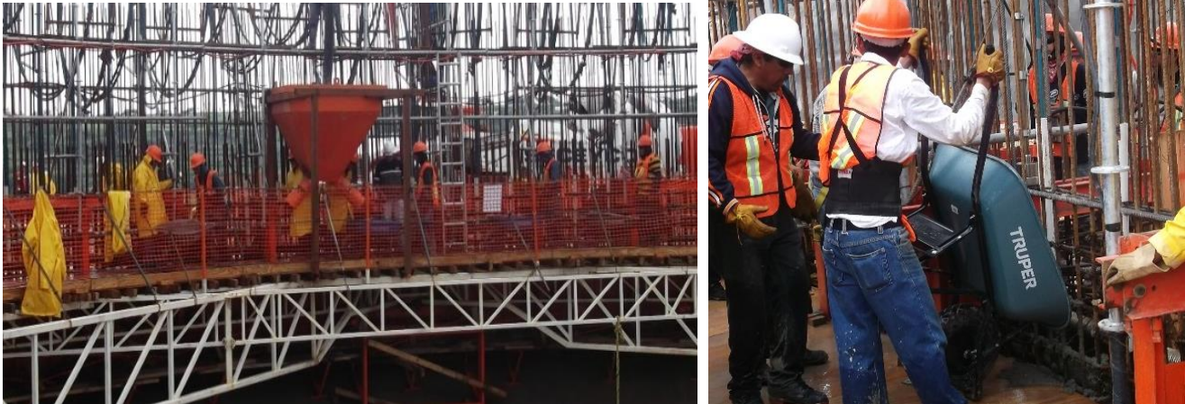
ILUSTRACIÓN 4 1 IZQ. TOLVA RECEPCIÓN DE CONCRETO. DER. VACIADO POR MEDIO DE CARRETILLA
