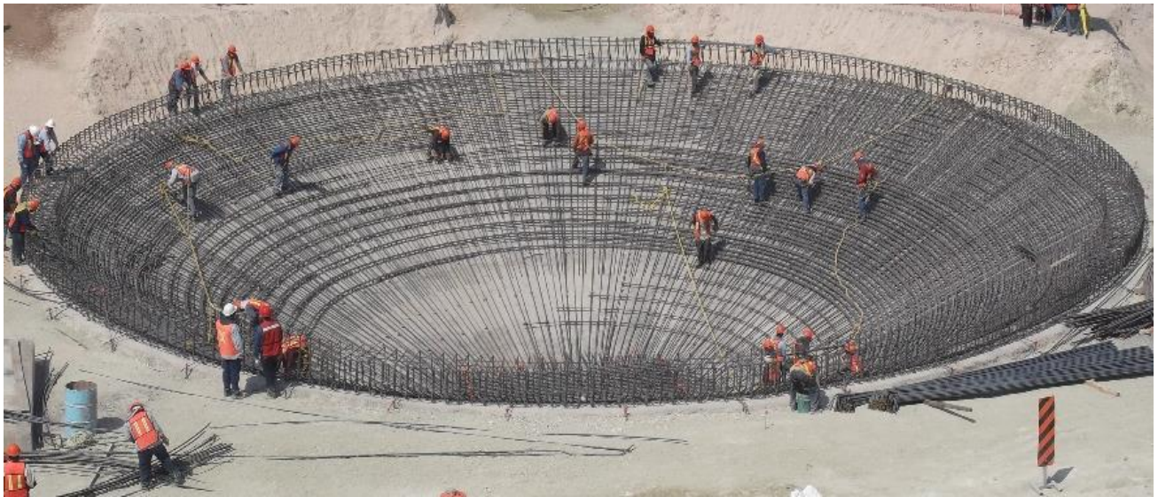
ILUSTRACIÓN 31 COLOCACIÓN DE ACERO DE REFUERZO - BASE DE BIODIGESTOR
