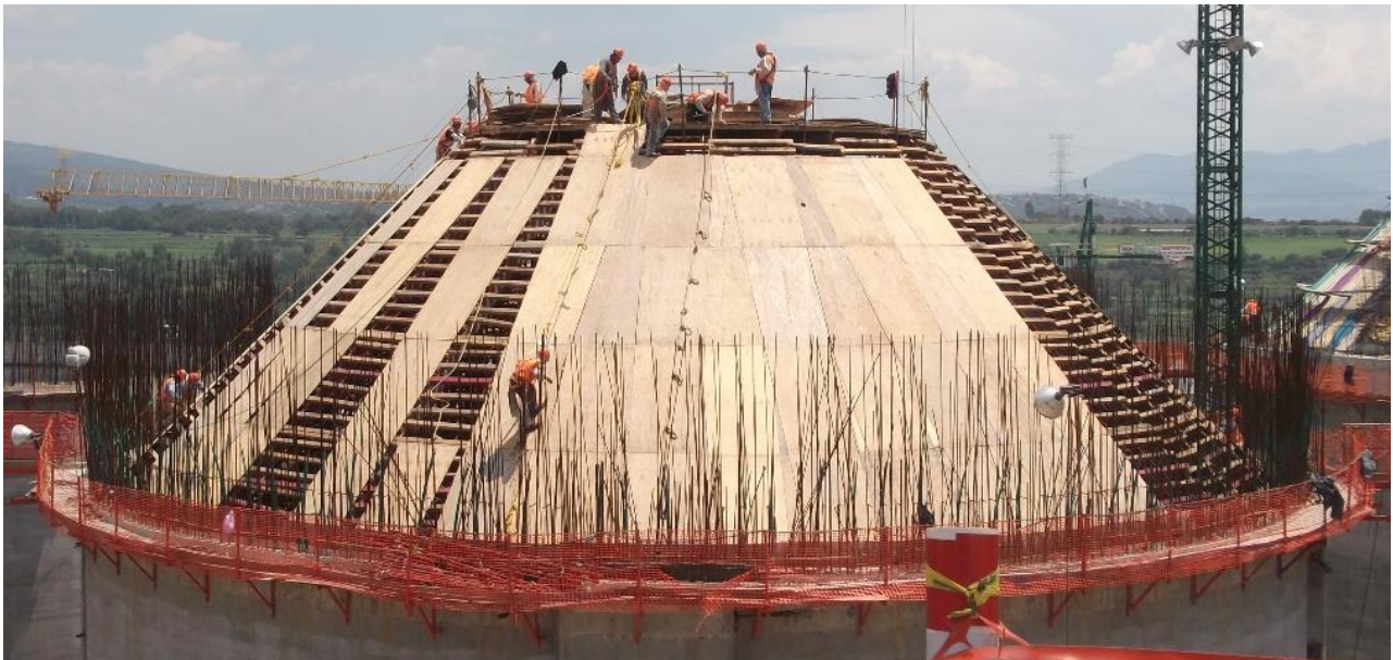
ILUSTRACIÓN 48 COLOCACIÓN CIMBRA DE CONTACTO DE LOSA TAPA
