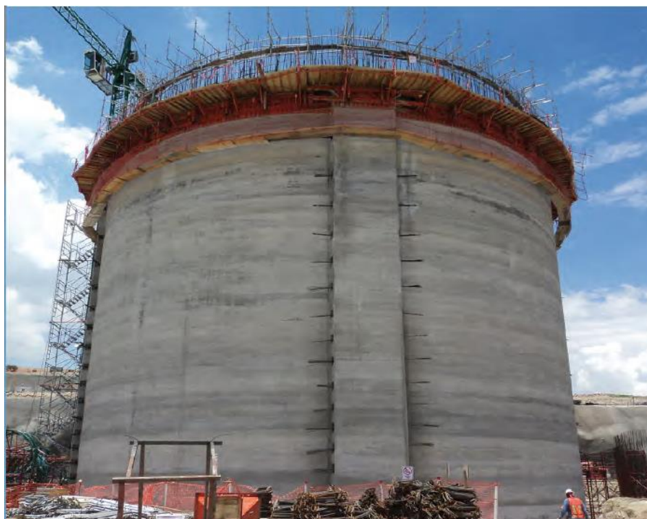
ILUSTRACIÓN 44 TANQUE DIGESTOR EN PROCESO DE CONSTRUCCIÓN DE MUROS. (CONAGUA, COMISIÓN NACIONAL DEL AGUA, 2010)
