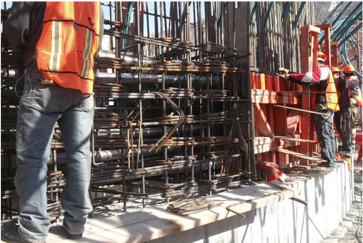
ILUSTRACIÓN 39 COLOCACIÓN DEL MOLDE DE CIMBRA PARA MURO
