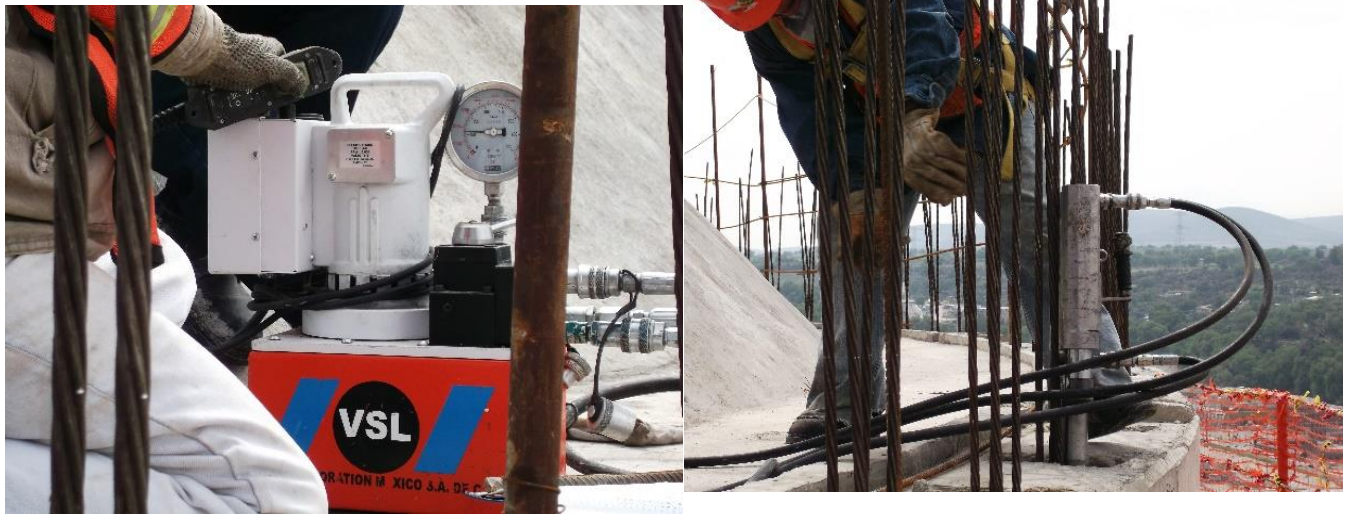
ILUSTRACIÓN 52 EQUIPO APLICÁNDOLE TENSIÓN EN CABLES TORONES VERTICALES
