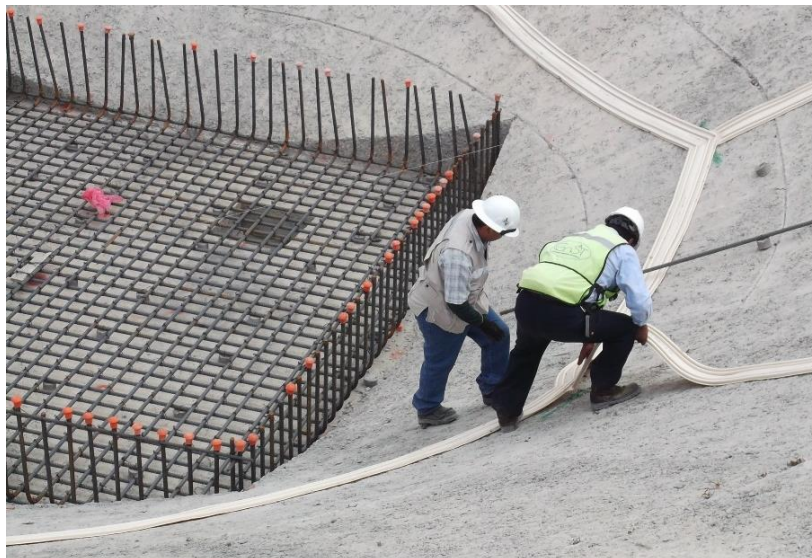
ILUSTRACIÓN 26 REVISIÓN E INSPECCIÓN DE LA CIMENTACIÓN Y LA BANDA DE PVC
