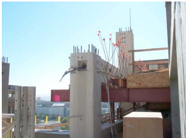
Figura 1.8 Edificio prefabricado y postensado.
