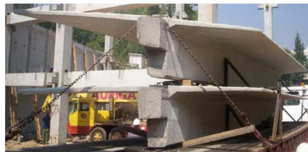
Figura 1.16 Sistemas de piso a base de losas T o TT.
