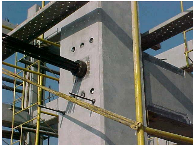
Figura 1.24 Ejemplo de conexión híbrida.
