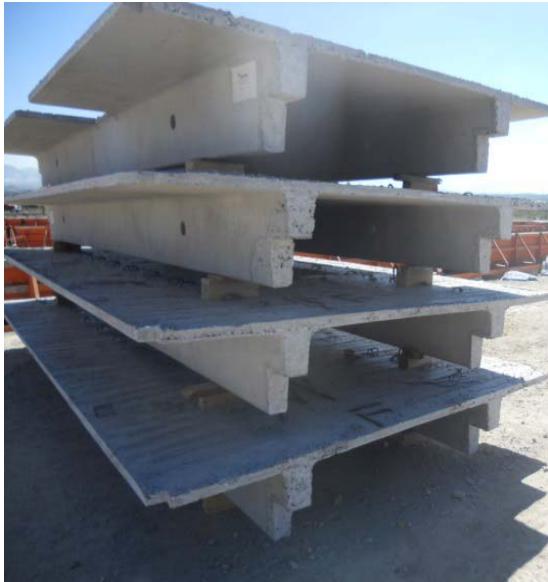
Figura 1.32 Diferentes maneras de almacenar los elementos prefabricados.
