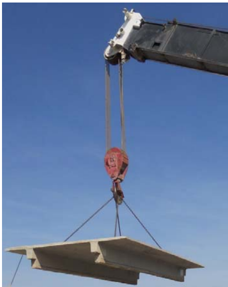
Figura 1.31 Diferentes maneras de izar los elementos prefabricados.
