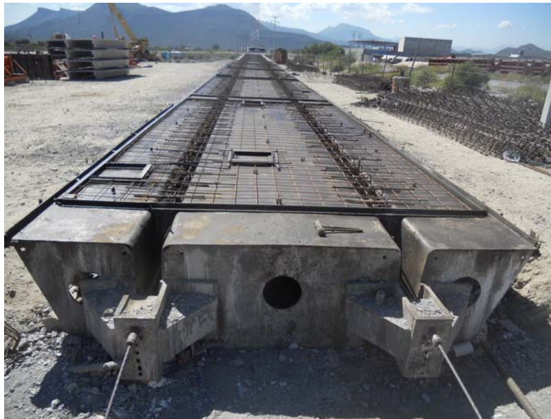
Figura 1.5 Prefabricados con acero de refuerzo simple y presfuerzo.
