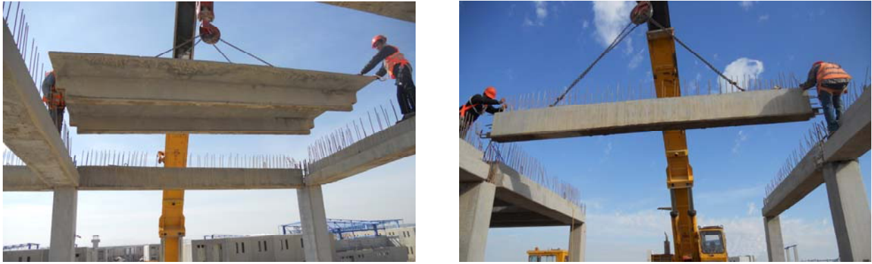
Figura 1.34 Montaje de elementos prefabricados.
