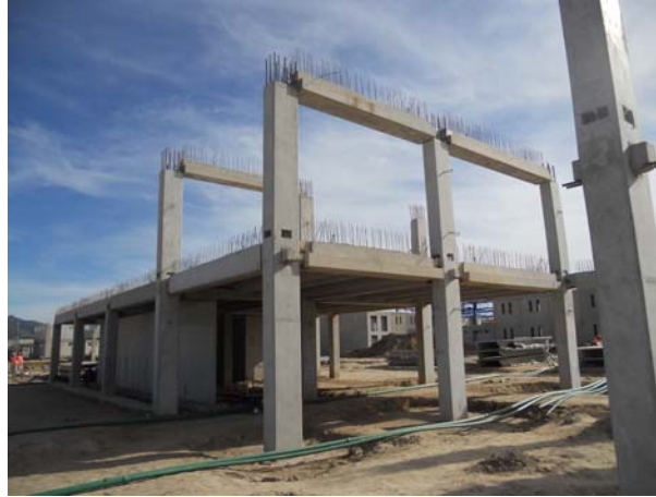
Figura 1.7 Edificio prefabricado con acero de refuerzo simple.
