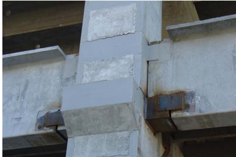
Figura 1.23 Ejemplo de conexión seca.
