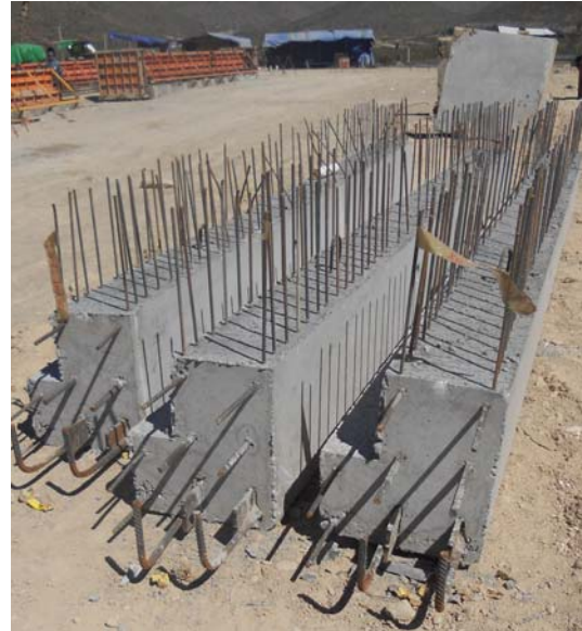
Figura 1.32 Diferentes maneras de almacenar los elementos prefabricados.
