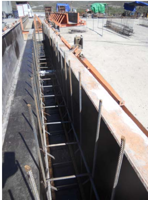
Figura 1.4 Prefabricados con acero de refuerzo simple.
