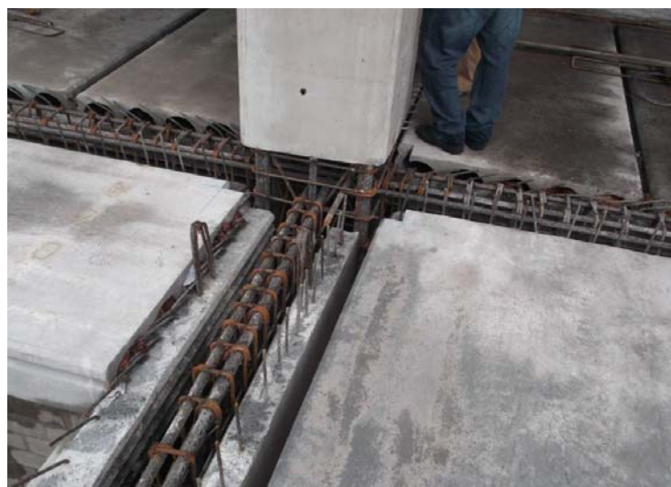
Figura 1.22 Ejemplo de conexión húmeda.
