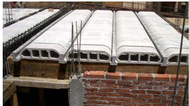
Figura 1.14 Sistema de piso a base de vigueta y bovedilla.
