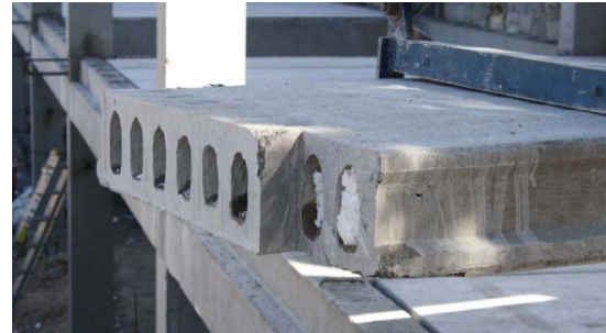
Figura 1.15 Sistema de piso a base de losa alveolar o extruida.
