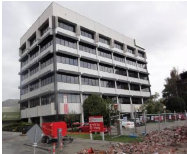
Fig 2.51 Edificio cimentado sobre pilotes con marcado asentamiento diferencial (GEER Association, 2011a)
