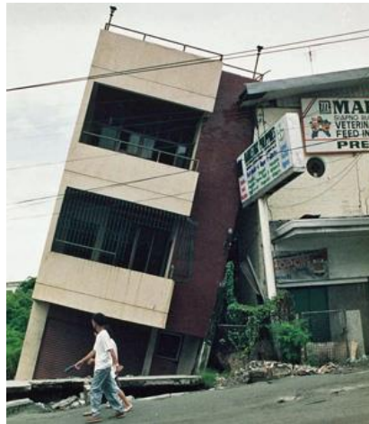
Fig 2.7 Edificio inclinado en Dagupan, Filipinas (Engineering Geology Ltd, 2015)
