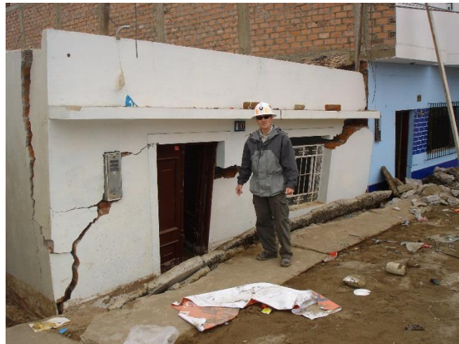
Fig 2.29 a) Casa de un nivel con asentamiento de cerca de 90 cm en la calle Alfonso Ugarte, b) asentamiento de 80 cm, se observa gran cantidad de arena que emergió y se coló adentro de la casa, c) casa con daño estructural y asentamiento de 70 cm en Tambo de Mora (GEER Association, 2007)
