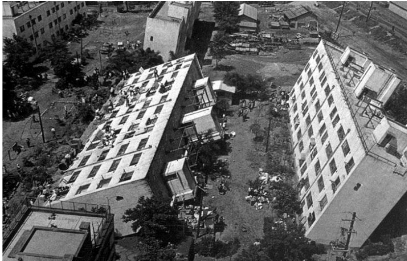
Fig 2.2 Volteo y asentamiento de departamentos en Kawagishi-cho (Abo, 2012)
