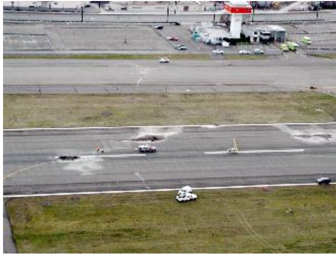
Fig 2.21 Vista aérea del extenso daño ocasionado, sobre la pista se observan fisuras y arena que emergió (Pacific Earthquake Engineering Research Center-PEER, 2015)
