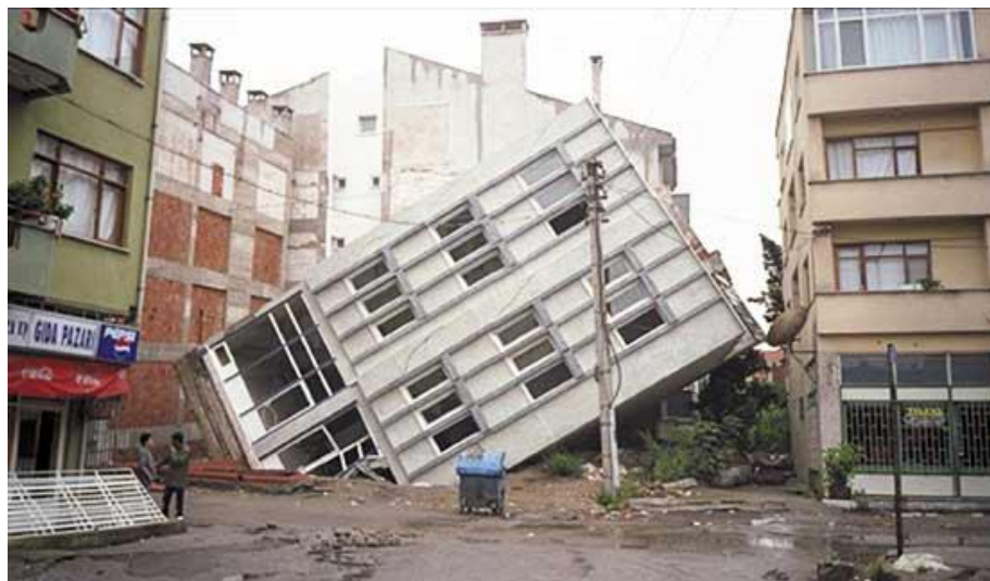
Fig 2.19 Edificio volcado en Adapazari (USGS, 2000)
