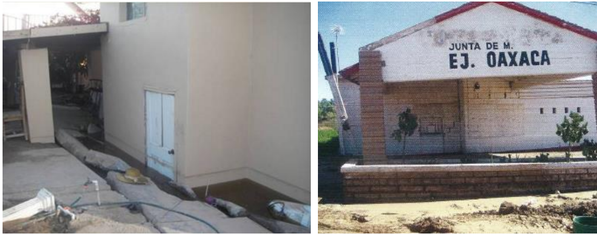
(a) (b) Fig 2.39 a) Vivienda con asentamiento uniforme de cerca de 1 m (GEER Association, 2010b) b) inmueble en el valle de Mexicali asentado por licuación del suelo (Jaimes et al. , 2010)
