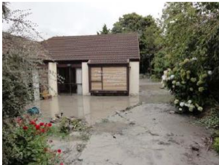
Fig 2.47 Casa en Kaiapoi con asentamiento de 40 cm producto de la licuación del suelo, a su alrededor se observa gran cantidad de material eyectado (GEER Association, 2011a)
