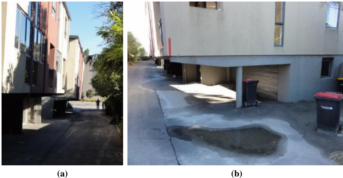
Fig 2.48 a) Asentamiento e inclinación en edificio de tres niveles, b) material eyectado producto de la licuación del suelo inducida por el sismo (GEER Association, 2011a)
