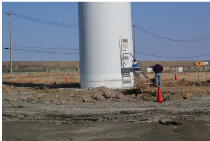
Fig 2.56 Turbina eólica con inclinación de 1.6^\circ (GEER Association, 2011b)
