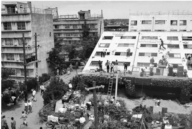
Fig 2.3 Edificio sin daño en superestructura, volcado a causa de la licuación (Syracuse Media Group, 2015)
