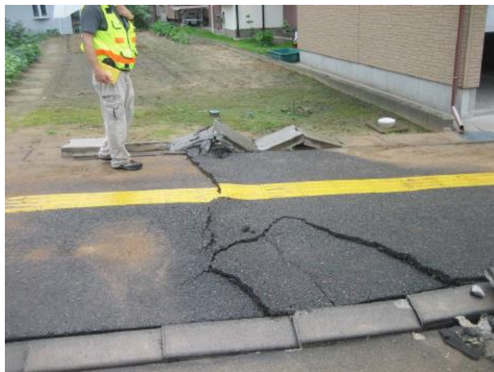
Fig 2.24 a) Alcantarilla que sobresale, a su alrededor el suelo presentó licuación, b) camino afectado debido al desplazamiento lateral del suelo (USGS, 2007)
