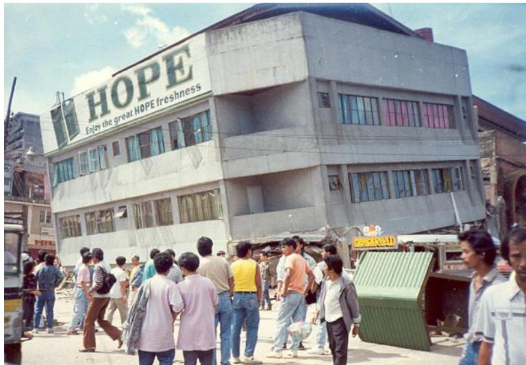
Fig 2.9 Edificio de tres niveles con asentamiento diferencial, Baguio, Filipinas (The City of Baguio, 2003)
