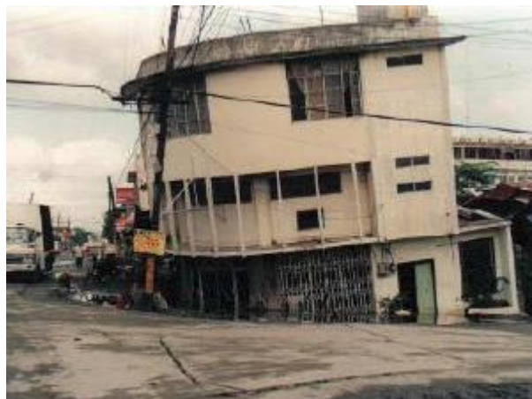
Fig 2.6 Asentamiento e inclinación de edificio en Boulevard Pérez (Orense, 2011)
