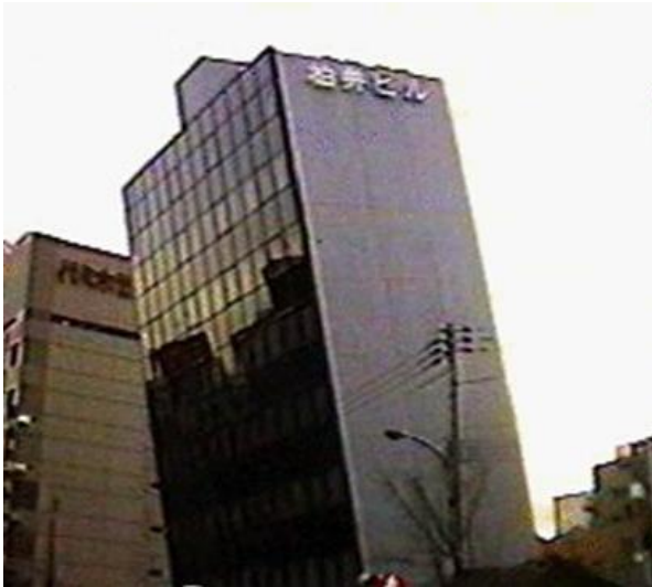
Fig 2.13 Edificio inclinado por falla del suelo a causa de licuación (Braile, 2003)
