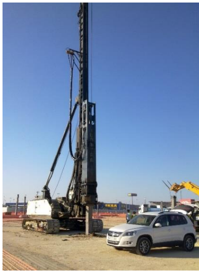
Fig 3.4 Hincado de pilotes prefabricados (CFT & Asociados S.L., 2013)
