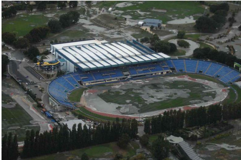
Fig 1.6 Vista aérea de un estadio en Christchurch con evidente manifestación de licuación (National Centers for Environmental Information (NCEI), 2015)
