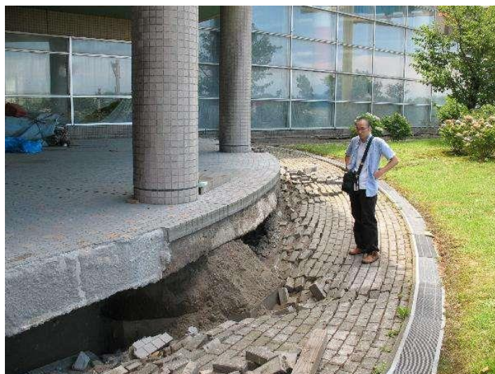
Fig 2.27 Edificio con leve inclinación y presencia de licuación en terreno adyacente (Global Risk Miyamoto, 2007)
