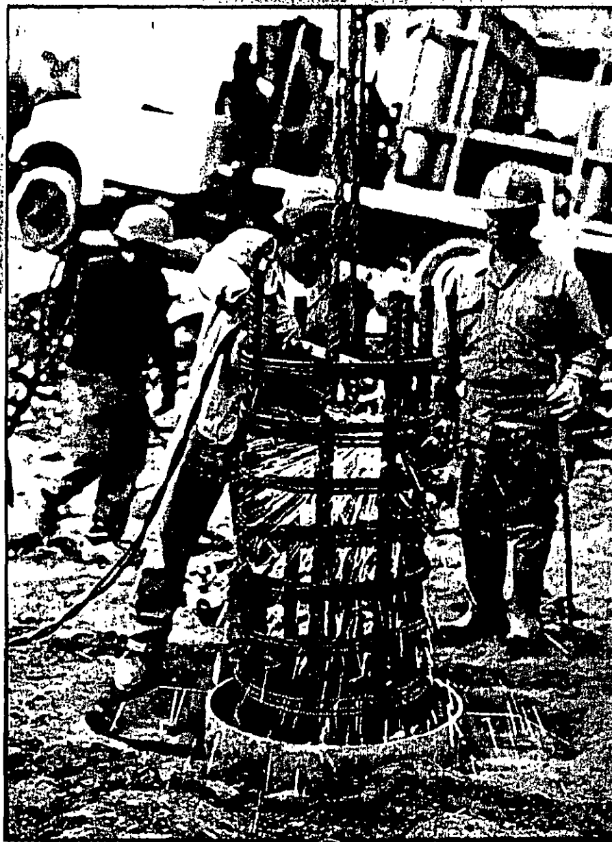
COLOCACION DE ARMADO DE PILA
