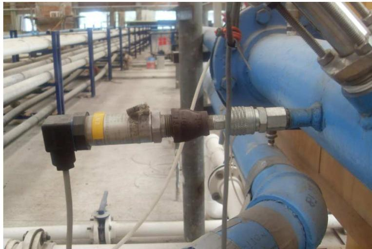
Figura 2.10: Sensor de presión piezo-resistivo ensamblado en la tubería
