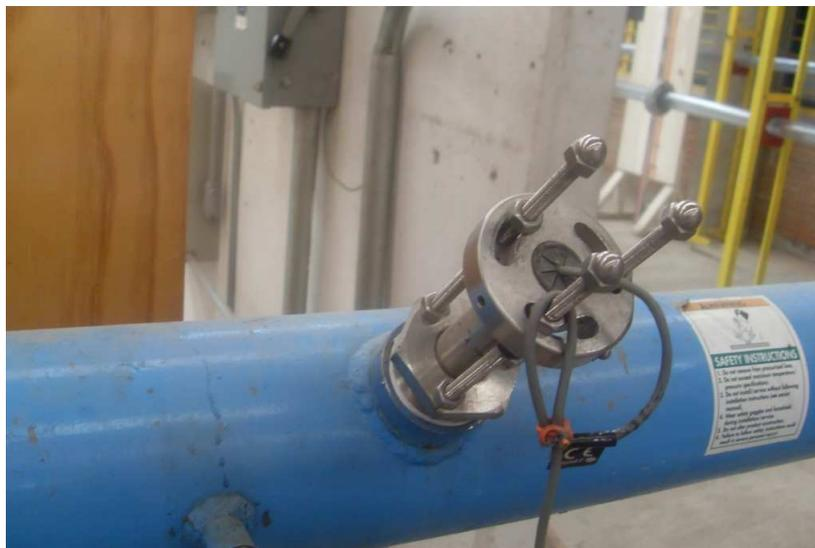
Figura 2.9: Sensor de flujo tipo propela ensamblado en la tubería
