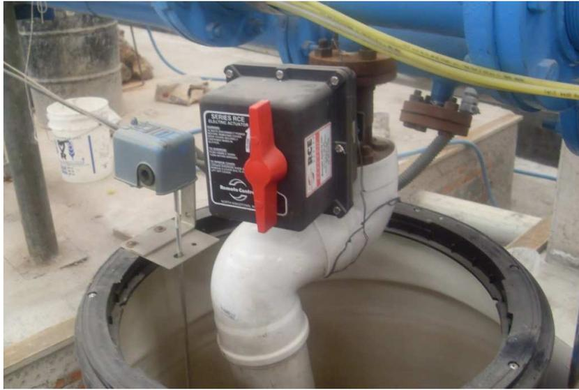
Figura 2.7: Servo-válvula
