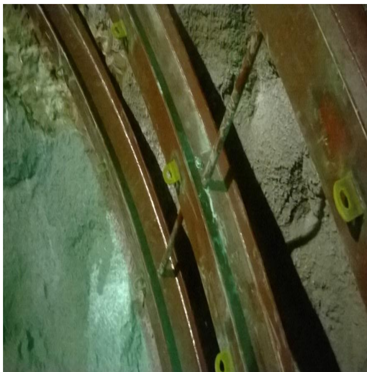
Figura 37. Colocación de tensores entre marcos (CONAGUA, 2015).
