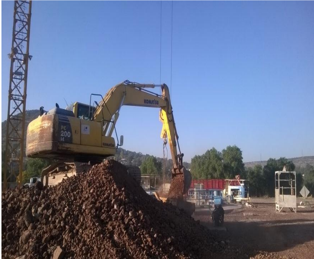
Figura 30. Material de relleno de fondo de la lumbrera (CONAGUA, 2015).
