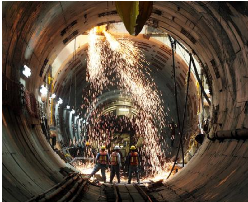
Figura 13. Túnel Emisor Oriente.
