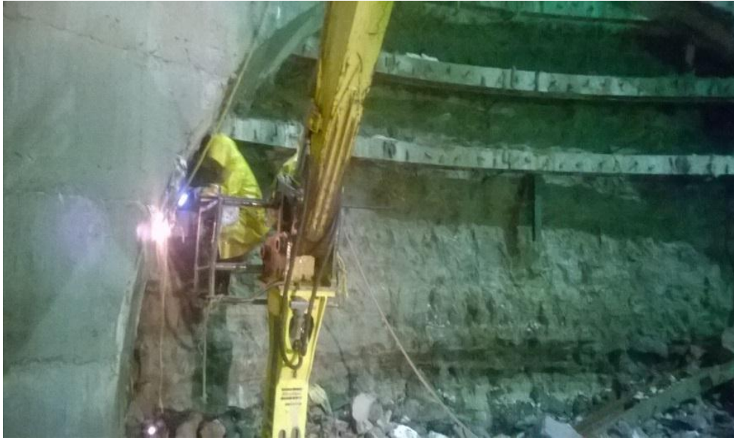
Figura 31. Demolición del revestimiento primario de la media sección superior (anillos metálicos y concreto) (CONAGUA, 2015).
