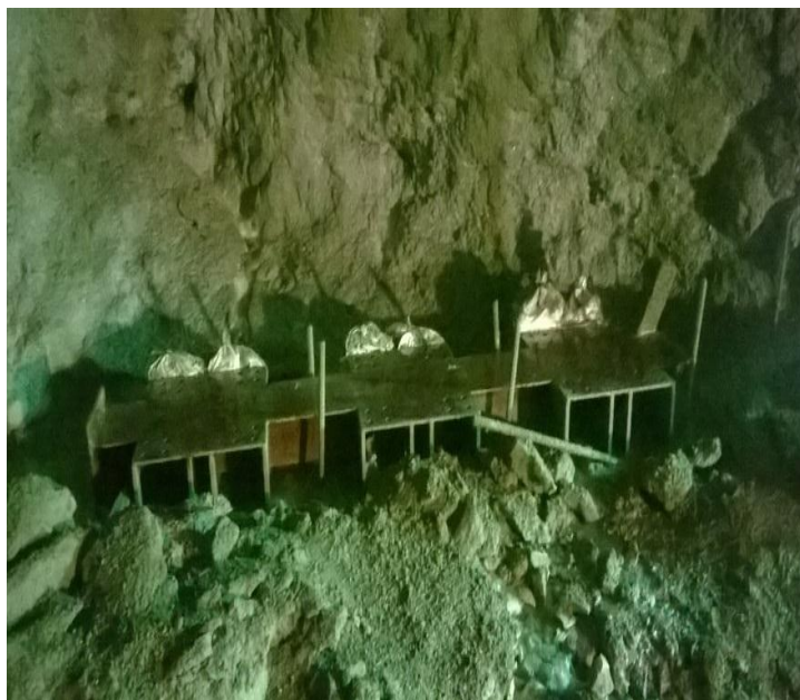
Figura 33. Viga rastra (CONAGUA, 2015).
