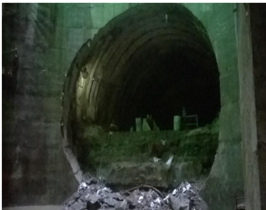
Figura 40. Demolición del revestimiento primario de la media sección inferior (CONAGUA, 2015).
