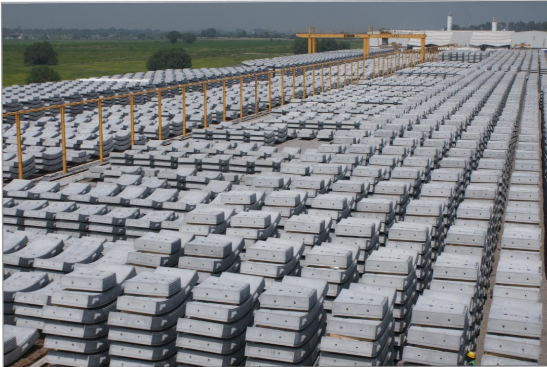
Figura 14. Patio de almacenaje de dovelas (CONAGUA, 2010).
