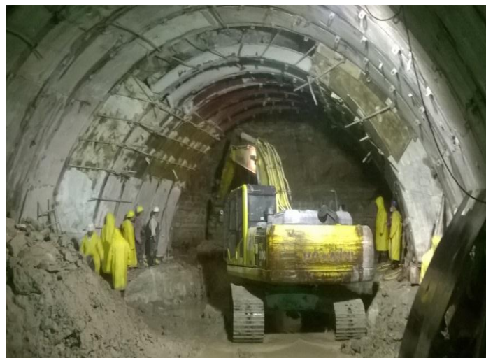
Figura 39. Etapas subsecuentes de excavación y revestimiento (CONAGUA, 2015).
