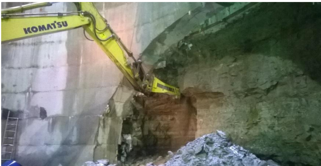
Figura 32. Excavación de coyoterías (CONAGUA, 2015).
