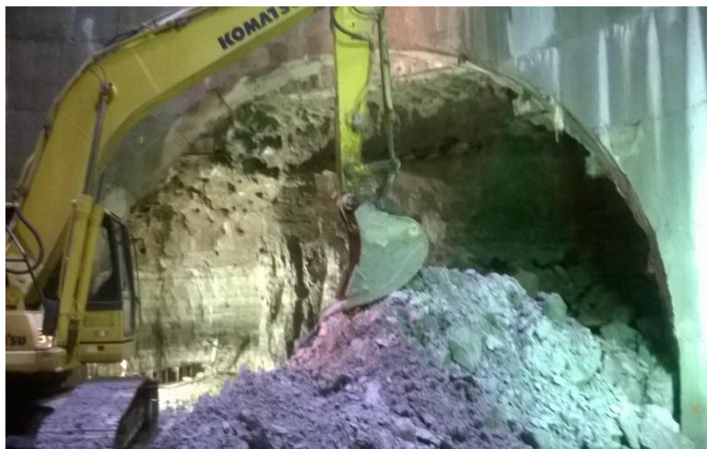
Figura 36. Excavación de la media sección superior (CONAGUA, 2015).
