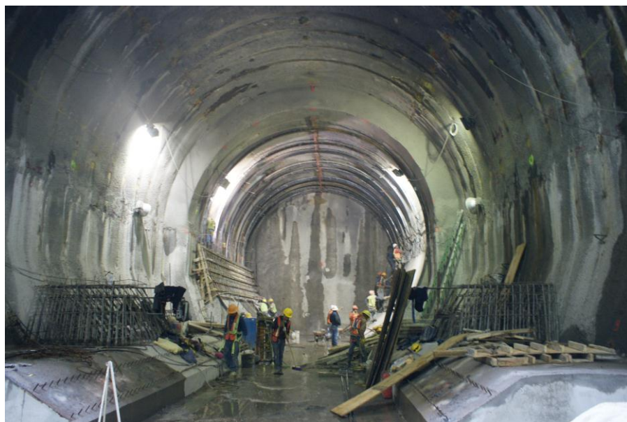
Figura 27. Galería de montaje (CONAGUA, 2011).
