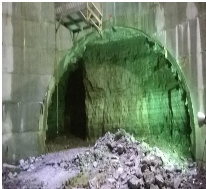
Figura 34. Excavación para la colocación del primer marco metálico (CONAGUA, 2015).
