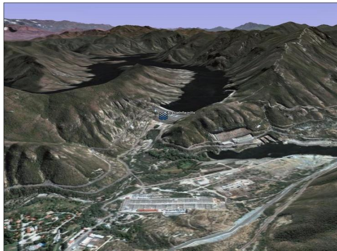
Figura 2.6. Vista de la presa Infiernillo
