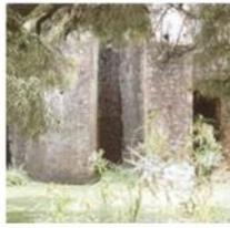
Hay fugas o filtraciones por la mampostería de la cortina, en diversos sitios, y se forma una ciénega al pie del paramento aguas abajo
