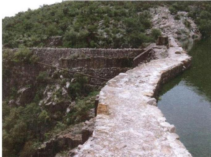
Figura 6.6. La cortina tiene un eje serpenteante
